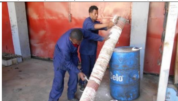
機材メンテナンスチーム強化： 掘削機械のサクションホースの修復 (2019 年 10 月 22～11 月 8 日、EWTI)
