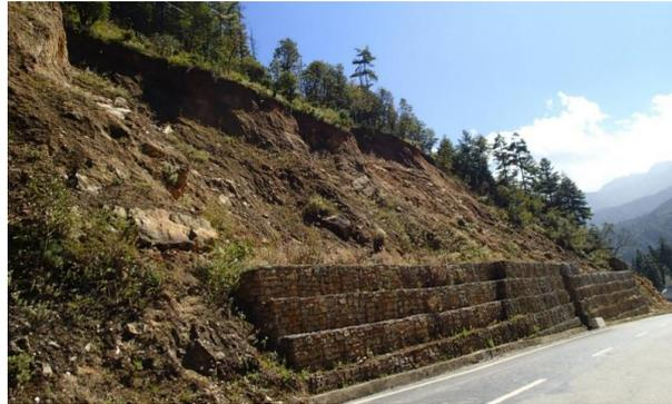
写真 3.5-1 補強土壁落石防護壁完成状況 (2020/11/5, 出典:JET)
