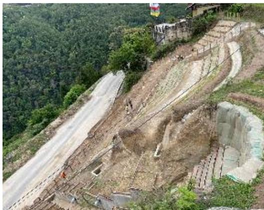
図 3.3-12 植生工施工完了(2023.年5月3日)
