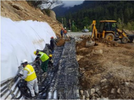
成果4：落石対策工施工の様子(2020/4/7)
