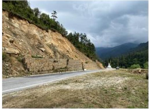
成果4：落石対策工の完成(2020/7/8)
