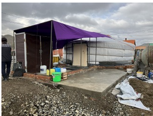
ガス暖房装置導入ゲル（床暖房式） 伝統的ゲルにガス給湯施設を別棟で連結
