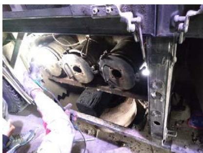
DPF 移設作業 2022年6月4日撮影
