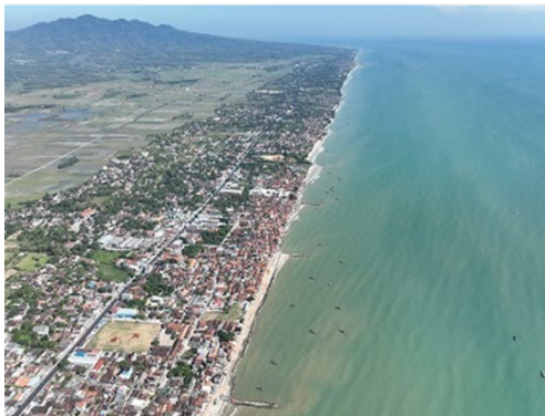
Perlindungan Pantai oleh Groyne dan Revetment
