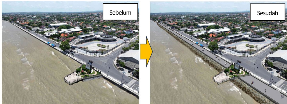
Gambar 4.4 Ilustrasi sebelum dan sesudah implementasi revetmen tipe-1 (T-b)
