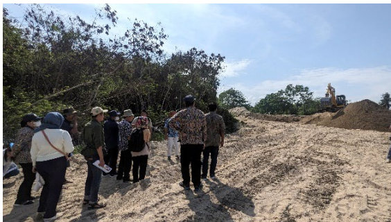
Pantai Nusa Dua (Kunjungan lapangan Lokasi konstruksi Bali Beach Conservation Project )
