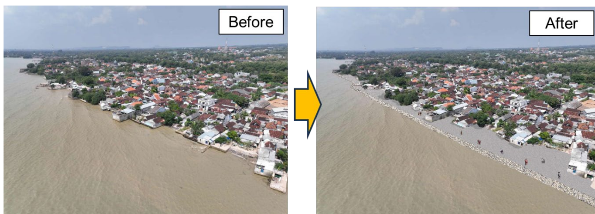
Gambar 13.3.15 Ilustrasi Sebelum dan Sesudah Implementasi Type-2 Revetment di Tuban (T-c)
