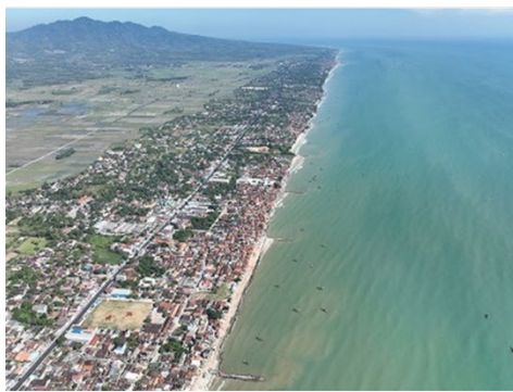
護岸と突堤による海岸防護
