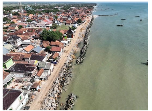
BBWSにより実施中の護岸対策
