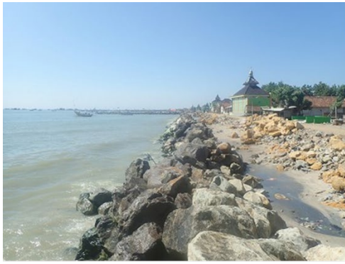
BBWSにより実施中の護岸対策
