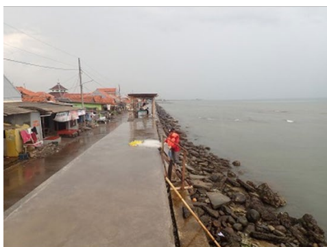
州政府による天端の高上げ
