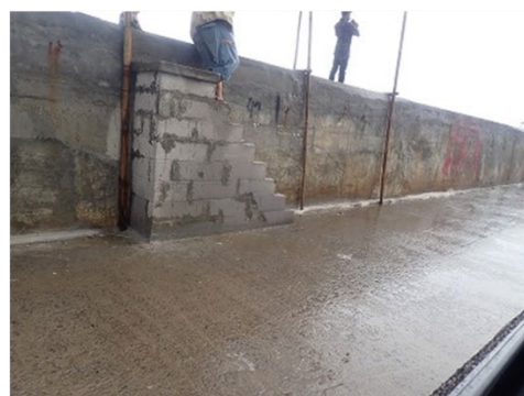
州政府による天端の高上げ
