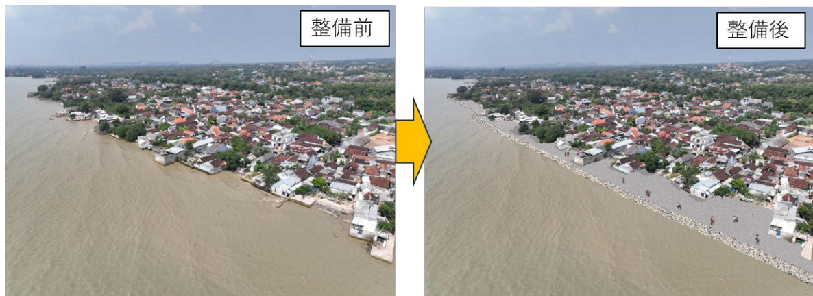
図 4.4 親水型護岸（面的防護）Type-1 の整備前後のイメージ（T-b）
