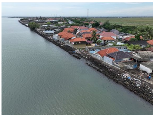
捨石堤による居住地の防護状況
