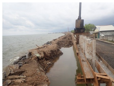
州政府による護岸改良工事
