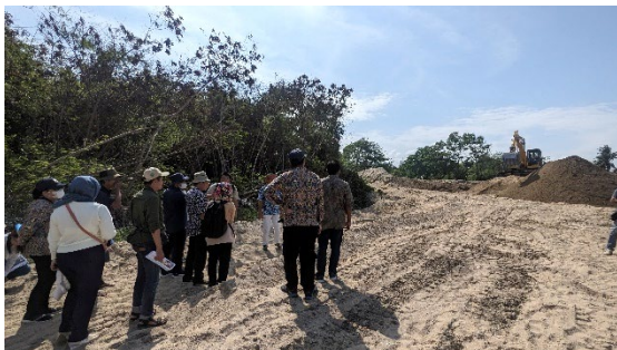
ヌサドゥア海岸 (バリ海岸保全事業の施工現場の視察)
