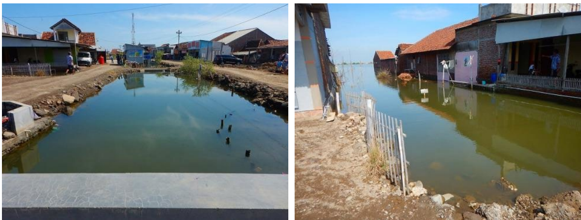
写真5 護岸状況（左）と護岸の嵩上げの状況（右）
