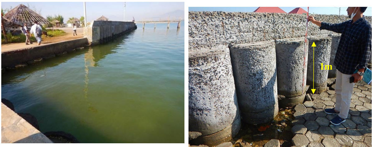
写真3 護岸状況（左）と護岸の嵩上げの状況（右）
