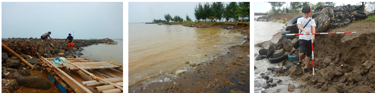
石積みの防波堤天端高は海面上約1.2m
