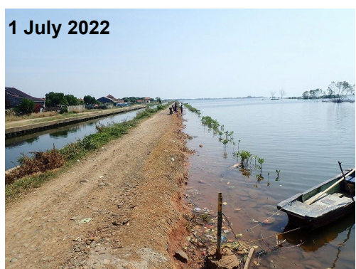
Tidal Flood 対策としての防潮堤 (上図、P2 地点)
