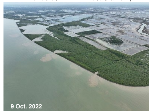
マングローブ+護岸による面的防護対策(P4)
