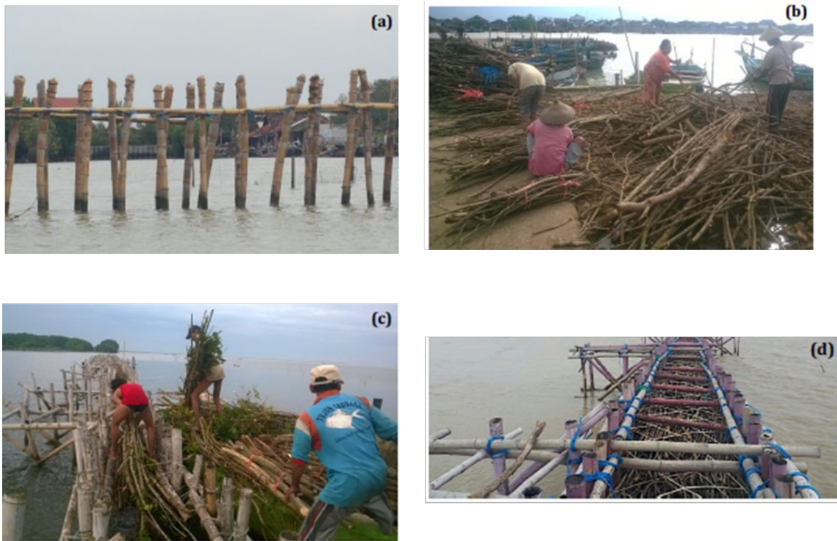
図 2.7.7 Hybrid Engineering (HE) 工法による透過性ダムの設置状況 (1)
