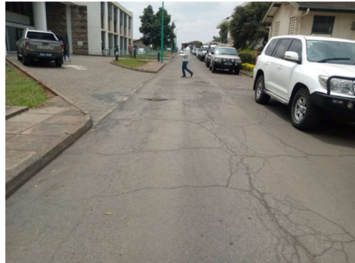
写真4 エントランスゲートから建設予定地までの路面状況。路面にクラックはあるものの、資機材の運搬に支障はない。
