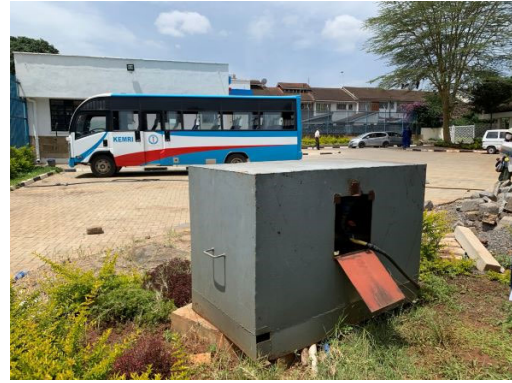
写真 20 エントランスゲート脇の駐車場に設置された井戸ポンプ。現施設の給水は市水を利用しているが、供給が不安定なため井戸も利用している。
