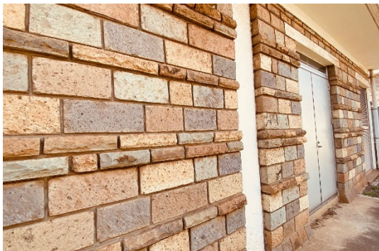
写真 17 2005 年 JICA 無償にて整備された建物の内外装は統一してナイロビストーンのはつり仕上げが使用されている。現地で安価に入手でき、主要な壁材料として一般的に用いられている。
