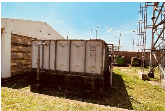
写真 21 2005 年に JICA 無償にて整備された受水槽。市水と井水を合わせて受水槽に貯水している。6 面点検可能なスペースが設けられている。
