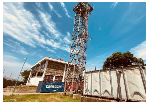
写真 22 受水槽に隣接する高架水槽。こちらも 2005 年に JICA 無償にて整備され、受水槽からポンプアップした後、各棟に給水している。
