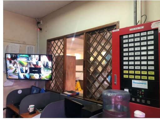
写真 14 事務管理棟のエントランスに位置する管理入室。監視モニターと鍵貸し出しの管理が行われ、総合監視盤が設置されている。
