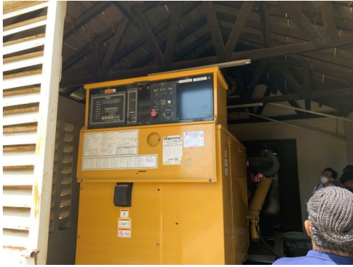
写真 19 電気室内に設置されている非常用発電機。KEMRI には 2 台のディーゼル発電機と燃料タンクが設置されており、機械に記載された記録より定期的なメンテナンスの実施が確認された。
