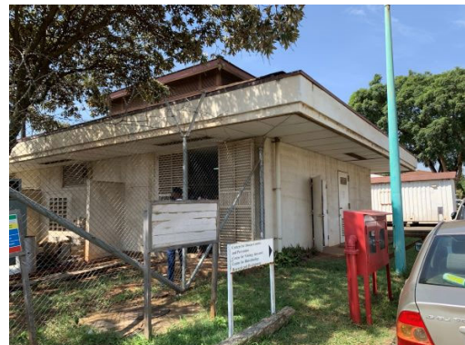
写真 18 KEMRI の敷地南部に位置する 1985 年に JICA 無償にて建設された電気室。受変電設備、変圧器、非常用発電機、燃料タンク等が設置されている。
