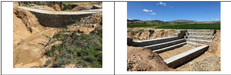
Figure 18-22 Cas des mesures de prévention de l'érosion contre l'érosion des ravins en amont de oued Siliana
