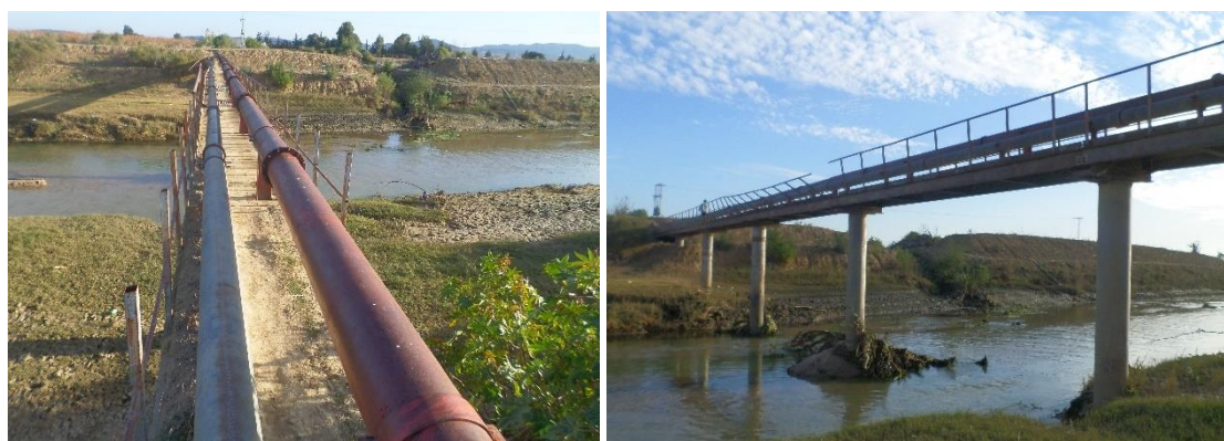
図 16-8 水管橋 AD002 の現況
