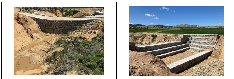
図 18-22 シリアナ川上流で実施されたガリー侵食対策の事例
