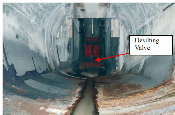
図 9-7 既設排砂施設の水路部の状況（2017 年時点）
