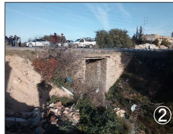
既設カルバートの様子
