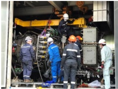
GT 取外し作業
