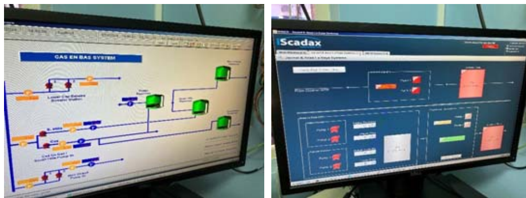
図 3-24 WASCO 本部に設置された SCADA システム
