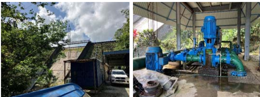
図 3-19 ジョン・コンプトンダムの外観および低水位時に用いるポンプ設備
