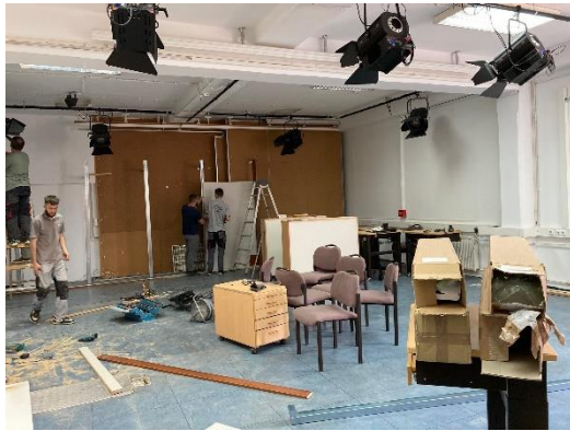
プリズレン支局工事の様子
