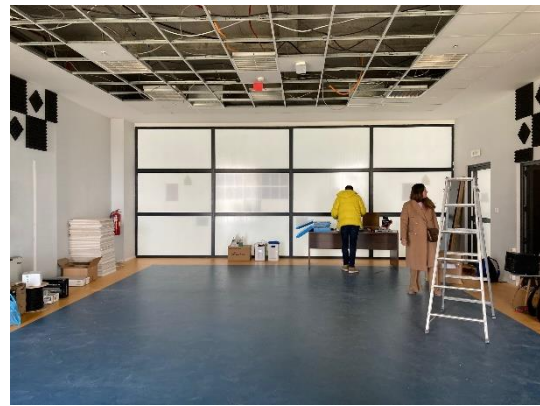
ミトロビツァ支局工事の様子
