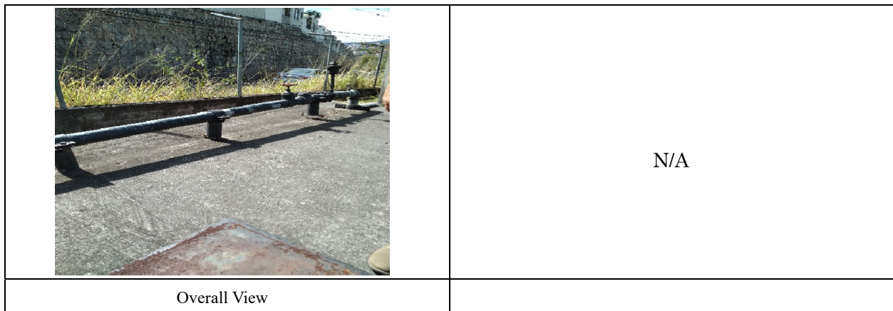
Figure 3.3.19 Current Situation of 19 de Septiembre PS
