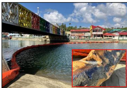
Poblacion Zone IIのオイルフェンス設置状況
