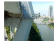
路面から桁下への通路
