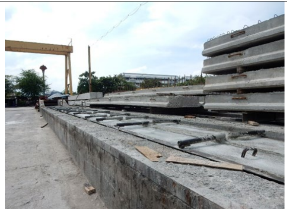
図 5.7 プレテンション桁の制作ヤード (BCRC3 敷地内)
