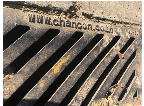
図 3.32 街路の排水呑口
