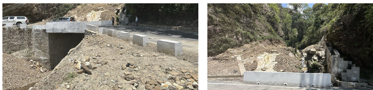
図 4.24 JICA 技術協力プロジェクトによる土石流対策工（国道1号 Wangdue-Trongsa 間） 98
