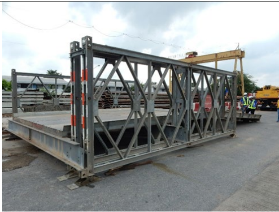
図 5.6 ベイリー橋の組立状況 (BCRC3 内)
