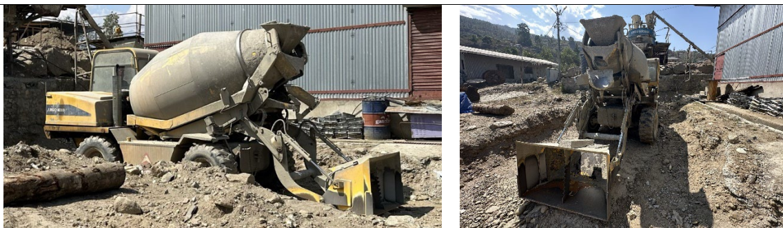
図 4.42 移動式の生コンクリート・プラントにおけるミキサー車（GOIプロジェクト） 219
