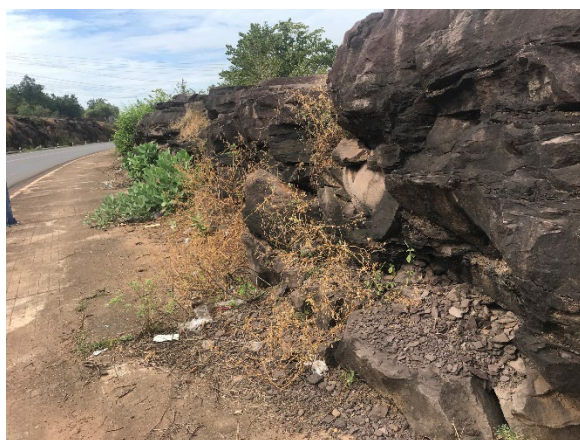
図 3.59 国道 16W 線の切土の近影
