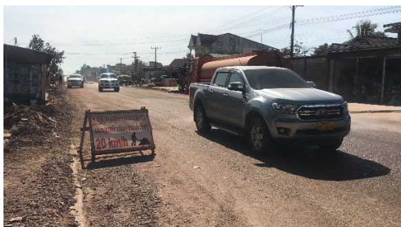
図 3.27 交通規制の状況
