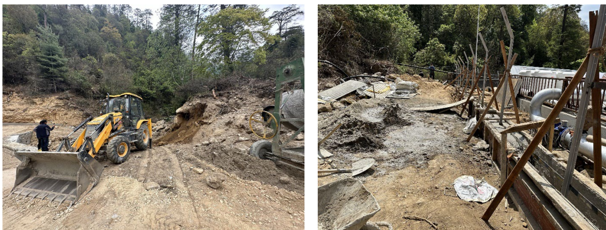
図 4.39 現場練りのコンクリートミキサーと骨材置き場（水処理施設・道路工事現場） 209
