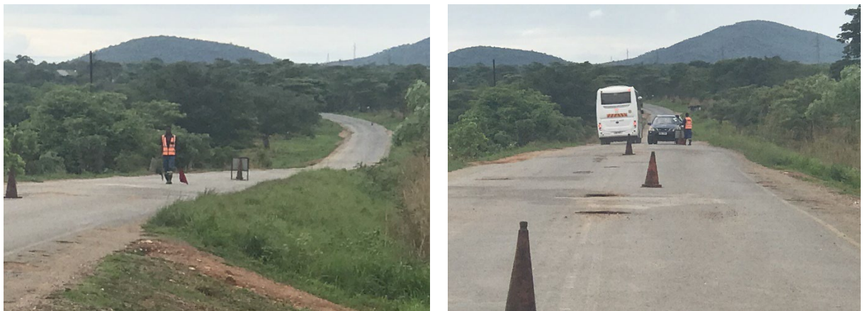
図 6.30 舗装補修時の交通規制の端に配置される誘導員 (T4:Lusaka-Rufunsa: Rufunsa 付近) 432
