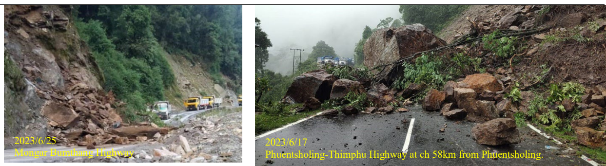
図 4.21 がけ崩れにより通行止めとなった道路 95
