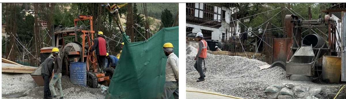
図 4.38 現場練りのコンクリートミキサーと骨材置き場（Thimphu 市内の建築現場） 208
