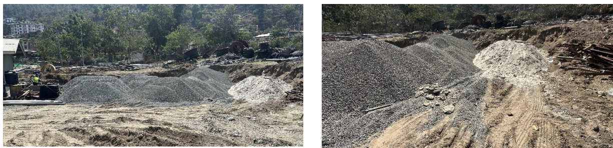
図 4.37 移動式の生コンクリート・プラントにおける骨材管理状況 (GOIプロジェクト) 207
