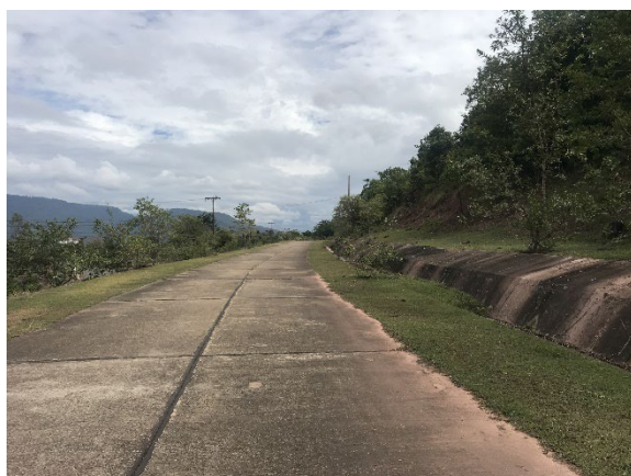
図 3.57 パクセ市内地方道の切土
