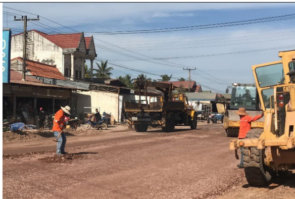
図 3.25 余剰材料の再散布
