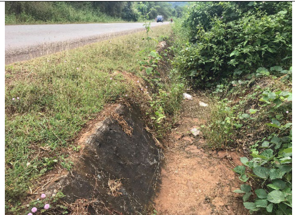
図 3.62 セコン郊外の国道 16 号線の側溝
