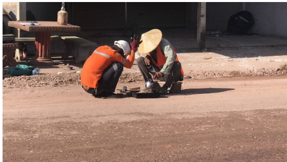
図 3.23 施工層の材料を採取する現場従事者
