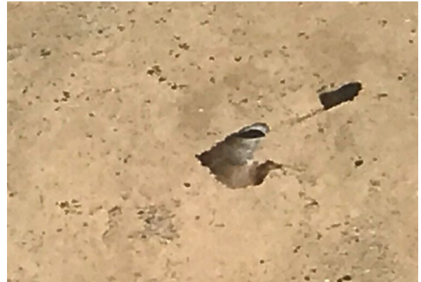
図 3.49 新設橋の橋脚表面の接写
