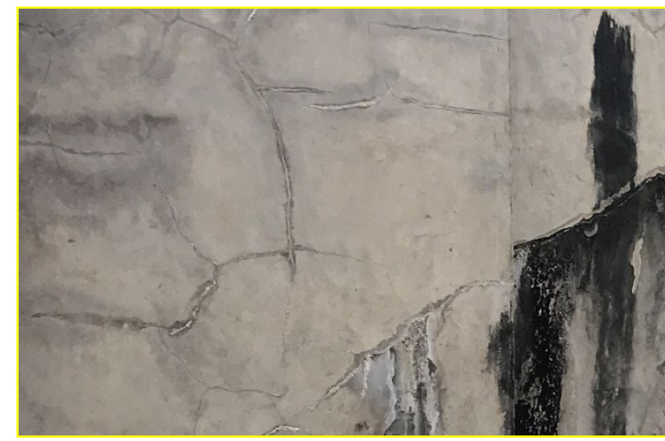
図 3.51 19 世紀末のコンクリート表面拡大
