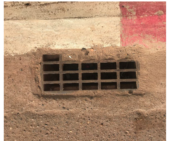
図 3.34 サバナケット空港近くの国道の排水呑口
