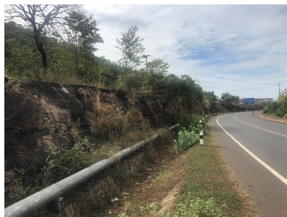
図 3.58 パクセ市内の国道 16W 線の切土
