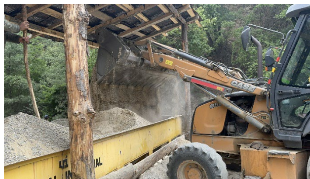
図 4.35 ホッパーへの骨材の搬入 189
