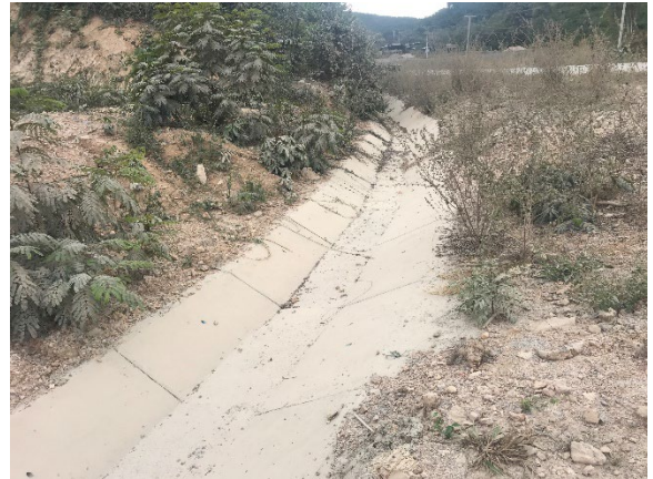
図 3.68 のり尻の排水溝
