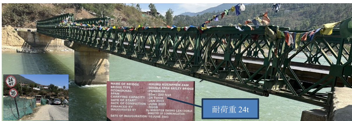
図 4.20 KHURU KUENPHEN 橋（2003 年 6 月建造、2 径間ベイリー橋） 88
