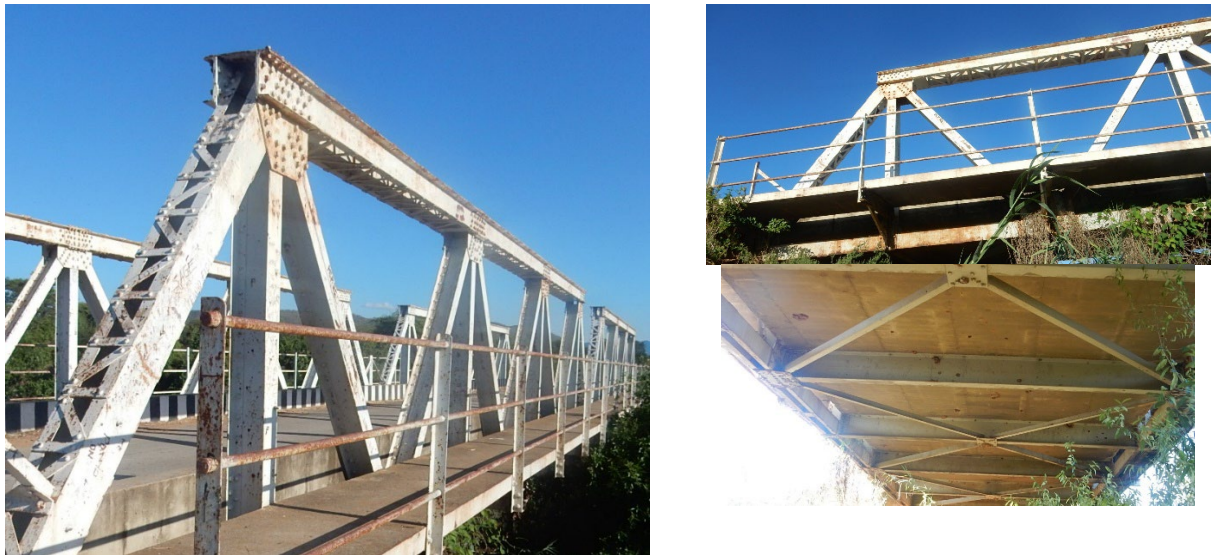
図 6.36 【参考】補修前の Rufunsa 橋 449
