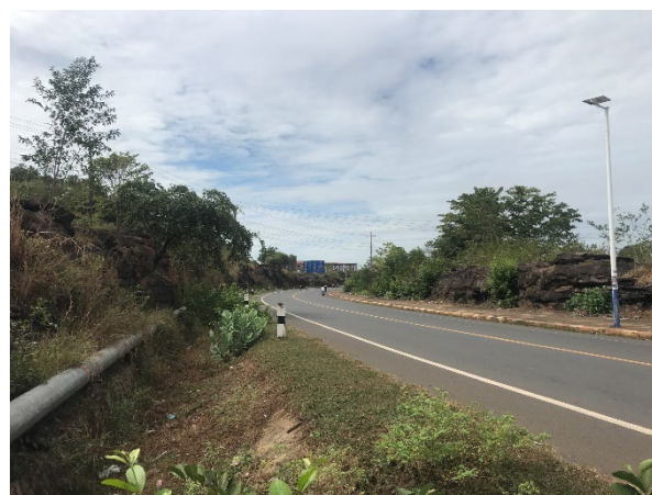
図 3.60 国道 16W 線の切土の遠景
