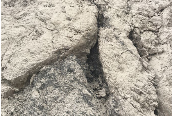
図 3.65 切土のり面近影
