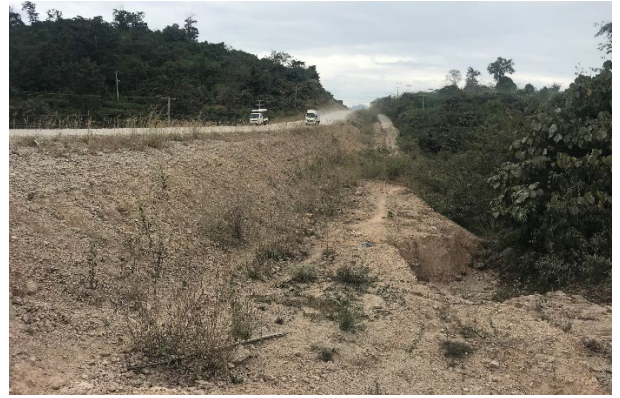
図 3.66 盛土のり面の表面被覆の状態
