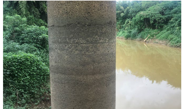
図 3.47 旧ベイリー橋の橋脚
