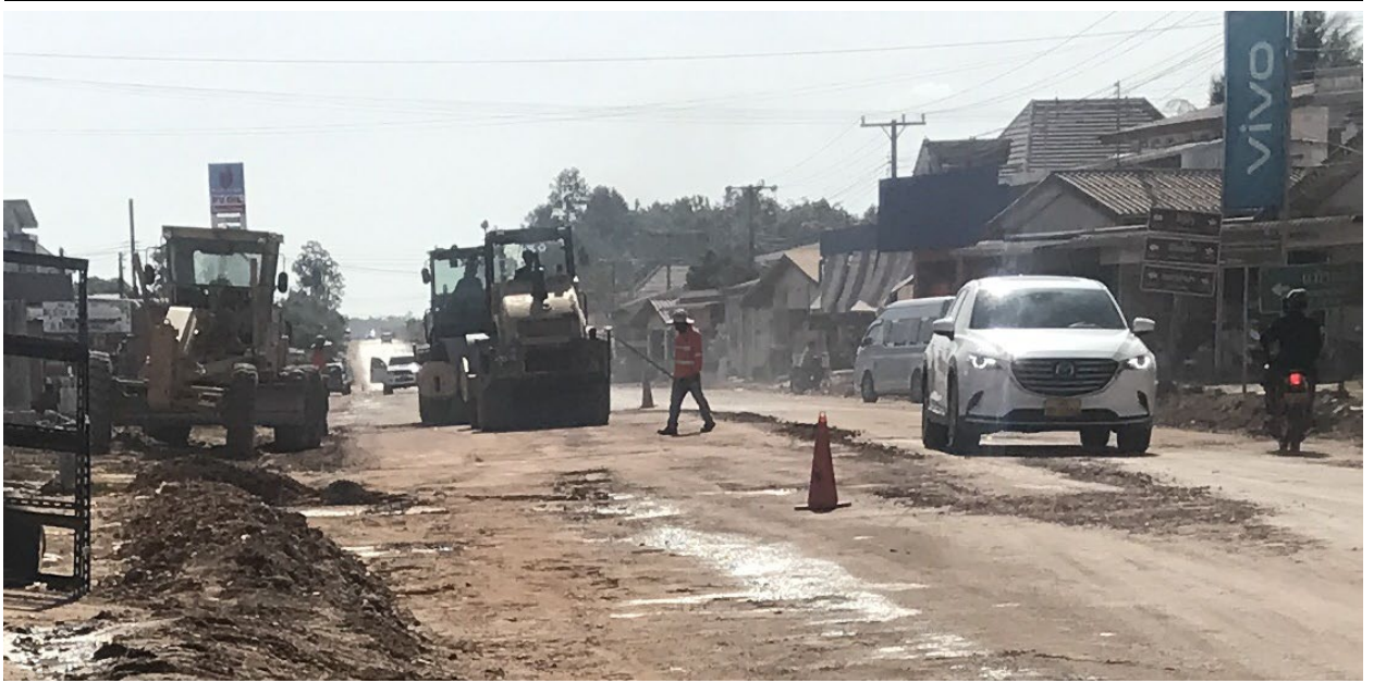
図 3.21 国道 13 線における舗装の補修 施工状況
