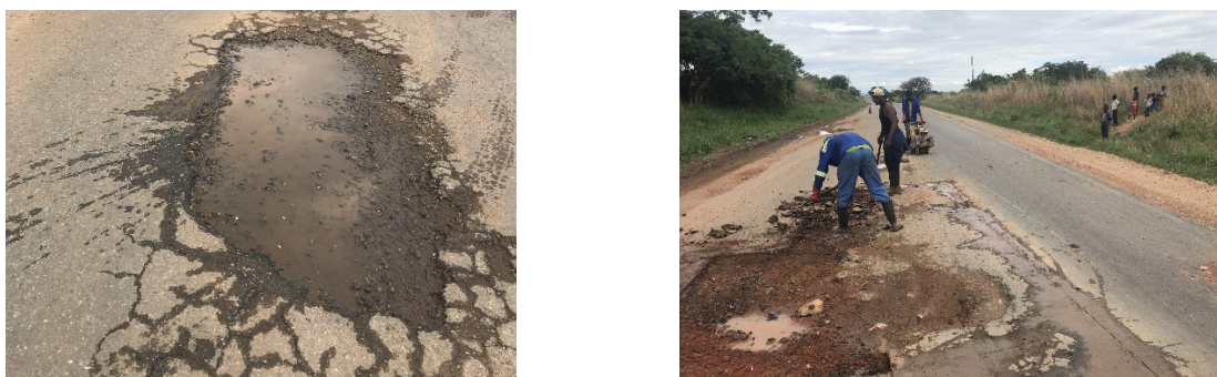
図 6.29 地域事務所の直営による小補修の実施状況 (T4:Lusaka-Rufunsa: Rufunsa Fisheries 付近) 428
