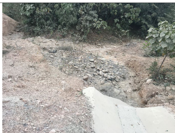
図 3.70 排水溝の流末の状態（近景）
