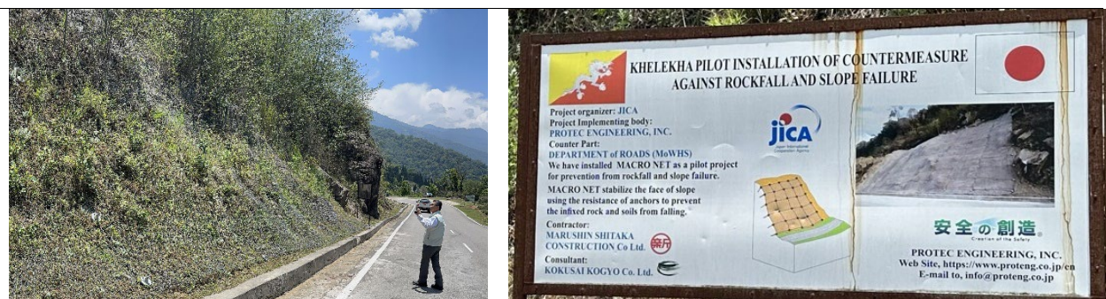
図 4.25 切土のり面保全・対策工（国道1号 Wangdue-Trongsa 間） 99
