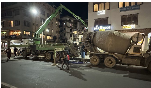
図 4.40 ポンプ車とミキサー車（Thimphu 市内の建築現場） 217
