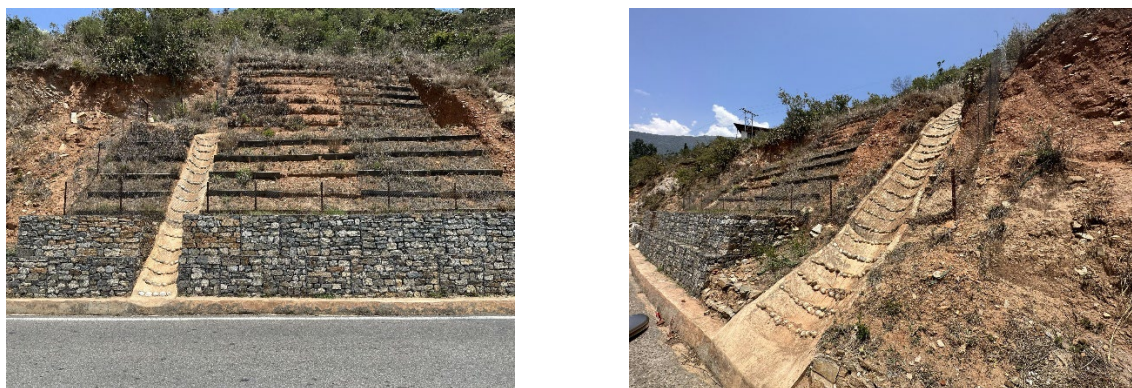
図 4.26 技術協力プロジェクトで造られた植生のり面 116
