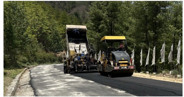
図 4.33 加熱アスファルト混合物の敷き均し直後の転圧 186
