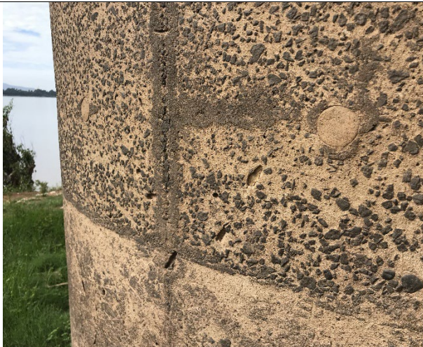
図 3.52 日ラオス友好橋の下部工
