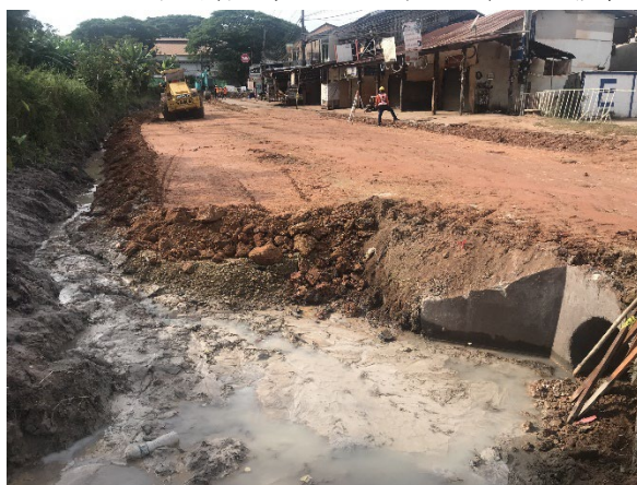
図 3.71 側溝の掘削と路床の施工状況
