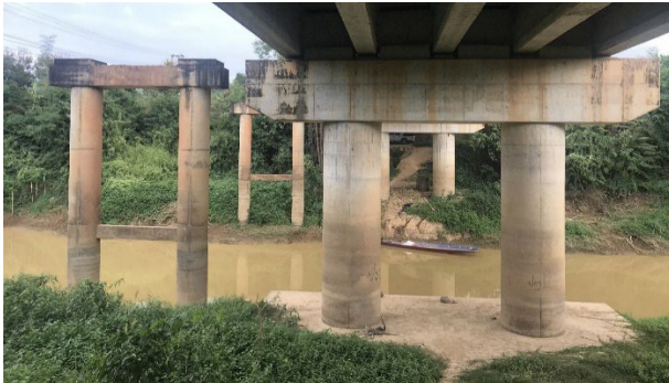
図 3.46 並立する旧ベイリー橋と新設橋
