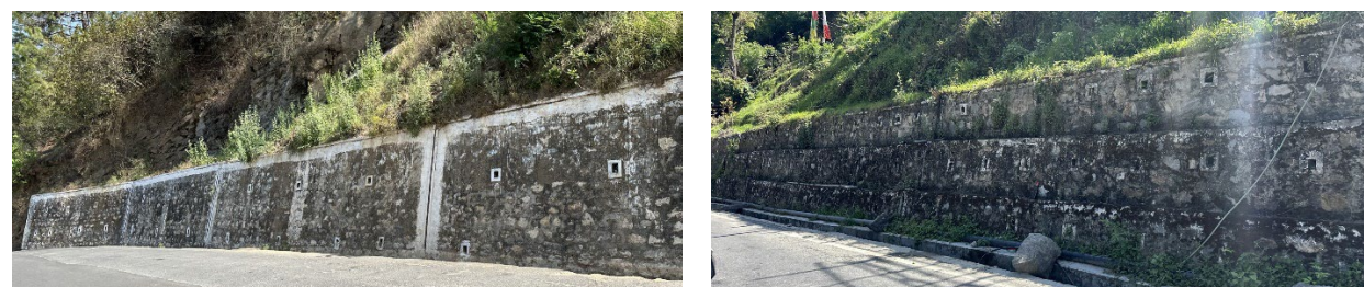
図 4.23 石積み擁壁（Lobeysa 付近） 97
