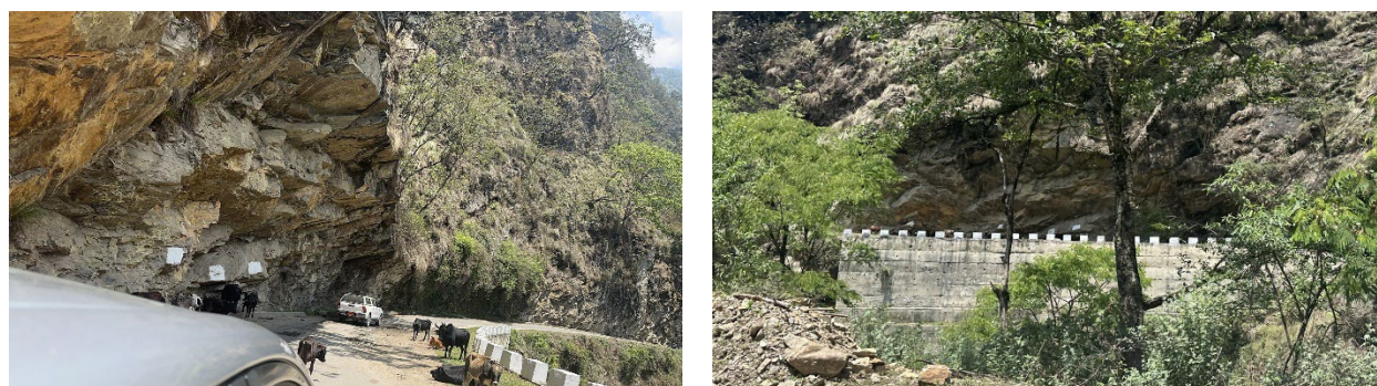
図 4.22 崖がオーバーハングする道路（国道1号 Wangdue-Trongsa 間） 96
