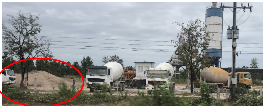
図 3.37 パクセ近郊の生コンクリート・プラント
