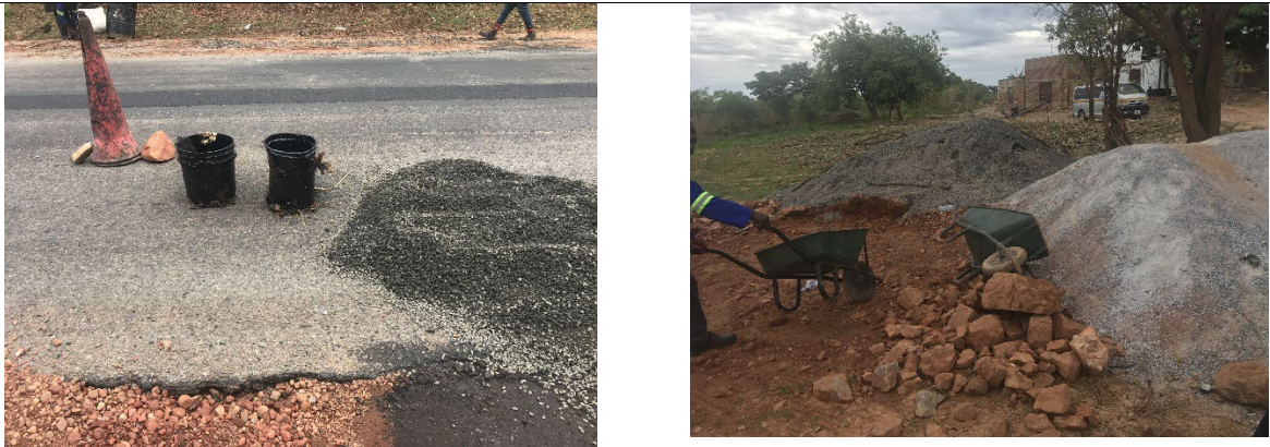
図 6.34 地域事務所の直営による小補修の実施状況 (T4:Lusaka-Rufunsa: Rufunsa 付近) 436
