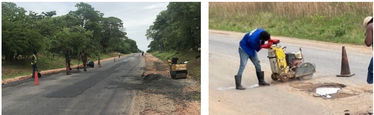
図 6.32 地域事務所の直営による小補修の実施状況 (T4:Lusaka-Rufunsa: Rufunsa 付近) 434
