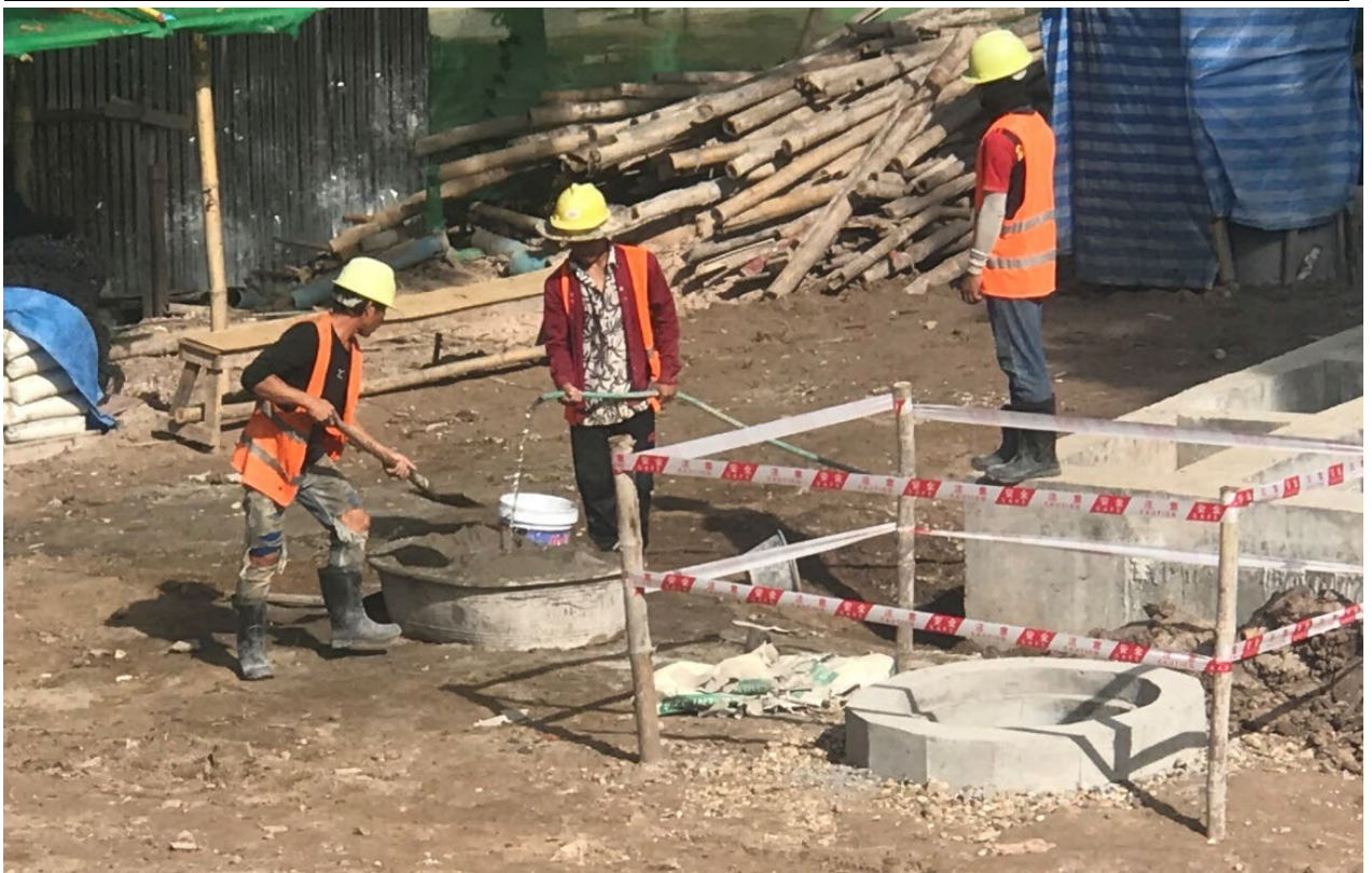
図 3.56 生コンクリートの現場配合の状況
