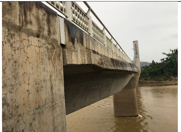
図 3.55 セコン橋の橋台からの側面景
