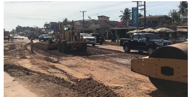
図 3.24 稼働中のモーターグレーダーとマカダムローラー
