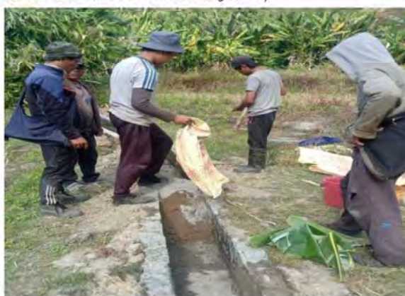
灌漑施設維持管理にかかる OJT の実施 (1)
