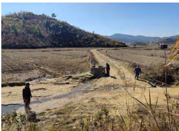
トラングサムでの灌漑工事にかかる現場確認
