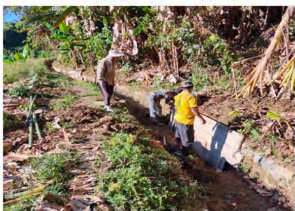
灌漑施設維持管理にかかる OJT の実施 (2)
