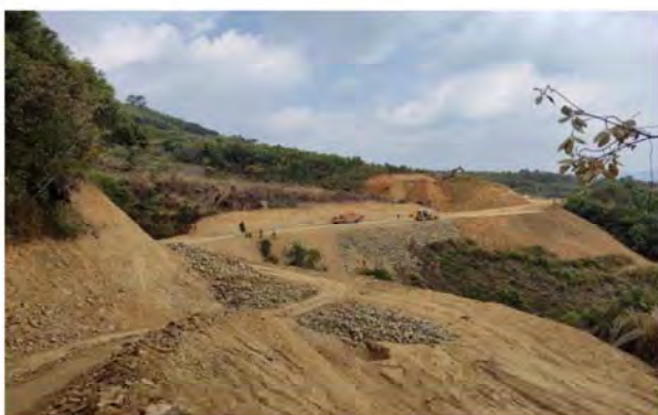
Hnahlan 村の灌漑施設の現場視察
