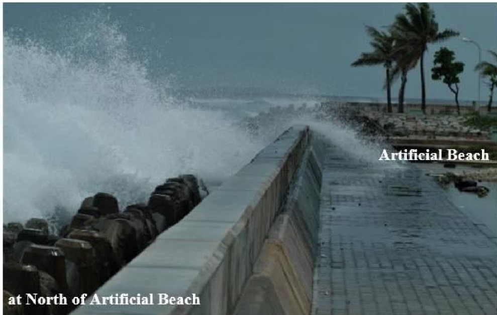
写真 D-1-6 東海岸のモスクの南側と人口ビーチの北側間の越波の大きい区域 出典：2021年12月にマレ首都圏気象災害情報収集・確認調査団撮影
