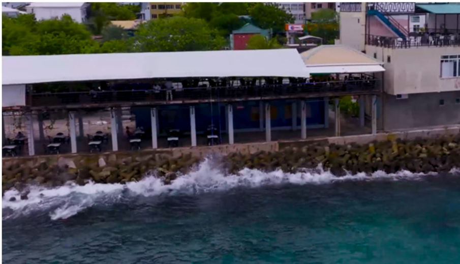
写真 D-1-8 東海岸最北端（レストラン前）の消波ブロックが30沈下している区域
