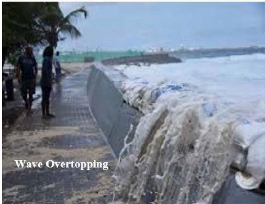
写真 D-1-4 越流時の写真 (2019年モルディブ政府撮影写真提供)
