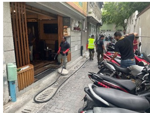
写真 2-6：MWSC既有的の高圧洗浄車を用いた管路洗浄作業の様子②
