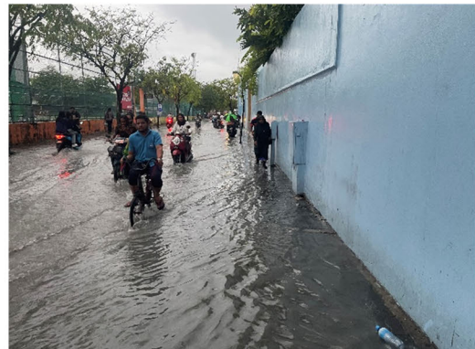
写真 1-6：降雨時の道路の浸水状況。車道及び歩道が浸水している。(Ameenee mag通②)
