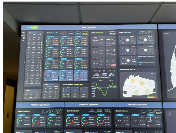
図 2-1-2 MWSC の上水道遠隔監視システム
