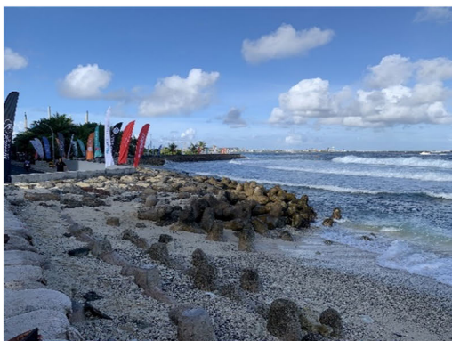
写真 1-5：A区域。消波ブロックが埋まり、防波機能が弱くなっている。
