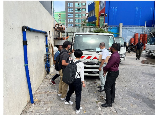
写真 2-4：既存高圧洗浄車及び壁面に設置された取水口（MWSCワークショップ）
