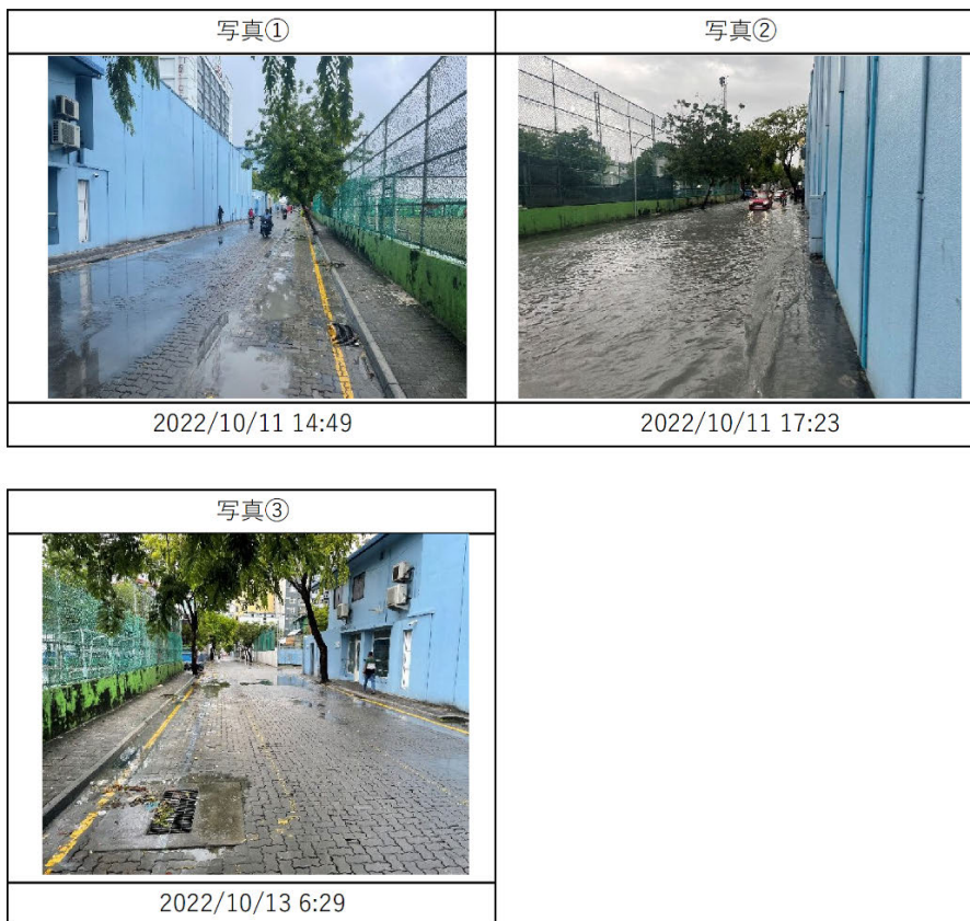
図 2-2-17 降雨量（日時）の違いによる浸水状況の比較(前述の写真 13、14 付近) 出典：JICA 調査団
