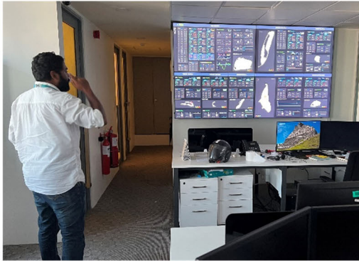
写真 2-1：既設上水道監視システム（MWSC）
