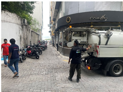
写真 2-5：MWSC既有的の高圧洗浄車を用いた管路洗浄作業の様子①
