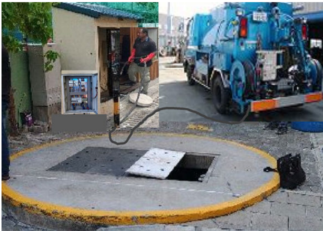
高圧洗浄車によるマンホール洗浄と、ターミナル設置の配電盤予想図 完成予想図（雨水排水コンポーネント）
