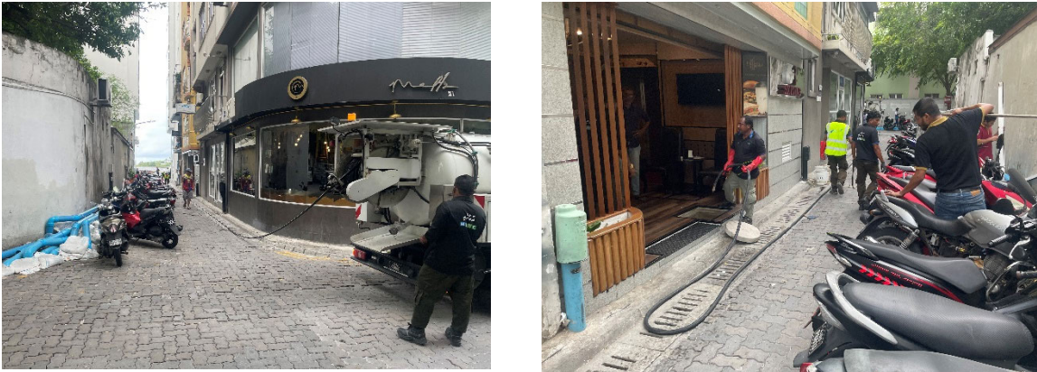
写真2 高圧洗浄車の作業状況
