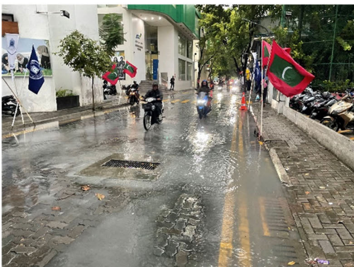
写真 1-5：降雨時の道路の浸水状況。車道が浸水している。(Ameenee mag通①)
