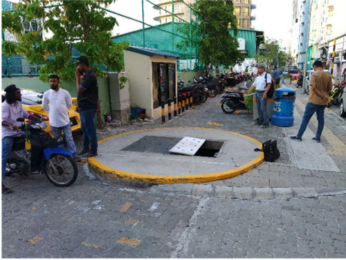
写真 1-1：雨水排水ポンプ施設全景(LS09)。雨水タンクが歩道の下に設置されている。
