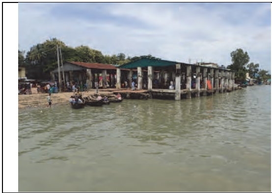
写真 1-6：荷捌所 前面 (満潮時)
