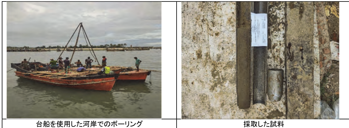
写真 2-2：陸上・河岸でのボーリング調査状況
