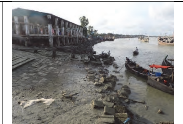
写真 1-7：荷捌所 (A) 前面 (大潮干潮時)
