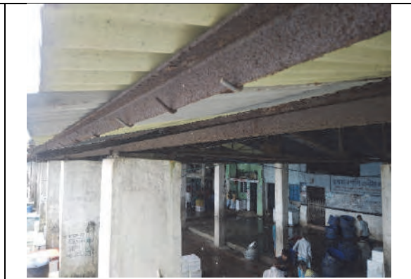
写真 1-5：荷捌所 (B) の柱上部
