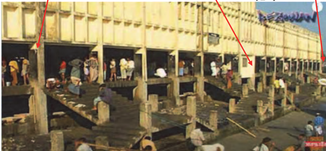
写真 1-3：既存荷捌棟前の階段式棧橋（崩壊前）外観
