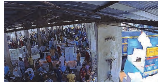
荷捌所の内部②
