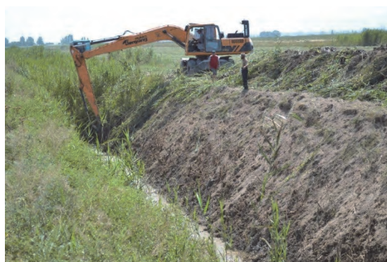
排水路浚渫工事 チュイ州
