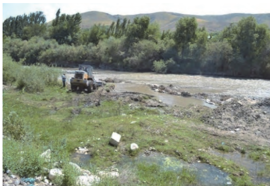
滯筋の切り替え作業 ジャララバード州
