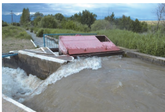
上流水位一定型分水工 タラス州
