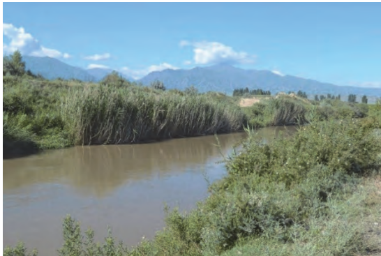
土水路の雑草の繁茂状況 タラス州
