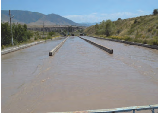
Kurshab 頭首工沈砂池、オシュ州 2003 年に世銀の融資により追加
