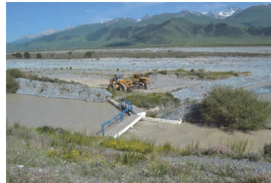
滯筋の切り替え作業に待機している重機 ナリン州
