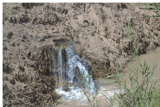
暗渠排水路口出 チュイ州
