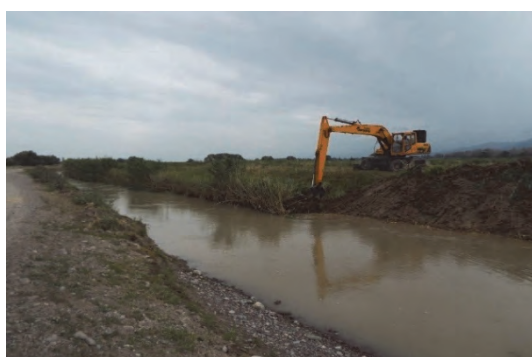
用水路の浚渫作業 チュイ州
