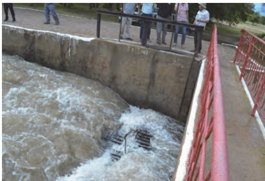
2) Sesh-Tash 頭首工 タラス州 チロリアン型の溪流取水口が採用されている
