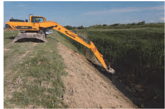
ロングリーチエクスカベータによる 排水路浚渫・掘削作業（チュイ州）
