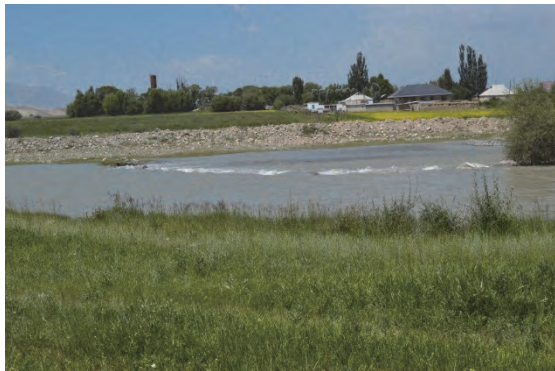
3) Kenesh 頭首工 ナリン州、河川内に土堰堤を造成
