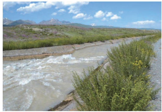
At-Bashy 頭首工、ナリン州 1985年当初より設置された沈砂池。波浪が生じており、効果が減少されている。
