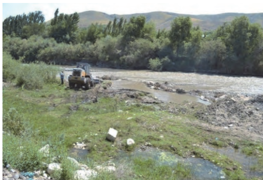
滞筋の切り替え作業 ジャララバード州
