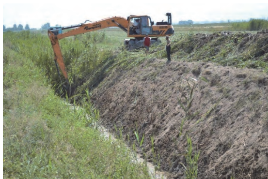
排水路浚渫工事 チュイ州
