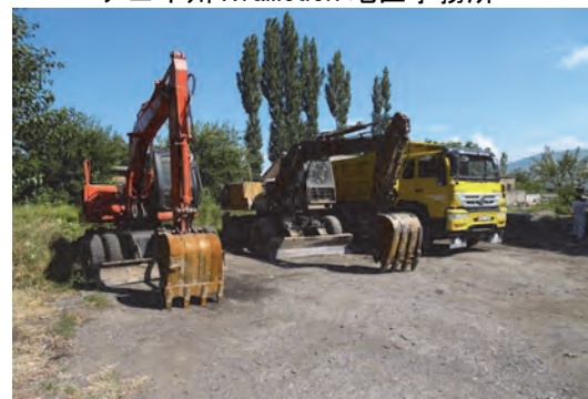
写 14 エクスカベータ、ダンプトラック オシュ州 Uzgen 地区事務所
