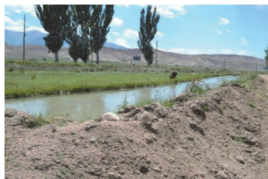
浚渫予定地と浚渫された土砂 ナリン州
