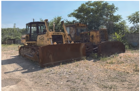
中国製ブルドーザ ジャララバード州 Bazar-Korgan 地区事務所
