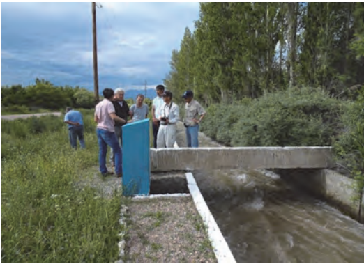
写3 州事務所管轄のコンクリート水路 (タラス州)
