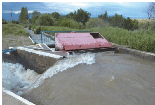
上流水位一定型分水工 タラス州
