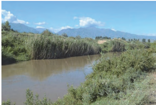
土水路の雑草の繁茂状況 タラス州
