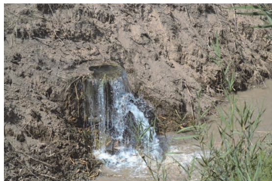
暗渠排水路口出 チュイ州
