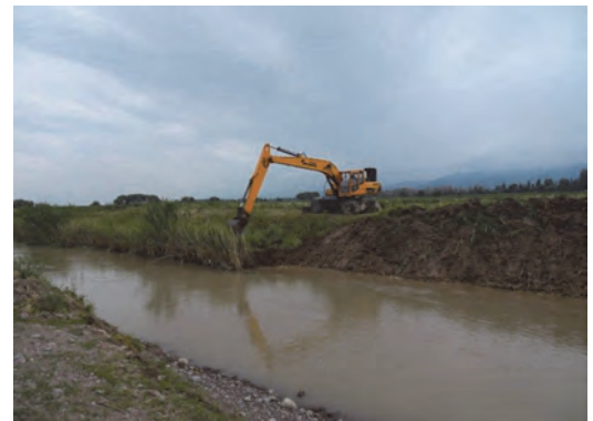
写6 エクスカベータ (ロングリーチ) による浚渫作業 (チュイ州)
