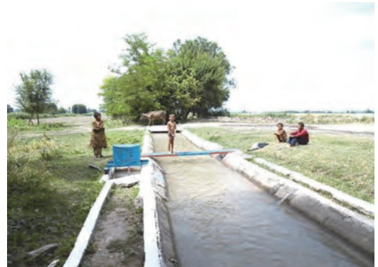
写4 地区事務所管轄のコンクリート水路 (チュイ州)
