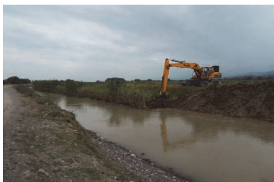
用水路の浚渫作業 チュイ州
