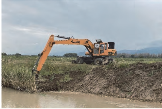
ロングリーチエクスカベータによる 土水路浚渫作業（チュイ州）
