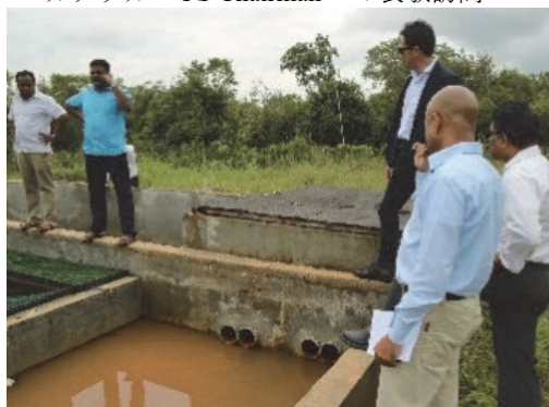
カタラガマ PS 最終処分場 浸出水処理施設視察
