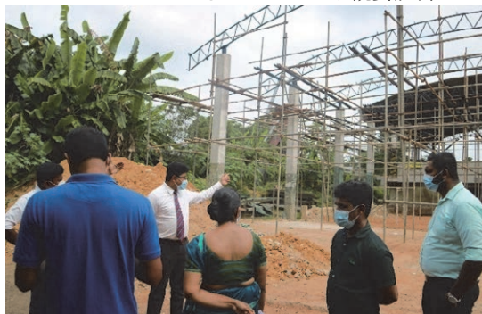
工事中の中継基地のモニタリング
