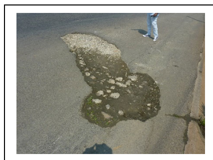
図 3.2.67 STA.22+25 付近の舗装損傷
