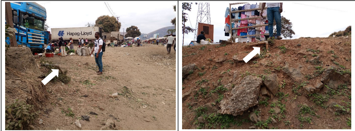
図 2.2.27 マタディ橋左岸上流側の水道管の露出状況
