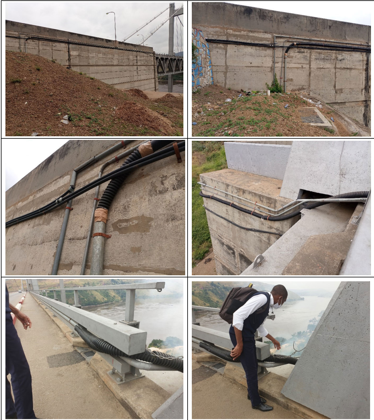
図 2.2.26 マタディ橋左岸上流側の通信ケーブル添架状況
