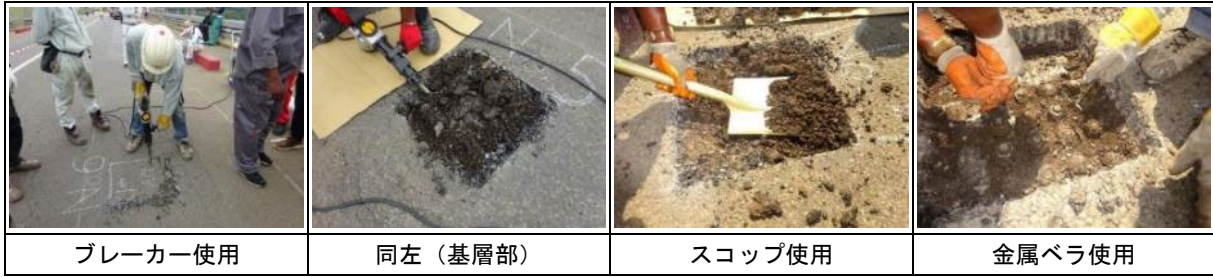
図 3.2.6 橋面舗装開削作業状況
