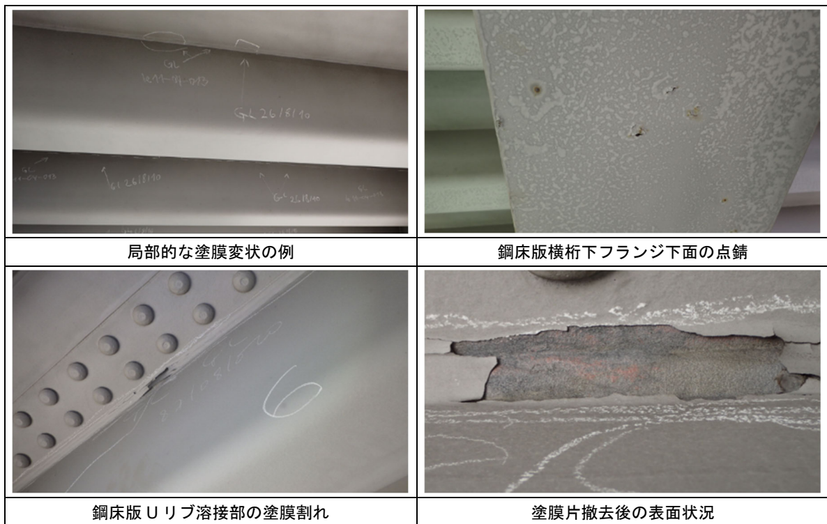
図 3.2.15 補剛桁検査結果-1
