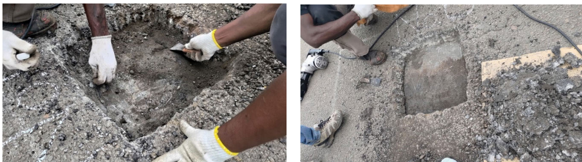
図 3.2.79 橋面開削調査
