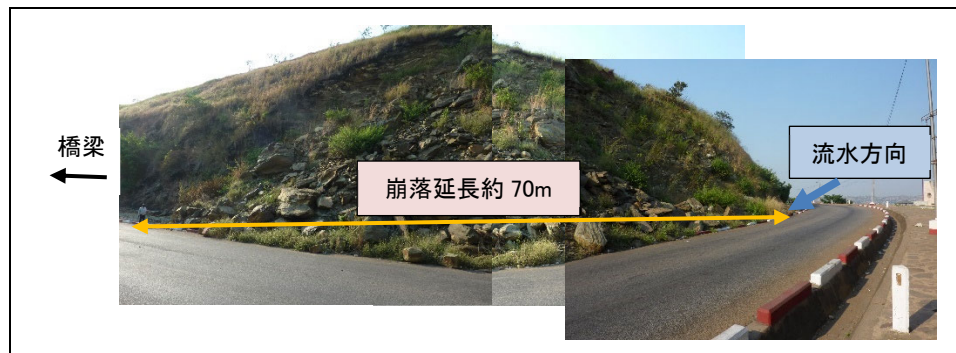
図 3.2.64 STA.09 付近の斜面の崩落
