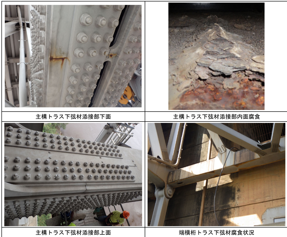
図 3.2.16 補剛桁検査結果-2
