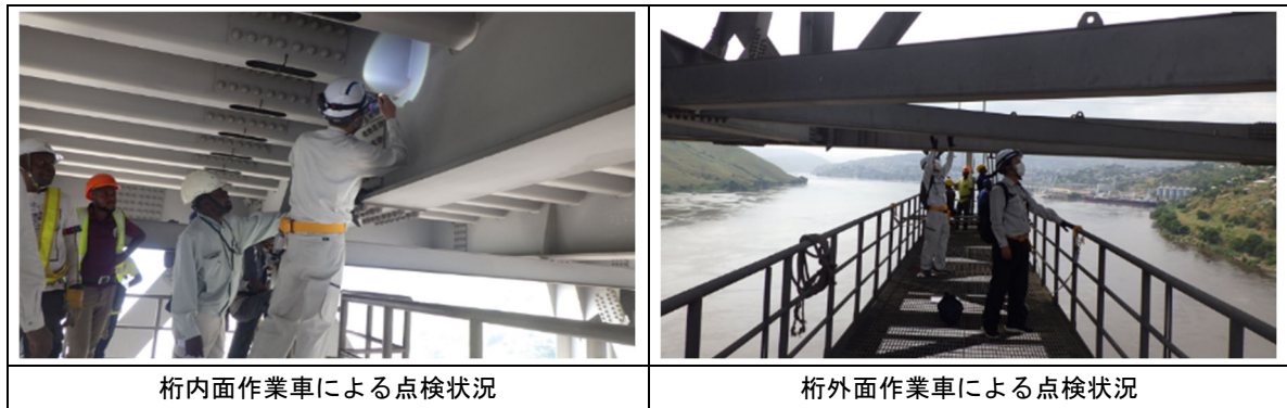
図 3.2.14 作業車を使用した調査状況
