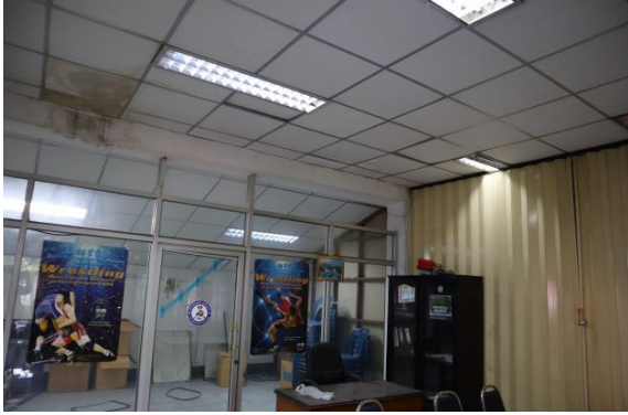
写真 25:バックスタンド下所要室(1)
