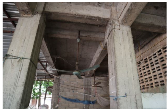
写真 36:スコアボード基部(2)
