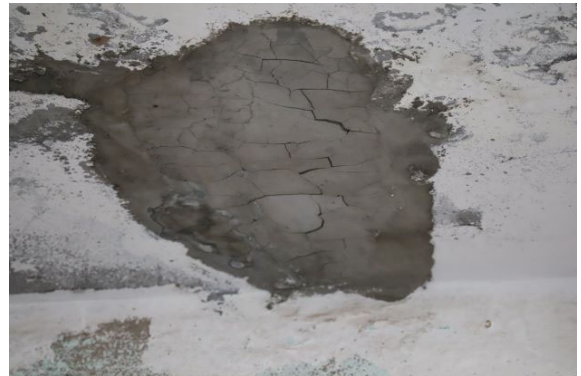
写真 28:バックスタンド裏シェッド補修
