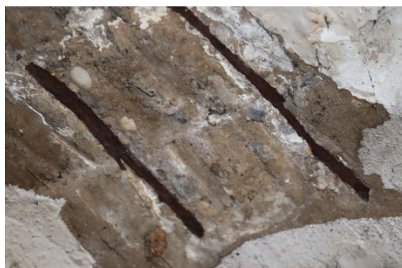
写真 24: バックスタンド裏側シェッドスラブ下
