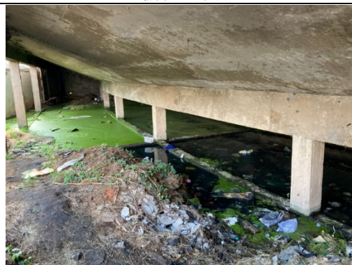
サイドスタンド下 水が溜まっており、ごみが多く捨てられている
