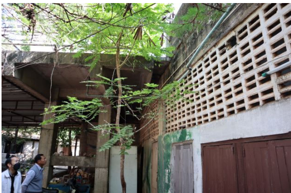
写真 35:スコアボード基部(1)
