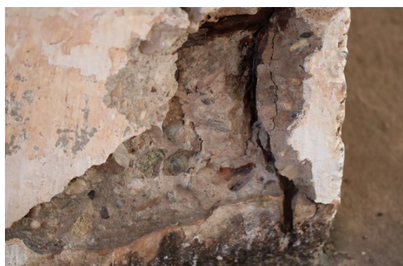
写真 23: バックスタンド柱脚部分
