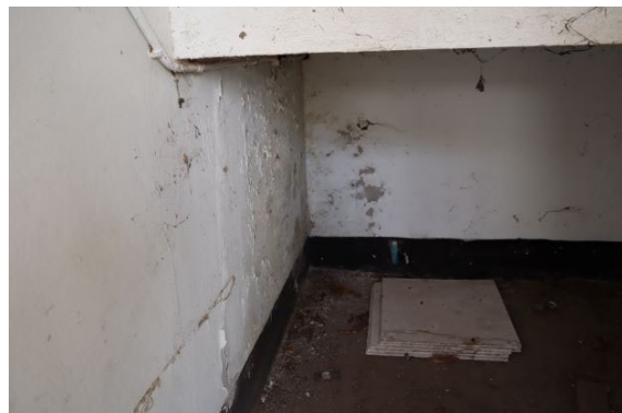
写真 15: 観客下スペース(1)
