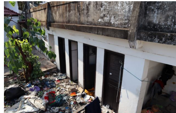
写真 64:サイドスタンド下トイレ
