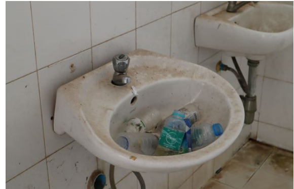
写真 62:メインスタンドトイレ洗面器 (2)
