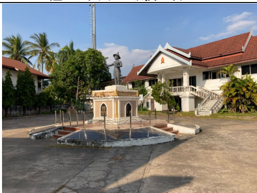
メインスタンド建物裏側(エントランス側) 駐車場の中心にチャオアヌウォン王の銅像が立つ
