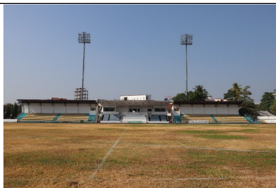
メインスタンド遠景 主要建物は左右中央の3つのブロックに分かれている
