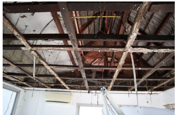
写真 9:メディアルーム天井裏
