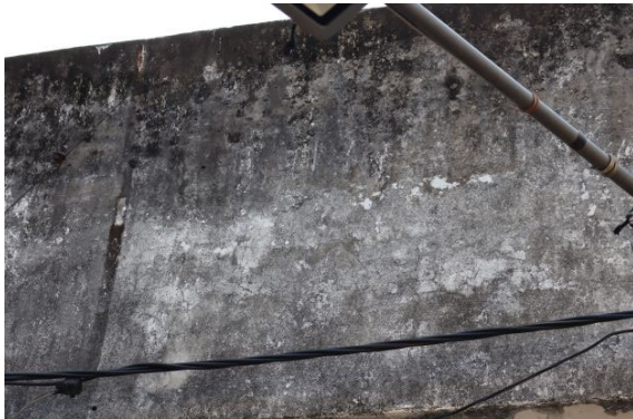
写真 27:バックスタンドコンクリート表面
