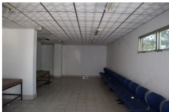
写真 13: 観客室裏所要室(3)
