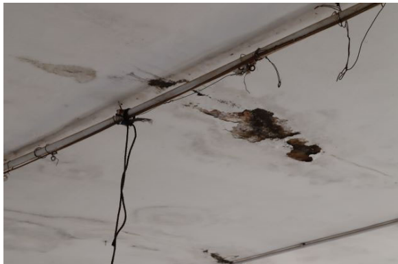
写真 6:鉄筋爆裂部分拡大(1)
