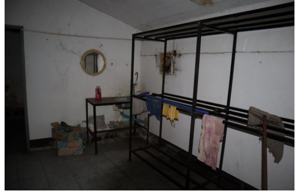
写真 26:バックスタンド下所要室(2)
