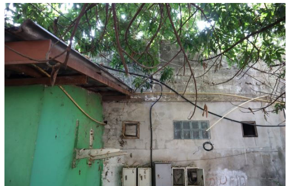
写真 48: ④電力引き込みポイント
