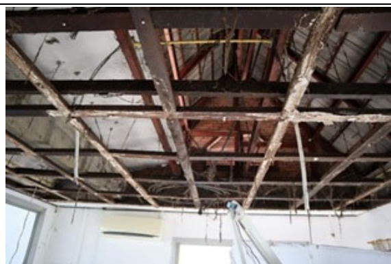
メインスタンド建物天井裏 仕上天井が剥がされている 屋根材下の野地板はない構造である
