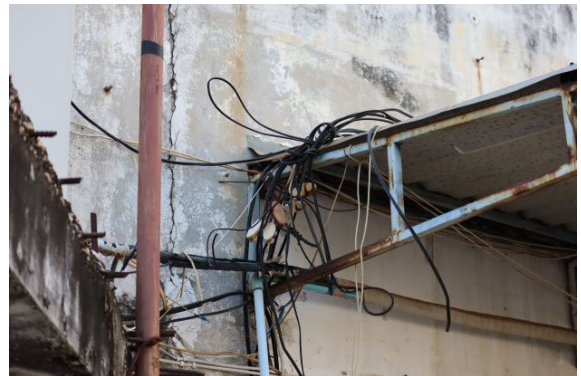
写真 30:バックスタンド裏側外壁
