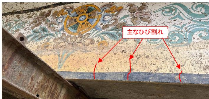
主桁に発生している主な曲げひび割れ
