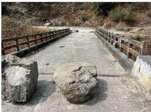
橋面の状況(舗装の損傷)
