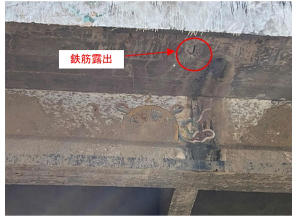
張出床版部の鉄筋腐食
