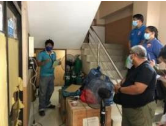
20. IT 震度計設置状況 (パテロス、MDRRM 事務所)
