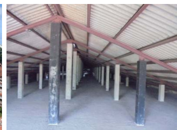
屋根内面写真
