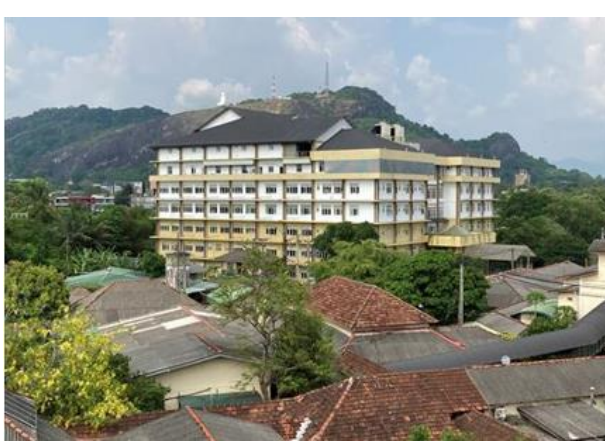
クルネガラ教育病院 PV パネル据付予定の産科病棟。
