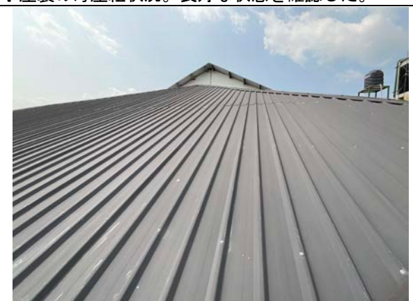
クルネガラ教育病院（産科病棟） 屋根の状態は良く、塗装の必要はない。既存屋根に架台を設置し、太陽光パネルを敷設する。
