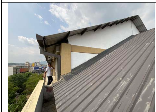
クルネガラ教育病院（産科病棟） 外部躯体状況。ひび割れも無く良好な状態である。
