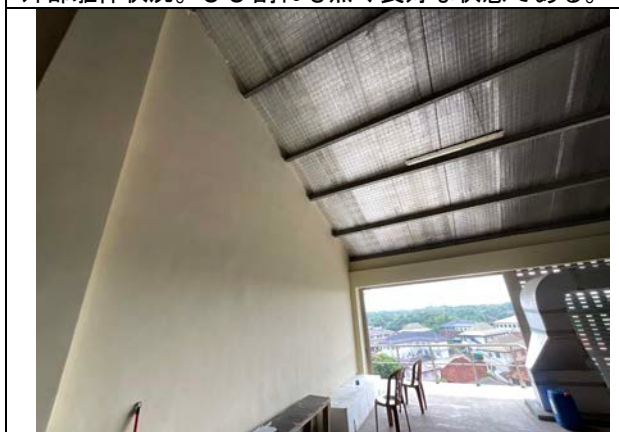
クルネガラ教育病院（産科病棟） 柱・梁の躯体や壁にひび割れもなく良好な状態である。
