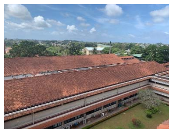
屋根外観写真
