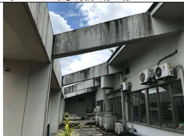
ラトナプラ教育病院 (JICA棟) 最上階の躯体状況。経年の汚れはあるがひび割れは無く、良好な状態である。
