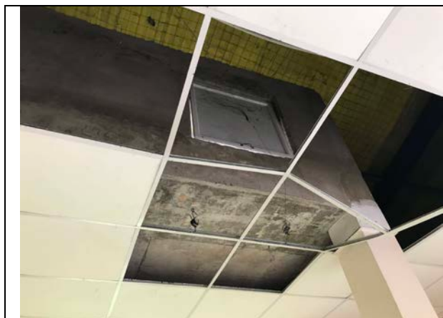
ラトナプラ教育病院（血液バンク棟） 屋根に設置された貯水タンクの下部コンクリート状況。ひび割れもなく良好な状態を確認した。
