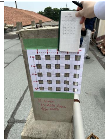
スリジャヤワルダナプラ総合病院 B棟屋上のコンクリート強度測定状況(2/2)
