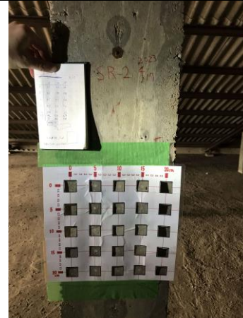
スリジャヤワルダナプラ総合病院 B棟小屋裏束柱のコンクリート強度測定状況(2/2)
