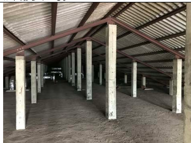
スリジャヤワルダナプラ総合病院 (B棟) B棟の小屋裏状況。コンクリートの束柱はひび割れや損傷もなく、修復や改修は必要ない。
