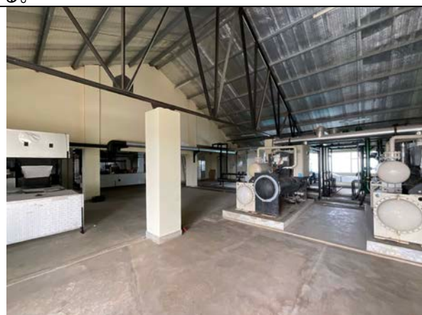
クルネガラ教育病院（産科病棟） 小屋裏の母屋組状況。良好な状態を確認した。
