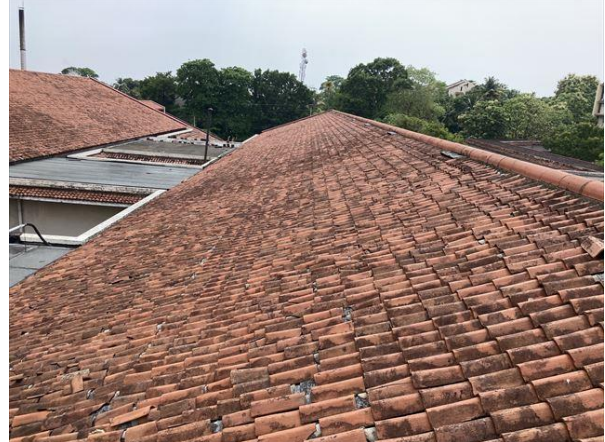
スリジャヤワルダナプラ総合病院 PV パネル据付予定の B 棟南側屋根。表面の瓦を取り除き、敷設する。
