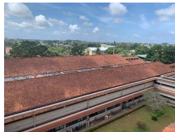
屋根外観写真
