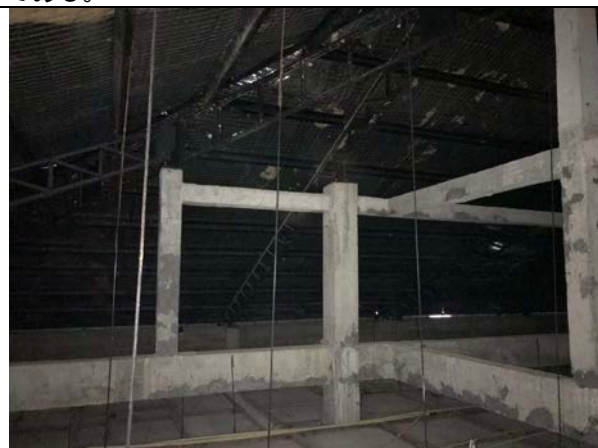
ラトナプラ教育病院 (事故救急救命棟) 小屋裏のコンクリート束柱の状況。ひび割れも無く良好な状態である。
