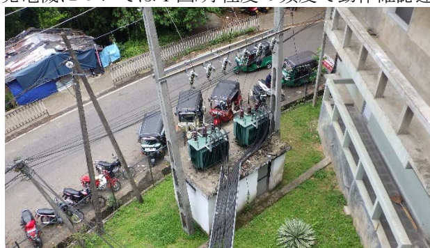
図 2.5 受電用変圧器の写真
