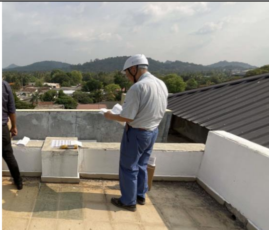
クルネガラ教育病院 産科病棟屋上のコンクリート強度測定状況(1/2)
