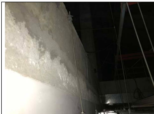
ラトナプラ教育病院 (JICA 棟) 小屋裏の躯体 (梁) 状況。ひび割れも無く良好な状態である。
