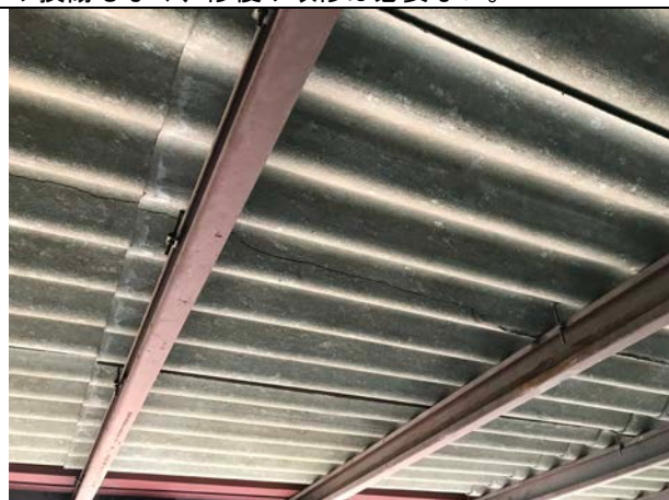
スリジャヤワルダナプラ総合病院 (B棟) 母屋となる鉄骨部材に錆は無く、修復や改修は必要ない。スレートの状態は良好であった。
