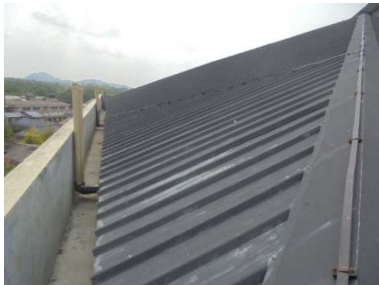
屋根鋼製折版
