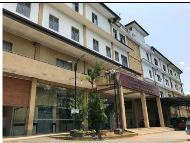
ラトナプラ教育病院 (事故救急救命棟) 外部躯体状況。ひび割れも無く良好な状態である。
