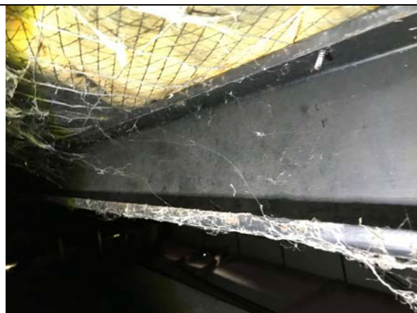
ラトナプラ教育病院 (事故救急救命棟) 小屋裏の梁や母屋の鉄骨状況。錆もなく良好な状態である。
