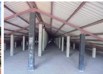
屋根内面写真
