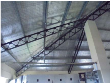
鉄骨トラスと屋根内観
