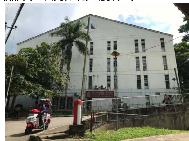
ラトナプラ教育病院 (JICA棟) 周囲状況。大型クレーンの設置は困難である。躯体はひび割れも無く良好な状態である。
