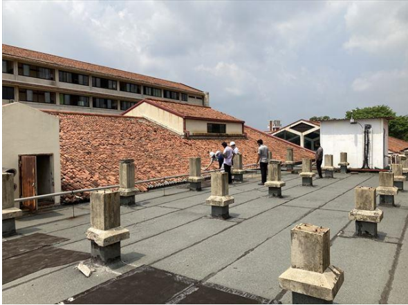
スリジャヤワルダナプラ総合病院 PV パネル据付予定の B 棟北側屋根。
