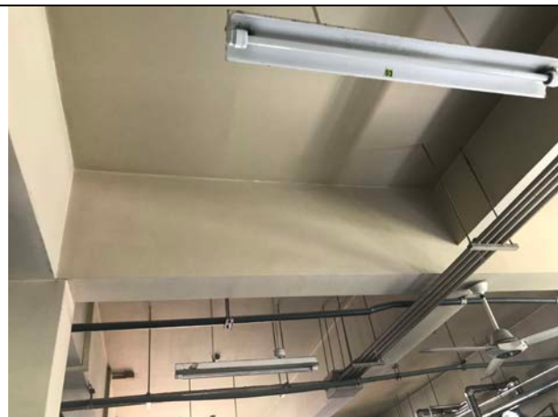
スリジャヤワルダナプラ総合病院 (B棟) B棟の最上階梁・柱の状況。コンクリートのひび割れや損傷もなく、修復や改修は必要ない。
