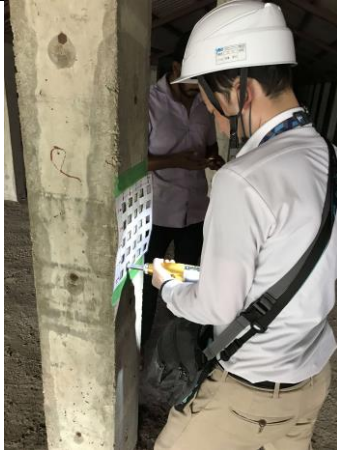
スリジャヤワルダナプラ総合病院 B棟小屋裏束柱のコンクリート強度測定状況(1/2)
