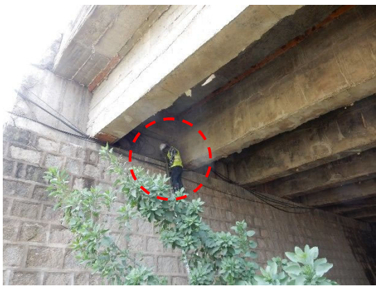
梯子を使つての支承点検
