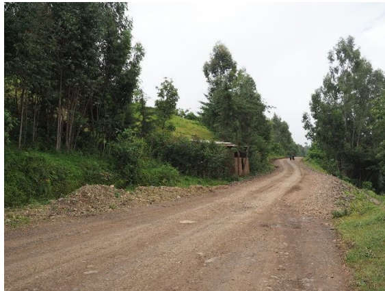
地すべり頭部と道路の状況。頭部は不明瞭だが、道路は押し出されたことによる屈曲が明瞭である。
