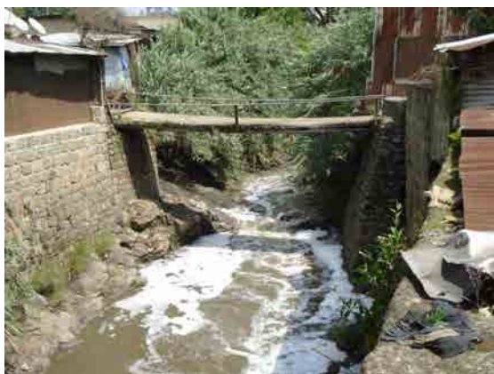
橋梁側面から見たたわみ
