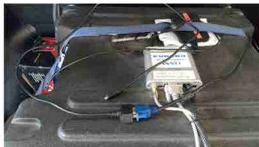
ケーブルの問題が想定される
