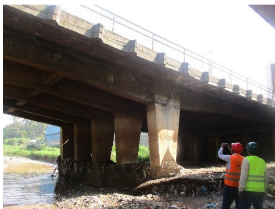
橋梁全景 (旧橋)
