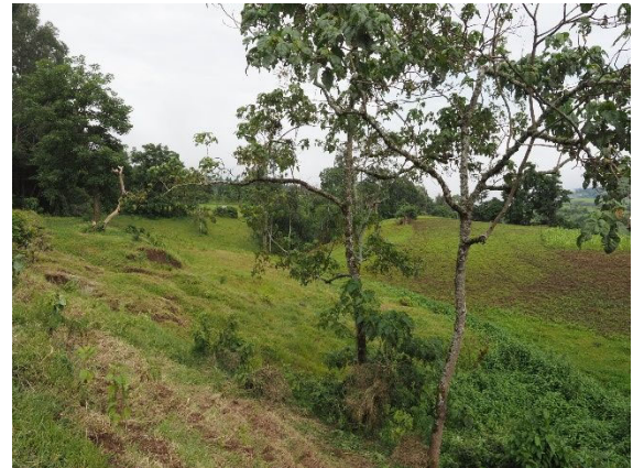
道路の谷側のり面/斜面の状況。地すべり活動により地形が乱れている。
