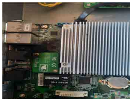
EDP メインボード焼損部
