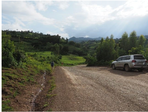
起点側を望む。この先が地すべり区間
