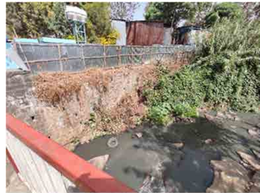
下流側左岸フェンス
