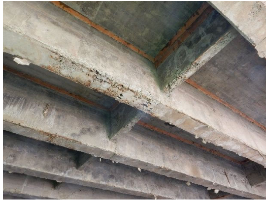
主桁及び床版 (1)
