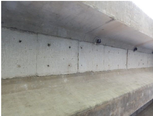
主桁及び床版
