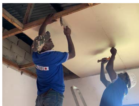
(d) Placement of the new ceiling sheets
