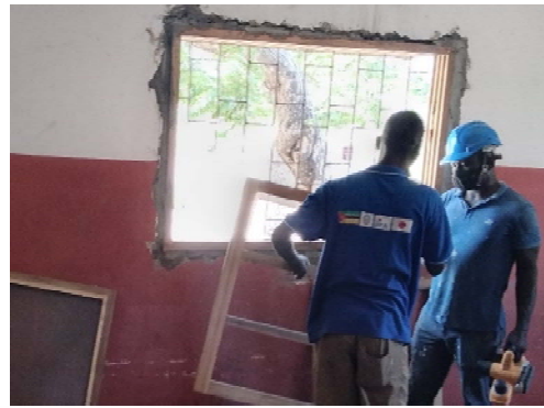
(d) Installation of glass and screen doors
