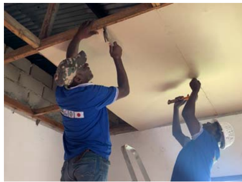
(d) 天井材の設置
