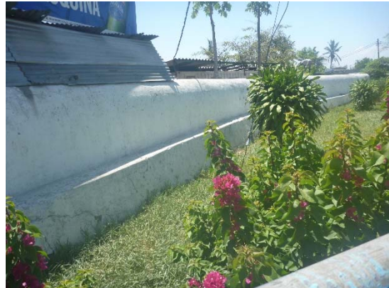
④ 旧防潮堤は損傷なし
