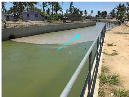
① 遊水地からの放流路で損傷はない
