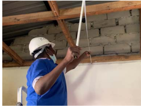
(b) 骨組みの計測
