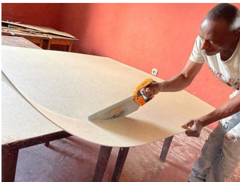
(c) 天井材の切り出し
