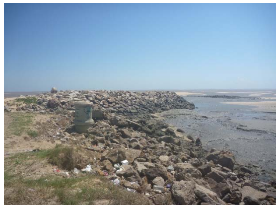
⑥ 導流堤：基本的に損傷なし
