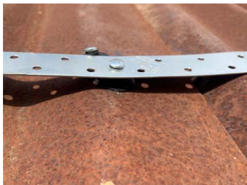
(a) 釘補強後
