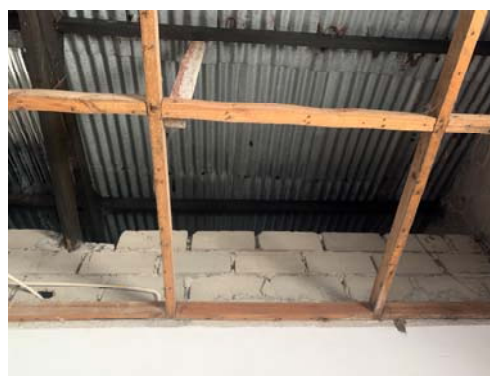
(d) 室内補修後
