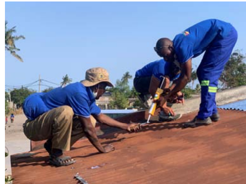
(b) 屋根上からの補強の様子
