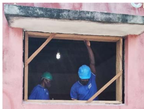
(b) 窓枠の設置
