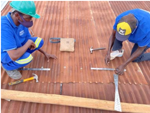
(a) 屋根上からの補強の様子
