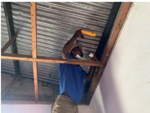
(c) 屋内からの補修の様子
