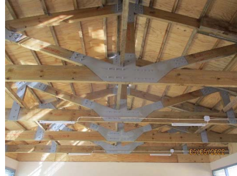
修復では屋根部の強化など施設の強靱化を実施
