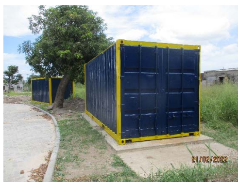
災害時への備えのために整備した備蓄倉庫
