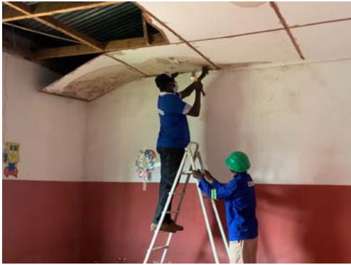
(a) 既存釘・天井材撤去
