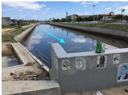
⑤ 水門上流部に位置し、開水路に損傷はない
