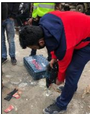
図 3.1.2 ベンチマーク設置の様子
