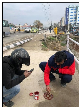
図 3.1.2 ベンチマーク設置の様子
