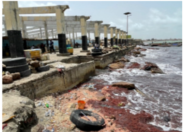
Photo 2 : Côté droit de l'installation existante (juin 2023)
