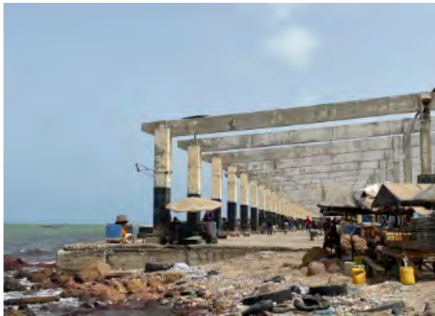
2022年の暴風雨により、前浜の一部分が消失し汀線が既存水揚施設に近づいている。
