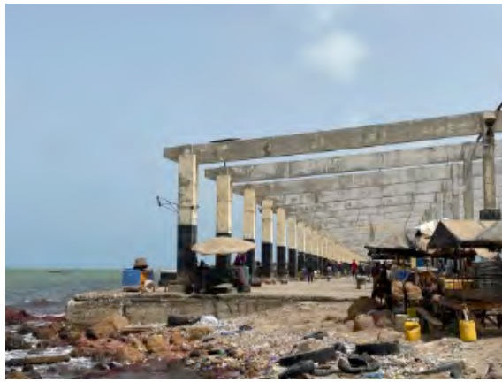
写真1 既存施設前右側角 (2023年6月)
