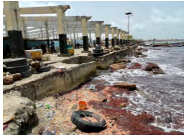
写真2 既存施設前浜右側 (2023年6月)
