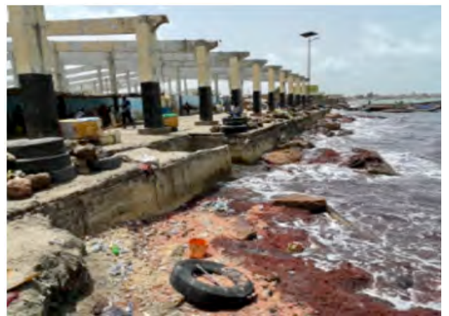
2022年の暴風雨により、前浜の一部分が消失し汀線が既存水揚施設に近づいている。
