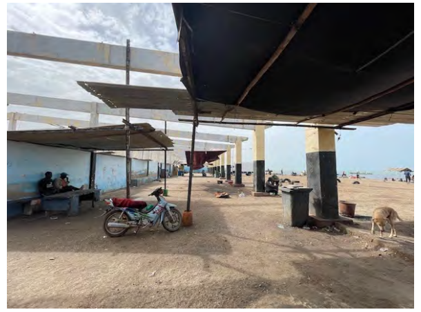
既存水揚施設の状況：2022年の暴風雨により屋根が破損し、全面的に屋根が撤去された。現状では、施設内の一部にテントを張るなどして対応している。
