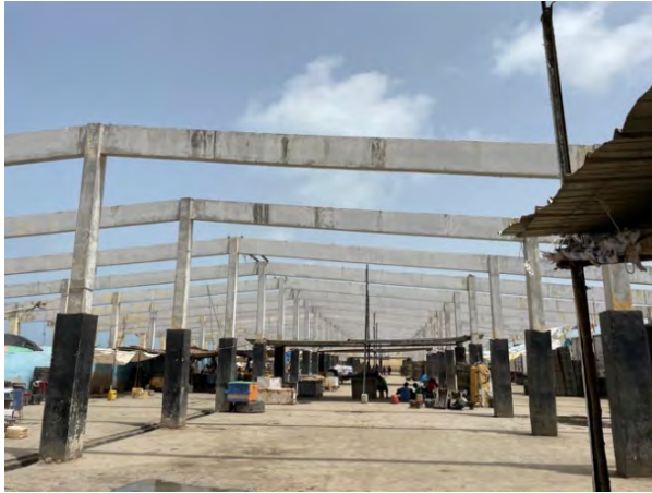
既存水揚施設の状況：2022年の暴風雨により屋根が破損し、全面的に屋根が撤去された。現状では、施設内の一部にテントを張るなどして対応している。
