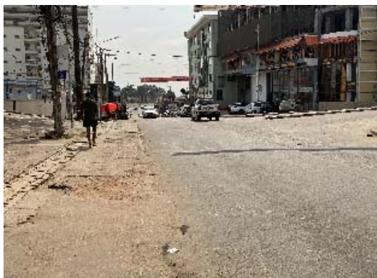
図 5.2.8 歩道舗装の損壊部
