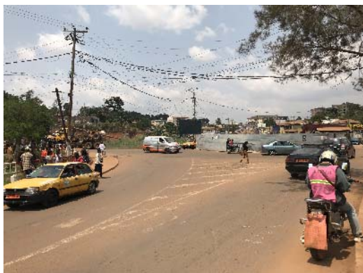
図 5.2.9 横断歩道路面標示の摩耗状況
