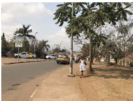
図 5.2.6 アスファルト舗装
