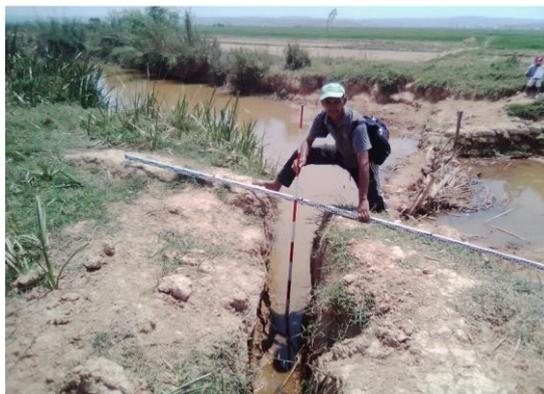
Barrage (gauche) et prise d'eau (droite) sur le cours d'eau dans le périmètre irrigué de Maharivana, construits par des paysans avec des matériaux locaux tels que la terre, le sable et des herbes. Pas de vanne ni de fonction de réglage du niveau d'eau.
