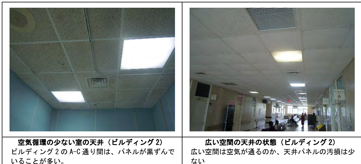
図 2-9 天井の状況 写真
