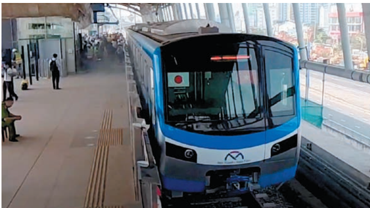
ベトナム：ホーチミン市都市鉄道事業[ベンタイン-スオイティエン間(1号線)]の試運転開始式典の様子(2022年12月)。日本の協力でベトナム初の地下区間を含む都市鉄道を整備中。市民の足として生活に浸透することが期待される
