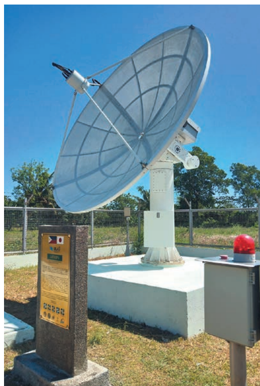
フィリピン：「フィリピンにおける極端気象の監視・情報提供システムの開発」プロジェクトで供与された、衛星データ地上受信局のアンテナ。プロジェクトでは受信される衛星データを活用し、極端気象を予測するシステムの開発を行った
