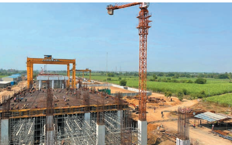
建設が進むプロジェクトサイトの一つであるスーラット駅
