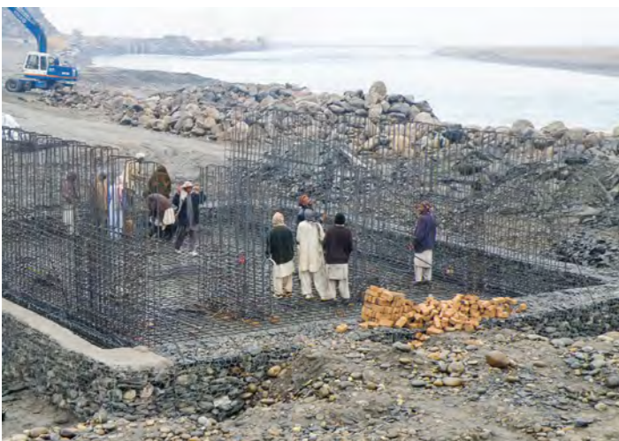
4.6 تصویر : اوبه نیونکی دروازه د جوړیدو په حال کې: د یو اوسپنیز کانکریت جوړونه 11
