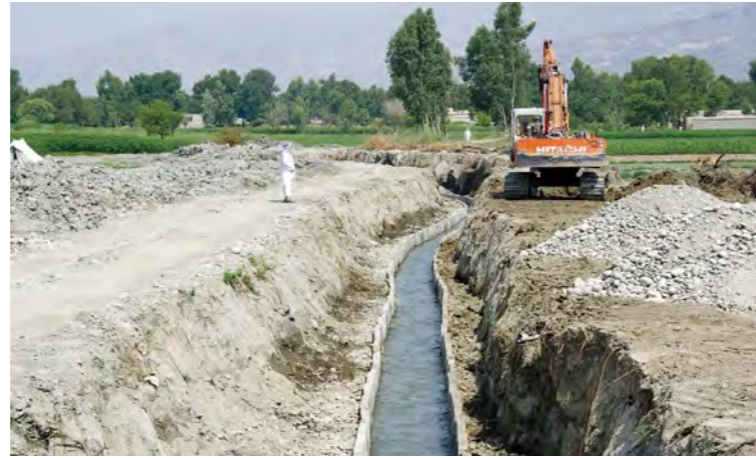
6.50 تصویر : په اوبه ویستونکې کانال کې د U-ډوله مجرا جوړونه (د کمبیري اساسي اوبه ویستونکې کانال) : 1 July 23, 2016
