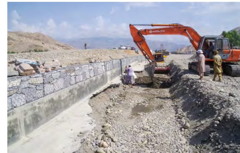
تصویر : د اوبه لگولو اساسي کانال د بستر تخریب
