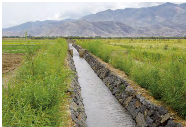
4.23 تصویر : د کوچنیو کانالونو لپاره د دبریني معماري نمونه ۳
