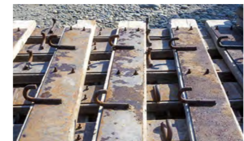
د فولادی پلیتونو پواسطه د کنترولې تختو تقویه کول March 9, 2017
