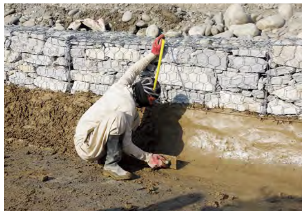
4.14 تصویر : د کانال د څنډو ډکونه د خاورې سیمنټوسره ۳
