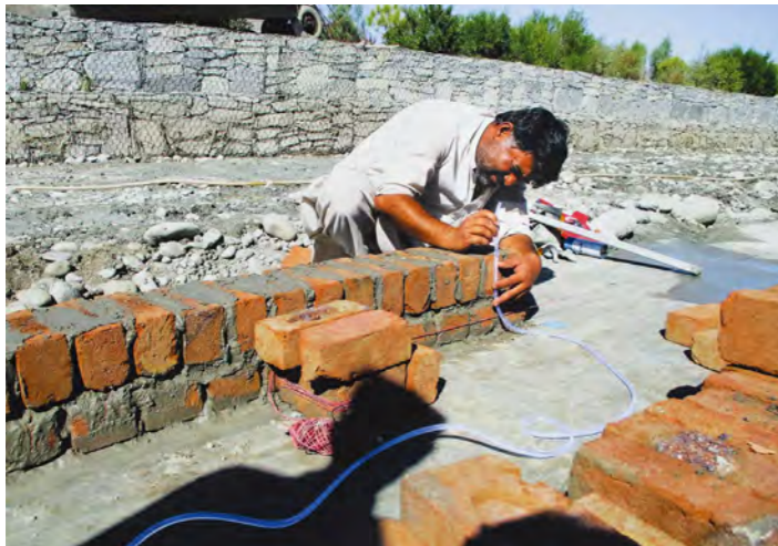
3.11 شکل: د فاصلې، ژوروالي او لیول اندازه کول د ساده سروې په طریقه
