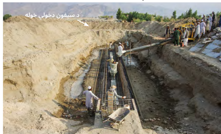
6.43 تصویر: د یو سیفون ساختمانی چارې (مرورید کانال، گمبیری د سیلاب مسير)
