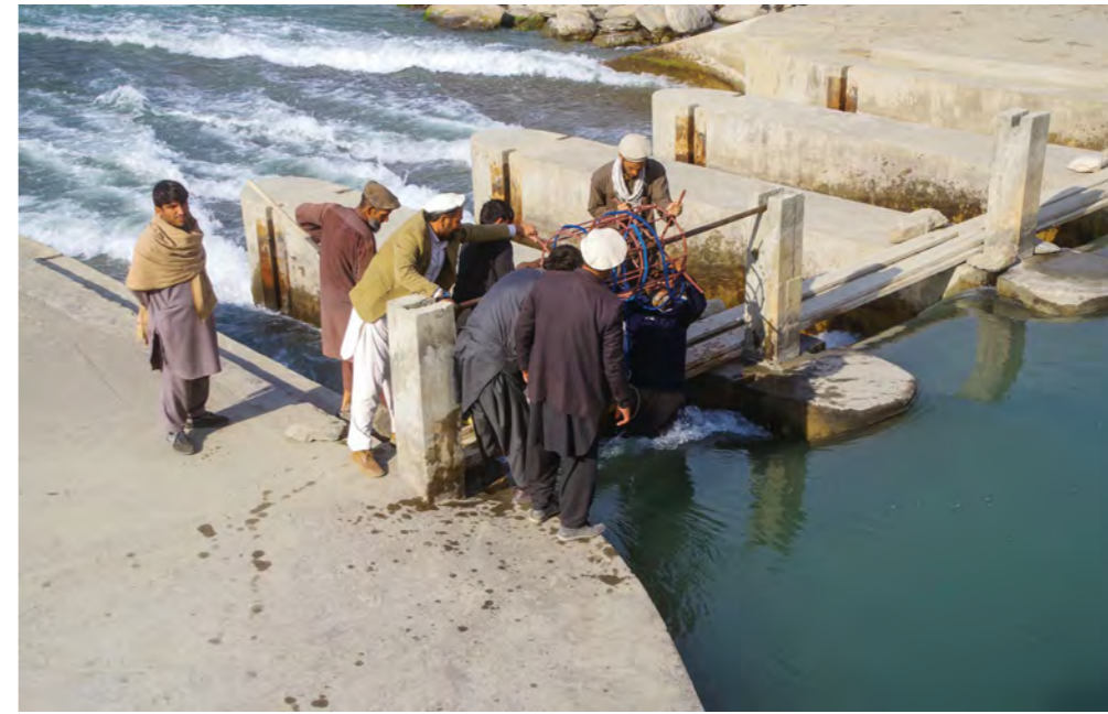
4.7 تصویر: د شگو ایستلو لپاره د دوه گونې کنترولونکې تختو څخه گټه پورته کول 1
