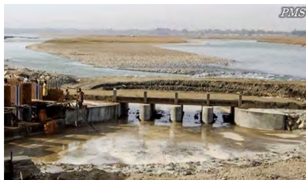
6. د شگو ایستونکی مجرا د پاخه د موقت پول نصبول: د درانه ماشینونو/وسایلو لپاره چې ابگیر سربند بدنه جوړوي. (مروارید II سربند)
