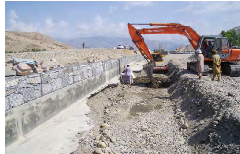
4.15 تصوير : د نامناسب تهداب له وجي د کانال د بستر تخریب ۱۱
