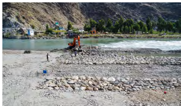
8. د ابگیر سربند اساسی سیول کارونه: د دواړو پشتو څخه د بولډرو پواسطه د اوبه نیونکې سربند جوړول (کامه I سربند)
