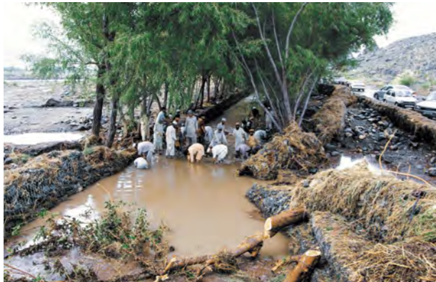
7.13 تصویر: د سیلاب او جغل د جریان له اثره د کانال تخریب
