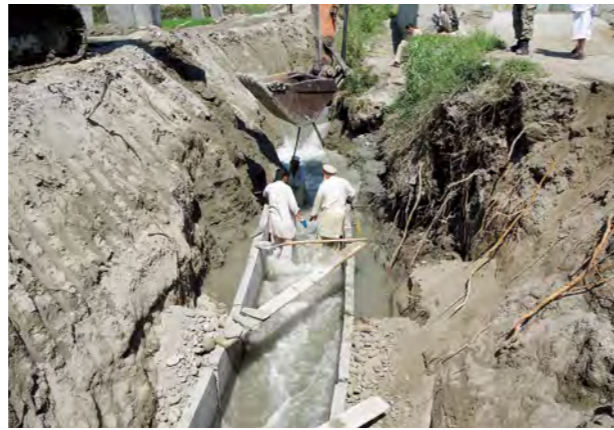
4.21 تصویر : د U شکره مخکې جوړیدونکې کانکریټي مجرا ځای پر ځای کول
