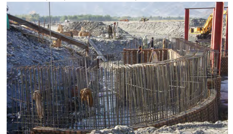
6.18 تصوير : د کانکریټي تحکیماتی برخې سیمتاوی (کاشکوت ابگیر دروازه) 1 November 7, 2012 :
