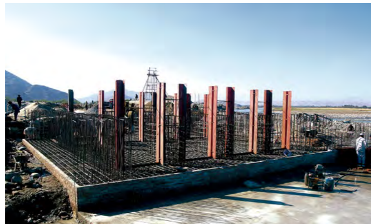
6.15 تصویر : د خښتو پواسطه د قالب جوړولو چاری (مرورید II اوبه نیونکې دروازه) 1 : November 8, 2016
