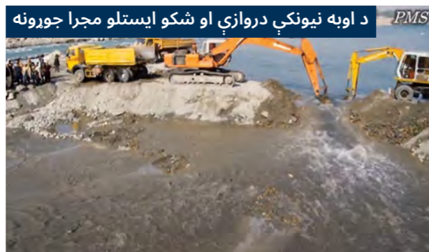
7. د موقت ساختمانونو لری کول: د ابگیر او شگو ایستونکی مجرا د ساختمانی چارو له بشپړ کیدو وروسته باید کوفر ډکه لری شی، او اوبه احاطه شوی ساحی ته جریان پیدا کړي. (مروارید I سربند)
