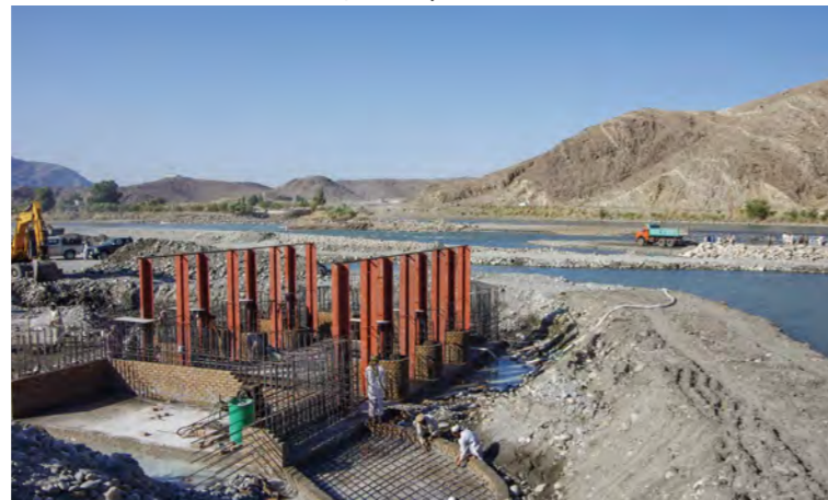
6.16 تصویر : د دروازې د پایو سیمتاوی او د وچ ساختمانی میتود کارولو لپاره موقت کوفر ډکې چې د اوبه نیونکې دروازې لپاره کارول شوی(کاشکوت اوبه نیونکې دروازه) 1 : November 4, 2012
