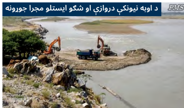
4. موقعیتی کارونه: د اوبه نیونکې سربند، شگو ویستونکې مجرا او رسوبی حوض شاو اوخوا یو گرد موقعیتی بند جوړوي. (مروارید II سربند)
