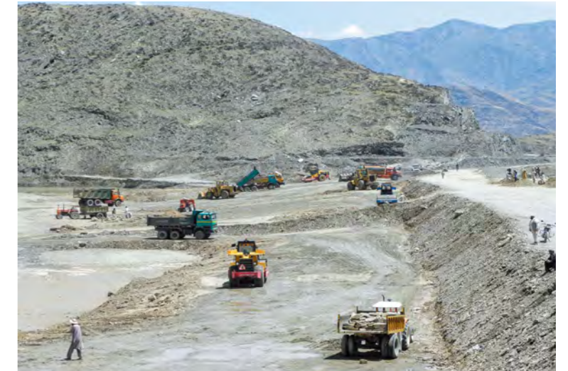
6.26 تصویر : درانه ماشینونه، ډم ترک، او کارگران د ډکو په پشته کې (د مروارید اوبو لگولو عمومي کانال Q2 ذخیره) : May 6, 2009
