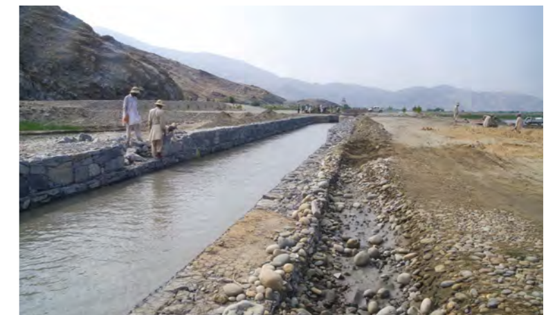
6.35 تصویر : د گبینونو پواسطه د کانال د استحکامی برخو جوړول (مروارید II د اوبو لگولو اساسي کانال) 1 : July 19, 2018
