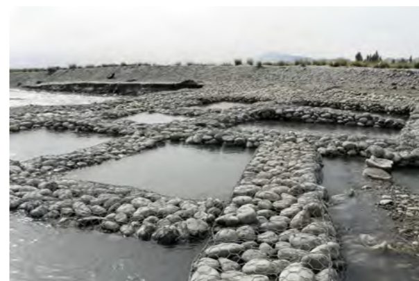
4.5 تصوير : د لمنې ساتنې کارونو کې د گبيونو د شبکې اتصال (د کامه II سربند) 1)
