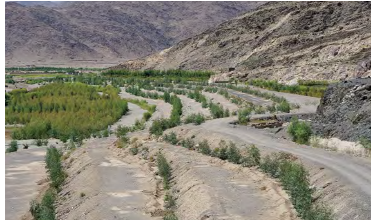
6.29 تصویر : د ابلیتس په واسطه د ذخیرې د شاتنې میلان تقویه کول (د مروارید اوبو لگولو عمومي کانال Q2 ذخیره) : September 19, 2011
