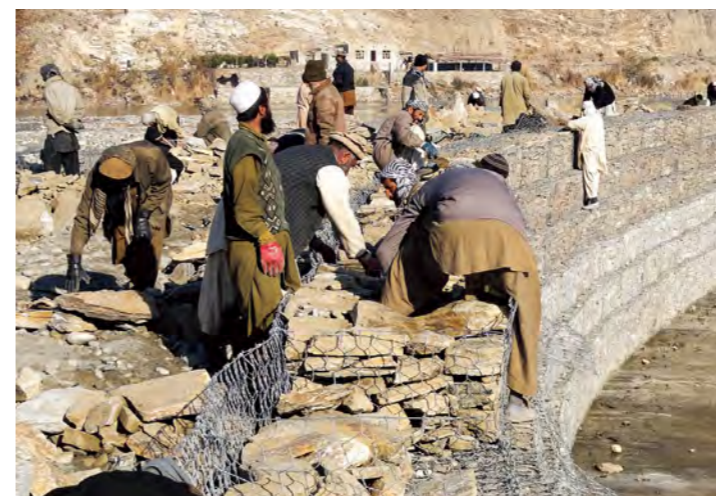
1.7 شکل: گبونونو کار د اوبه لگولو په کانال کې
