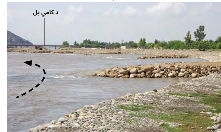
6.58 تصویر : په محدبو برخو کې د رخدازه ډکو د نصب په نقطو کې جریان، چیرې چې د وینځنی عمل شدید وي (میران) : 20 April 2015
