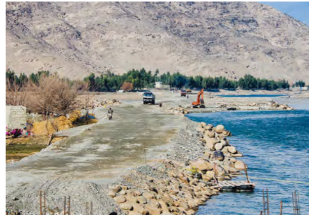
6.1 تصویر: د موقت سرک په توګه د یوې ډکې کارول (میران پروژه)
