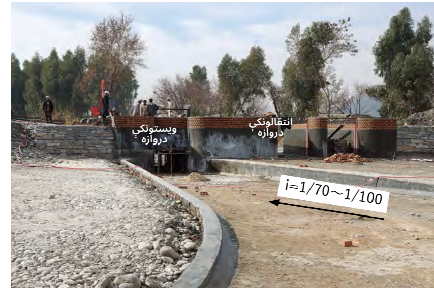
4.17 تصویر: د شگی ایستونکې حوض په تل کې د شگو ایستنی کانکریتی کانال او د تخلیې دروازه 8
