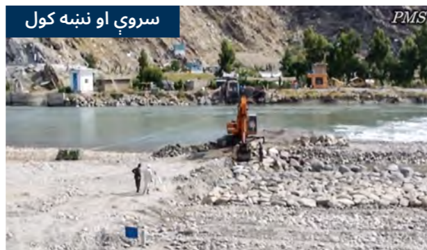
3. د مقابل لوری د ډکې استحکامی او تقویتی کارونه: د ابگیر سربند مقابلې برخه (د شگو ټاپو سره وصل شوي برخه) مخکی له مخکی تقویه/محکم شوي. (کامه I سربند)
