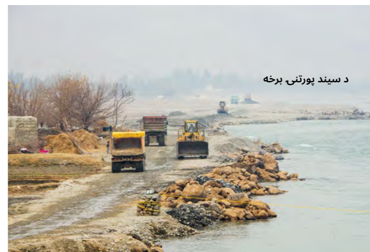
5.3 تصویر: د ډکې تاج چې د لاس رسې جادې په توگه ورڅخه استفاده شوې ۱
