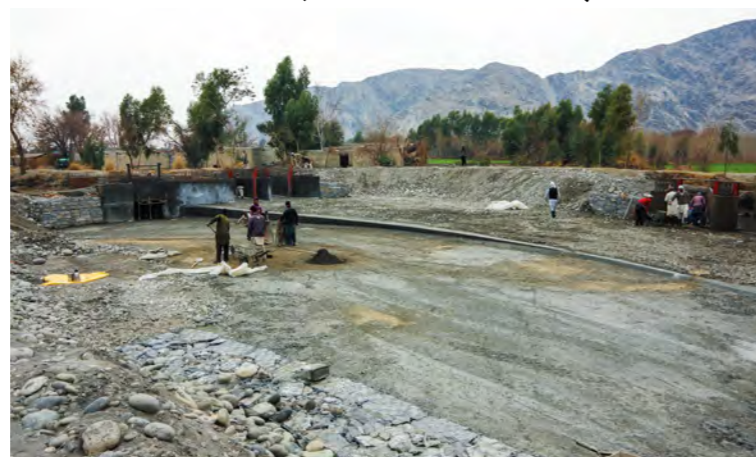
6.48 تصویر : د شگو ردونکې چینل د کانکریتی فرش چارې(میران) " February 7, 2015 :
