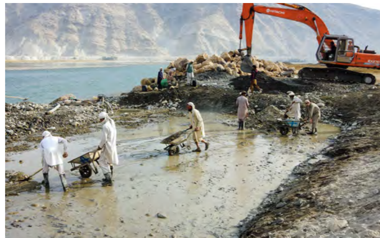
6.14 تصویر : د 0.5 متره او یا تر دي زیات په ضخامت پراخ تهداب ساختمانی چاری (میران سر بند دروازه) 1 : November 24, 2014
