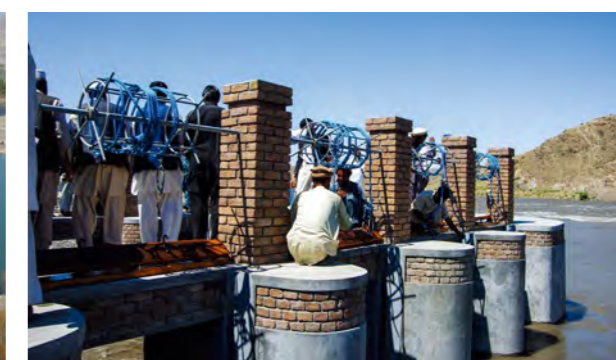
11. د ساختمانونو کاری ازمایننت: د اېکیر دروازې او شکو ایستونکی مجرا د فلش بورډ او پورته کوونکی وسایلو فعالیت باید وازمایل شي (کاشکوټ سر بند)
