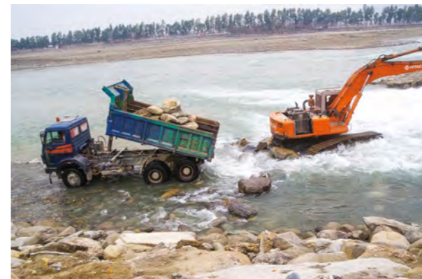
7.9 تصویر : د سیل له اثره د شکی ویستونکی مجرا او صوفي په ځنډوکی د سیند دبستر وینځل کیدنې بیاجورونه 1
