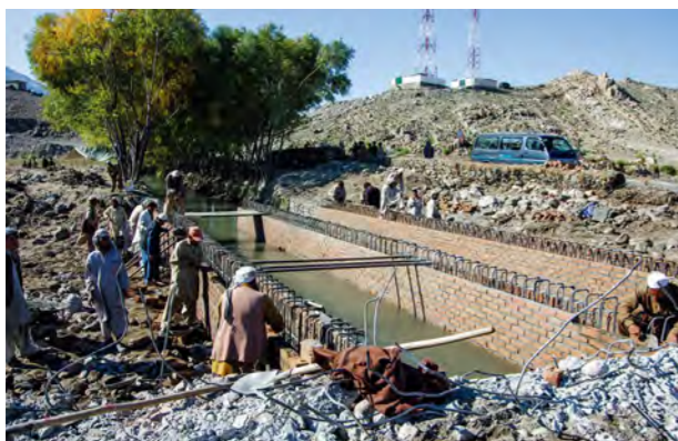
7.15 تصویر: د سیلاب پورته تیریدونکې پل پراختیایي کار (چپ خوا) او وروسته له تکمیل کیدو څخه (ښي خوا)
