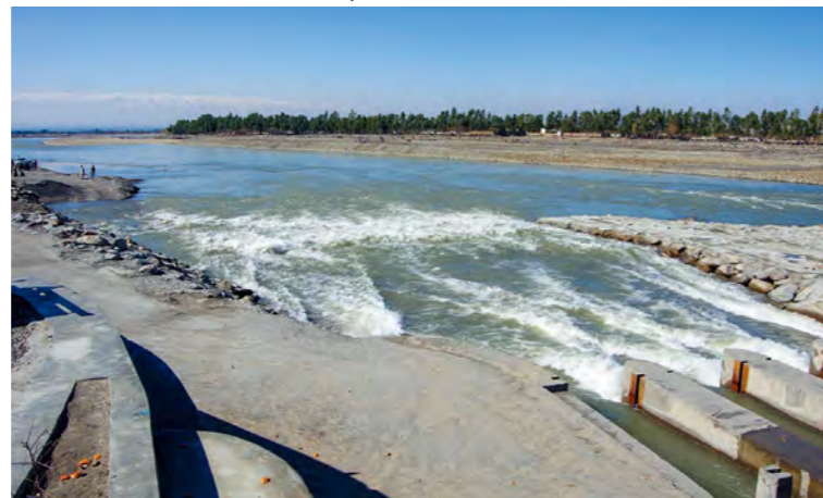
6.25 تصویر: د صوفی (لمني) کارونو او د شگو ایستونکې مجرا د لاندینی جریان لپاره د اساس محافظتی کارونو تشکیل (د کامی II سرسیند شگو ایستونکې مجرا ترمیمات) ۱ : February 12, 2019
