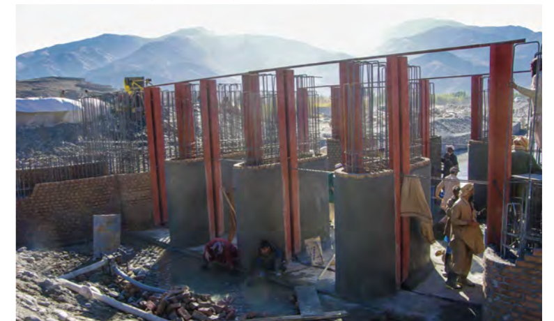
6.17 تصوير : د دروازي د پایو سیمتاوی او د دروازي چينل نصبول (کاشکوت اوبه نیونکې دروازه) 1 : November 15, 2012
