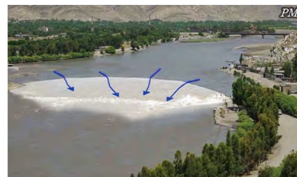
10. د ډبرین مایل سر بند کارونو تکمیلول: په اوبه نیونکې سر بند کې د اوبو د سطحې په لوړولو سره اوبه په ثابت ډول اخیستل کیدای شي. (کامه I سر بند)
