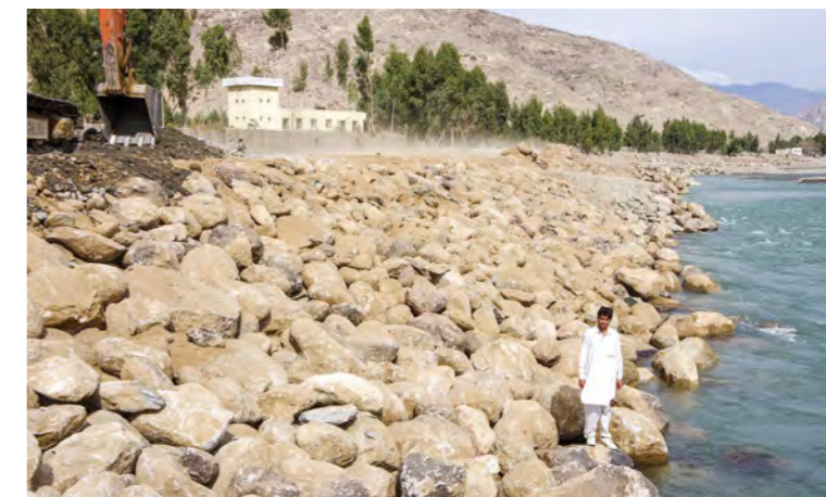
6.56 تصویر : د تیره ډکو جوړولو لپاره ډبرین موادو ځای پرځای کول (د میران استحکامی کارونو د پیل له نقطې په سل مترې کې) : 12 February 2015
