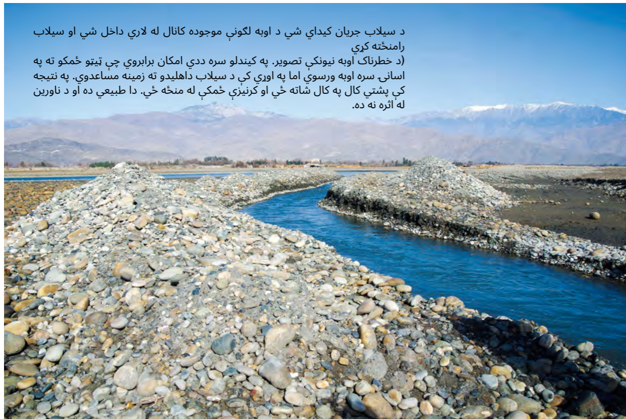
3.3 تصویر: ساده اوبه نیونکې چې د سیلاب اوبو ته یی لار برابره کړی
