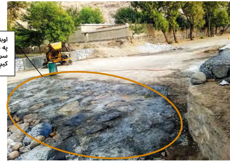
4.20 تصوير: د سيلاب تيريدونکې پل د سلب او د ځمکې اتصال نقطه 1
