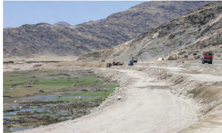
6.27 تصویر : د سیپیج شوی اوبو پواسطه د مایلو ډکو لاندې یو جبهه زاړه ساحه جوړېږي (لاندینې کین طرف ته) (د مروارید اوبو لگولو عمومي کانال Q2 ذخیره) : June 28, 2009
