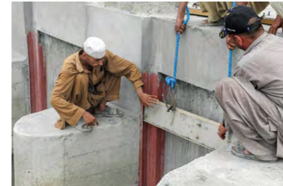
شکل : د 5cm په ضخامت اوسپنیز پلیټ ځای پر ځای کېږي او چنگک پکې ویلډینګ کېږي. د رسی په پای کې یو چنگک ځورند کېږي او د تختې د پورته کوونکې وسیلو په واسطه پورته کېږي. 11
