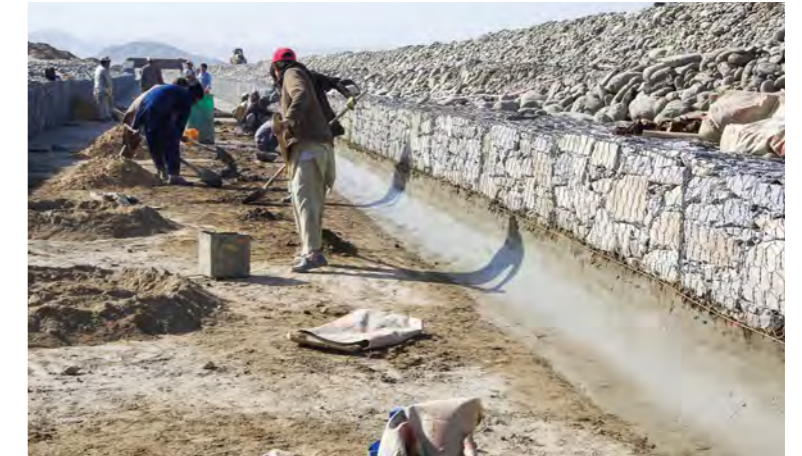
6.33 تصویر : د اوبو لگولو اساسي کانال په بستر کې د کونجونو ډکول د خاورې او سیمنټ مخلوط پواسطه (مروارید II د اوبو لگولو اساسي کانال) 1 : December 24, 2016
