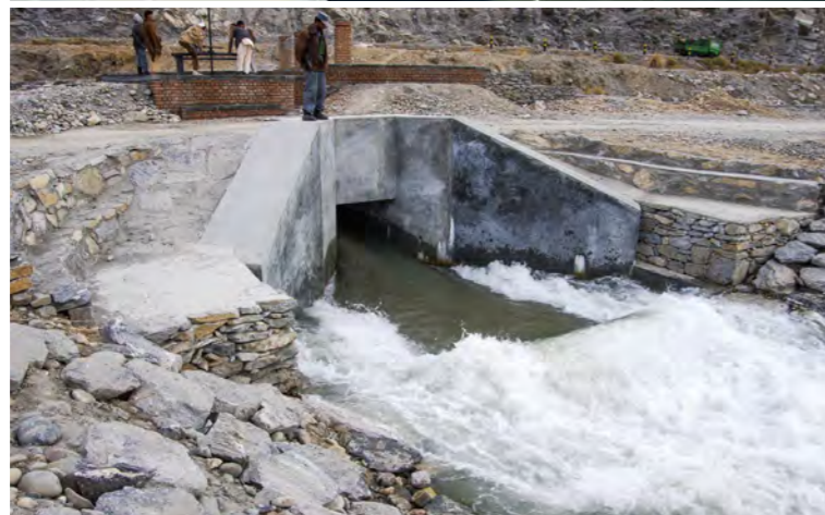
4.18 تصویر: د شگو حوض تخلیه کوونکې خوله او تخلیه کېدونکې جریان 8
