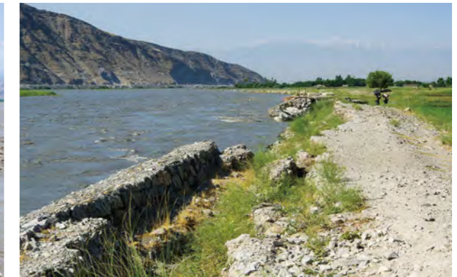
7.10 تصویر : د سیلاب د جریان له اثره د سیند د پشته رژیدنه 1
