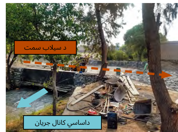
4.53 شکل : د سیلاب تیریدونکې نقطه کې د سیلاب تیریدونکې پل جوړونه ۱۲
