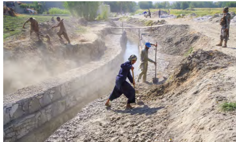
6.51 تصویر : ځمکې تحکیم کاري د اساسي اوبه ایستونکې مجرا په پورتنۍ برخه کې : 1 September 28, 2017
