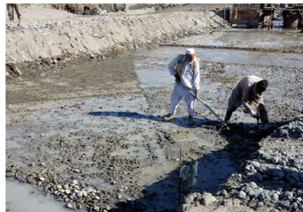
4.13 تصویر : د خاورې سیمنټو په واسطه د کار خاتمه ۳
