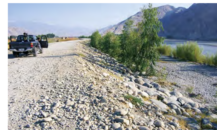
تصویر 6.54: محافظت دکه ها با استفاده از پوشش گیاهی (تحکیمات سواحل دریا) 1 : October 24, 2012
