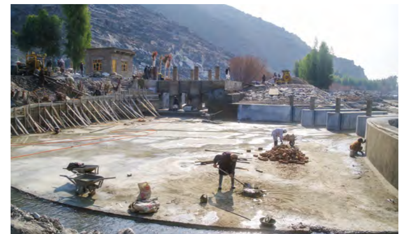
تصویر 6.19: کار های ساختمانی دروازه آبگیر، مجرای تخلیه ریگ و حوضچه رسوبی (دروازه آبگیر سربند کامه) 11 ؛ January 22, 2019
