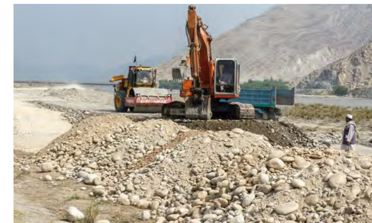
تصویر 6.52: کندنکاری، هموار کاری و تپک کاری مواد خاکریزی (تحکیمات سواحل بهسود) 1 : October 13, 2010
