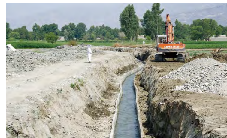
تصویر 6.50 : جابجا سازی کانال U-شکل در کانال زهکشی (کانال اصلی زهکشی گمبیری) 1 : July 23, 2016
