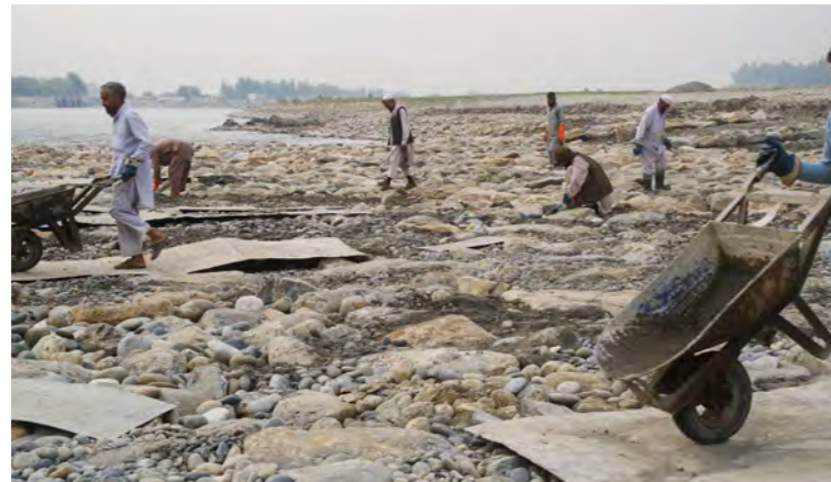
تصویر 6.7: انتقال سنگریزه ها به منظور پرکاری خلا (سربند 1 کامه)؛ October 31, 2018
