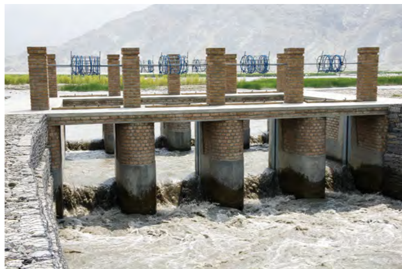
تصویر 7.1: دروازه آبیگیری نوع دو تخته یی. آب سرریز به ترتیب به پایین سرازیر می شود [1]
