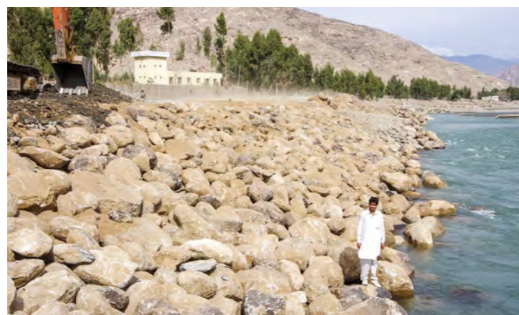
تصویر 6.56: ریختن مواد سنگی به منظور اعمار دکه موج شکن سنگی (صد ها متر از نقطه شروع تحکیمات در ساحه میران) 1 : February 12, 2015
