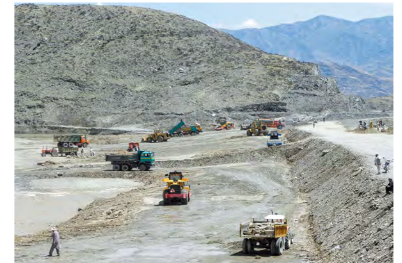
تصویر 6.26: ماشین آلات سنگین، دمترک ها، وکارگران مصروف در خاکریزی دکه (کانال اصلی آبیاری مروارید، مخزن Q2) (1) May 6, 2009
