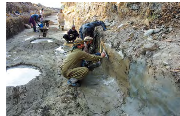
حالات قشر سازی در کانال آبیاری
