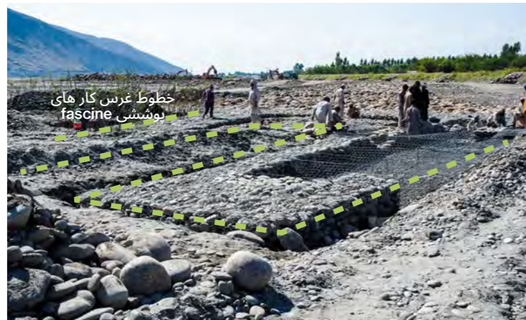
تصویر 6.11 : کار های گابیونی و کار های پوششی fascine (حصیر) به منظور محافظت از شاخاب (میران) 1 : October 22, 2015
