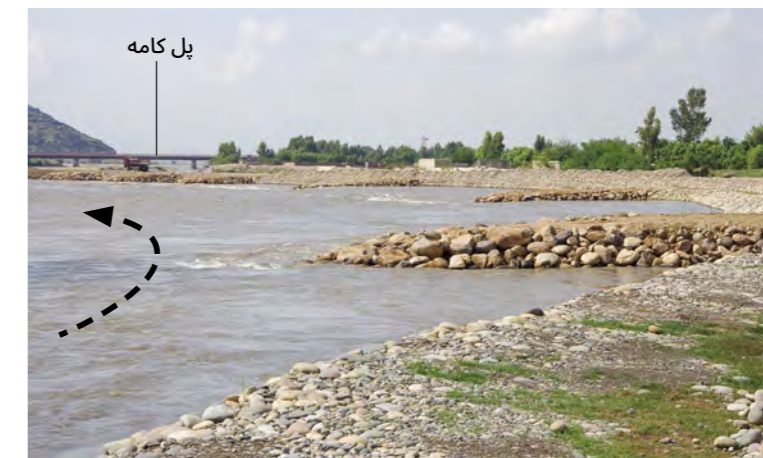
تصویر 6.58: جریان دریا در قسمت ساخته شده دکه موج شکن سنگی در قسمت خمیده که بیشترین شدت فرسایش را دارد کاهش می یابد (میران) (1) April 20, 2015:
