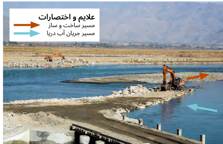
تصویر 6.5: تعیین موقعیت سربند مایل با استفاده از سنگ بولدر (سربند دوم مروارید)؛ October 16, 2018
