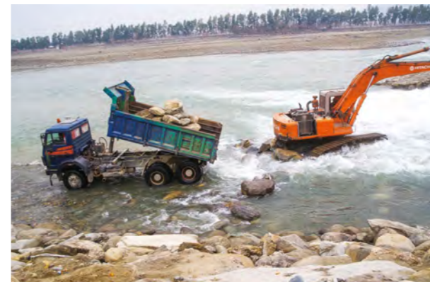
تصویر 7.9 : فعالیت های ترمیمی بستر شستشو شده ای دریا به دلیل وجود جریان شدید سیل در انتهای پل و مجرای تخلیه ریگ 1
