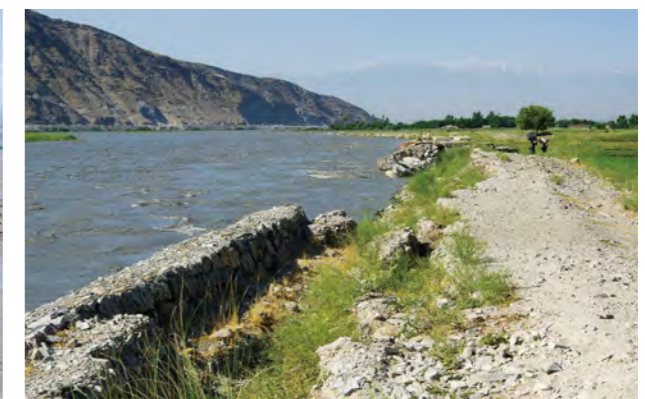
تصویر 7.10 : فرسایش حاشیه دریا به دلیل جریان سیلاب 1
