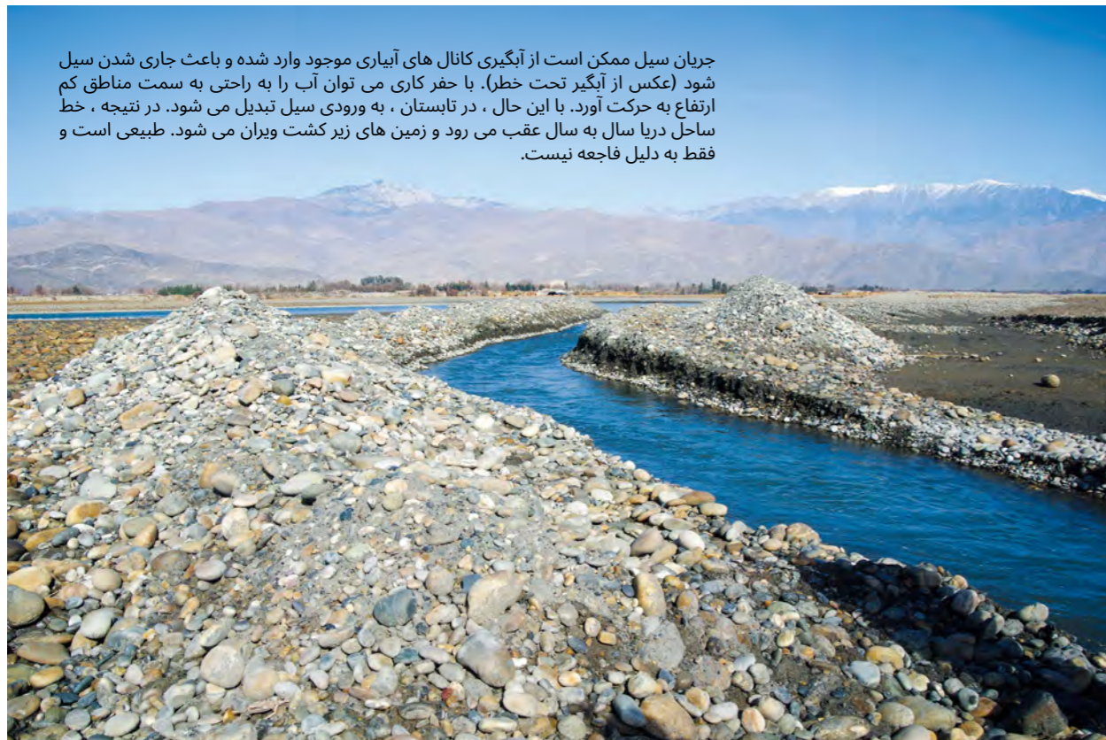
تصویر 3.3: نمونه ای از آبیگر آب که باعث ایجاد سیل رو شده
