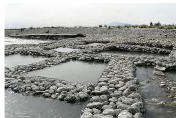
تصویر 4.5: اتصال شبکه گایون در کار های تحکیماتی کف (سربند II کامه)
