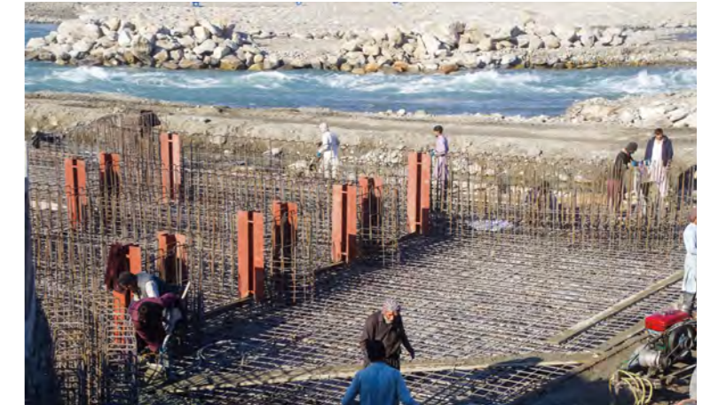
تصویر 6.21 : تقویت آهنکانکریتی سلب تحتانی و اسکله های دروازه (ترمیمات مجرای تخلیه ریگ، سربند I کامه) 1 : December 25, 2018
