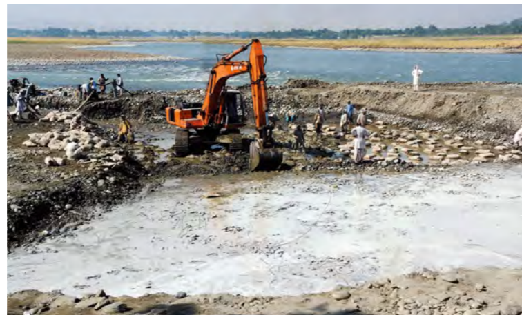
تصویر 6.20: ساخت و ساز تهداب فرشی در ضخامت 0.5m یا بیشتر (مجرای تخلیه ریگ سربند دوم مروارید) 11 ؛ October 17, 2016
