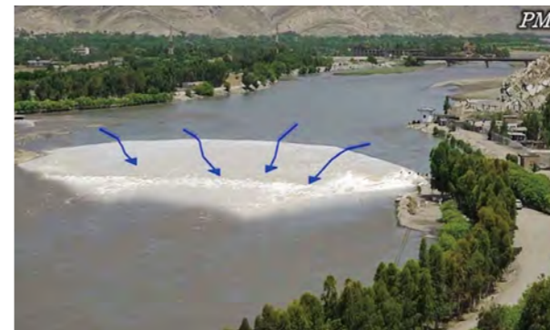
10. تکمیل نمودن کار های سربند مایل سنگی: اخذ آب به شکل پایدار می تواند با بالا بردن سطح آب در سربند آبیگر محیا گردد. (سربند اول کامه)
