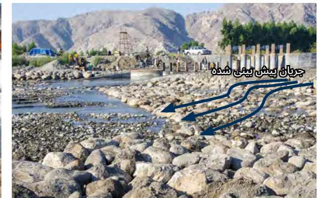
تصویر 7.8 : نو آوری برای کاهش فشار آب از بالای سربند 1
