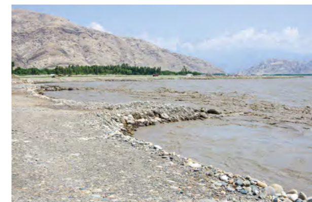
تصویر 7.11 : تقویت حاشیه دریا و تنظیم مجرای آب با استفاده از دکه های موج شکن 1
