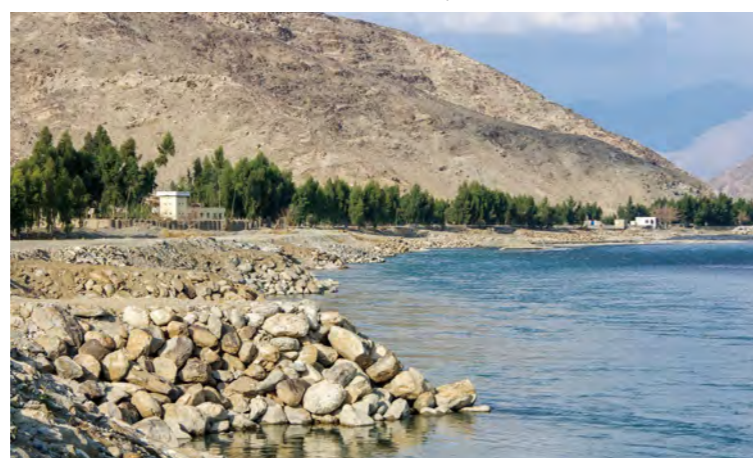
تصویر 6.57: امور ساختمانی یک گروپ از دکه موج شکن سنگی (میران) 1 : January 24, 2015
