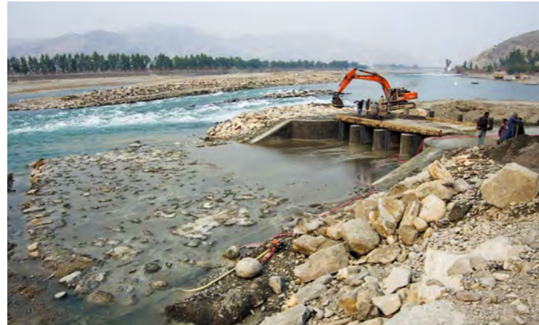
تصویر 6.24 : محافظت پیش بند و بستر مجرای تخلیه ریگ در پایین دست (مجرای تخلیه ریگ سربند II کامه) 1 : January 17, 2018
