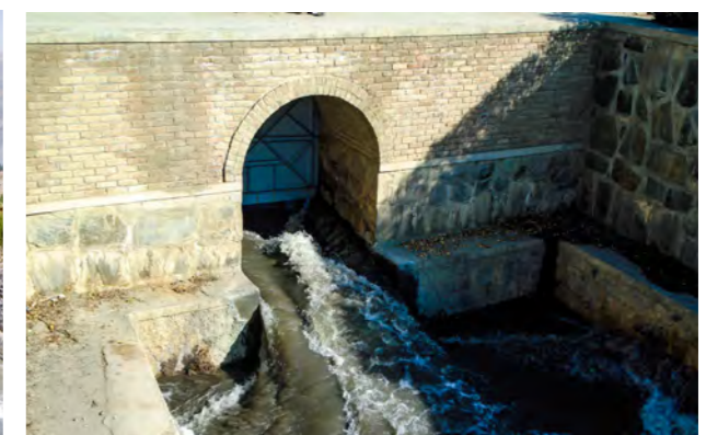
دروازه زهکشی، برونفت
