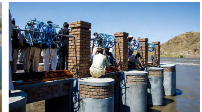
11. بررسی عملکرد تجهیزات: عملکرد درب تخته پی دوجداره و تجهیزات بالابر دروازه آبیگری و مجرای تخلیه ریگ بررسی می شود (سربند خاشکوت).
