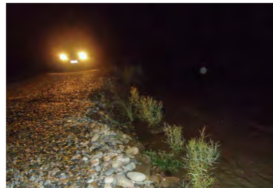
فعالیت های جلوگیری از فرسایش با استفاده از سنگ های بولدر در جریان شب انجام شد. فعلاً تمام سطح دکه مرتفع گردیده. 17 جولای، 2015 ، 7:30 شام
