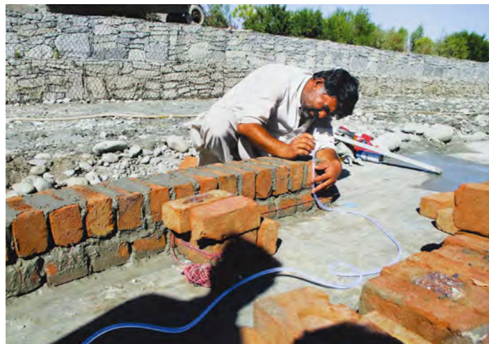
شکل 3.11: نمونه های اندازه گیری فاصله ، عمق و هم سطح سازی توسط سروی ساده
