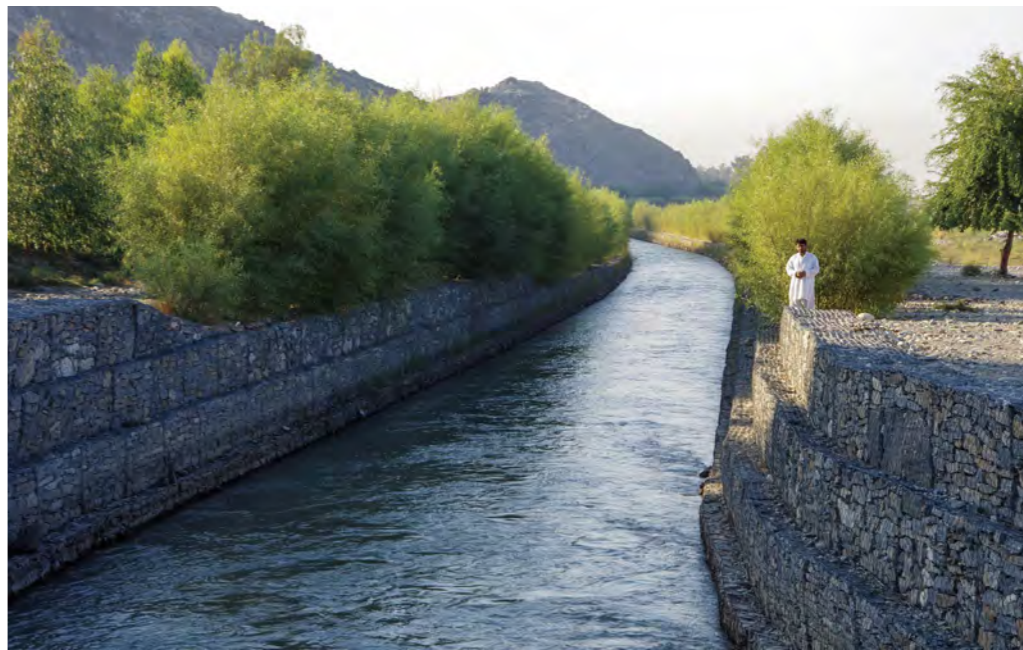
تصویر 4.8: مثالی از کارهای گابیونی و حصیری در کانال اصلی آبیاری (3)
