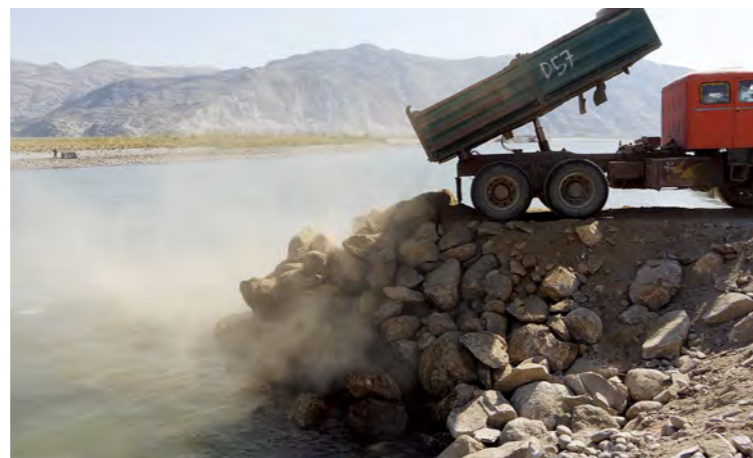
تصویر 6.55: ساخت و ساز تهداب دکه موج شکن (میران) 1 : October 22, 2014
