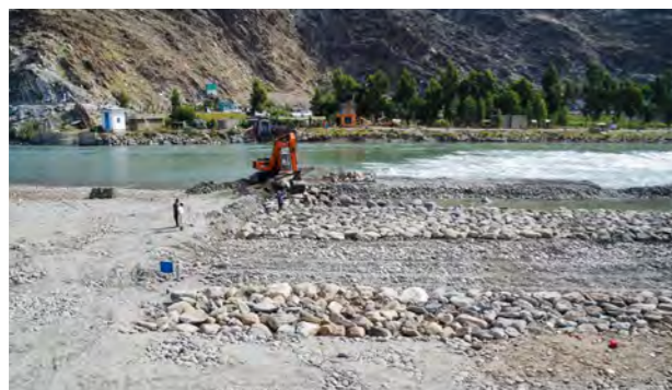
8. فعالیت های اساسی انجینری سیول: اعمار سربند آبگیر توسط انباشتن سنگ های دریایی بولدر از دو ساحل دریا. (سربند اول کامه).
