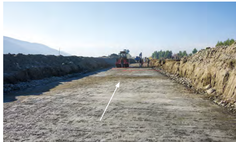
تصویر 6.31: کارهای مرتبط به قشر سازی با خاک و سمنت در بستر راه (کانال اصلی آبیاری) 1 : December 11, 2014
