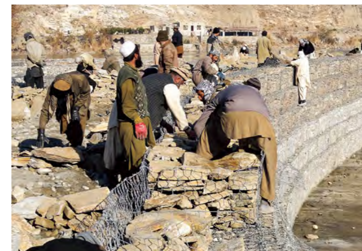
شکل 1.7: گابیون کاری در کانال آبیاری ۱
