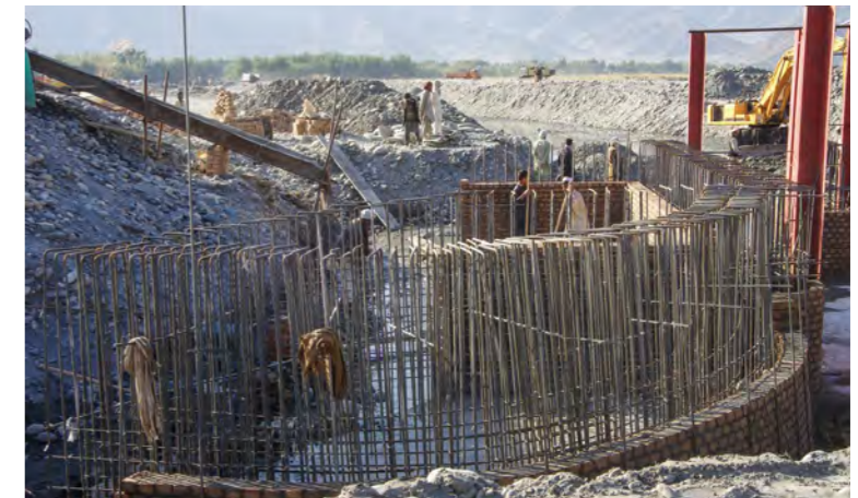
تصویر 6.18: تحکیمات کانکریتی با استفاده از آهنکاکریت (دروازه آبگیر خاشکوت) 11 ؛ November 7, 2012
