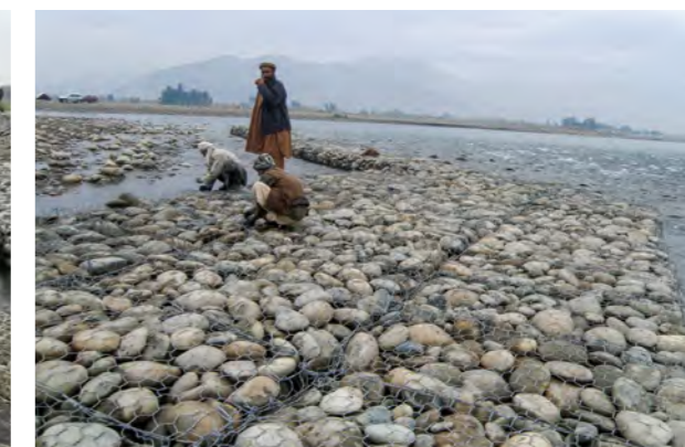
تصویر 4.4: کار های تحکیماتی کف در شاخاب (سربند I کامه)
