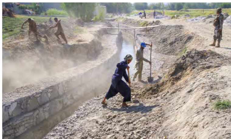
تصویر 6.51 : تحکیم کاری زمین در قسمت فوقانی کانال اصلی زهکشی (کانال اصلی زهکشی گمبیری) 1 : September 28, 2017
