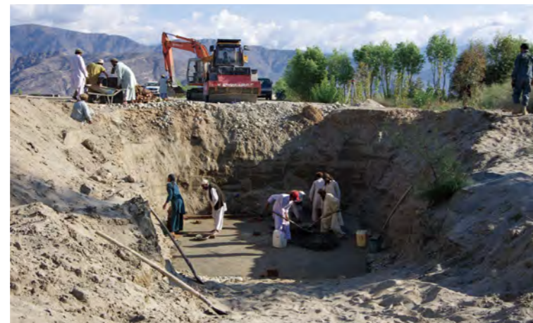
تصویر 6.44 : امور ساختمانی تهداب قسمت دخولی سیفون (کانال مروارید، سیلرو گمبیری) 1 April 10, 2012 :
