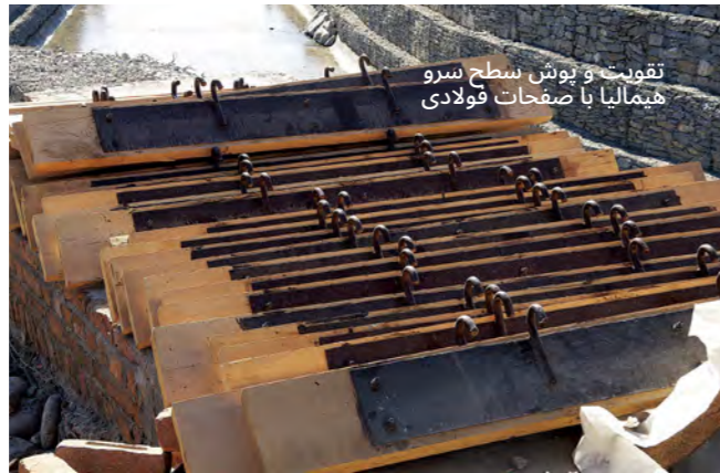
شکل 1.2.1 : درب تخته یی با سرو همپالیایی تقویت شده
