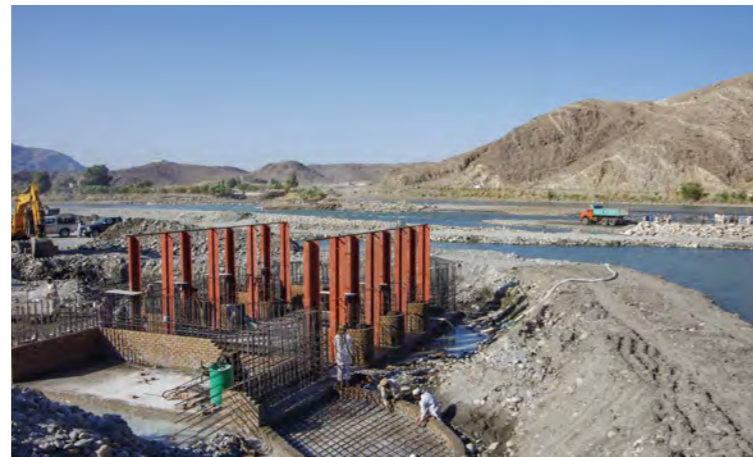
تصویر 6.16 : تقویت اسکله دروازه و روش ساختمانی خشک با استفاده از دکه انسدادی موقتی ، اعمال شده در ساخت دروازه آبیگیری (دروازه آبیگیری خاشکوت) ۱۱ : November 4, 2012
