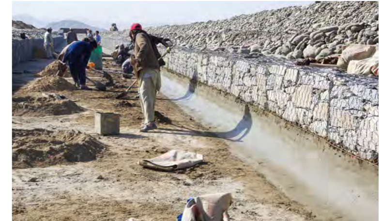
تصویر 6.33: پرکاری کنج های بستر کانال اصلی آبیاری با استفاده از سمنت و خاک (کانال اصلی آبیاری مروارید دوم) 1 : December 24, 2016
