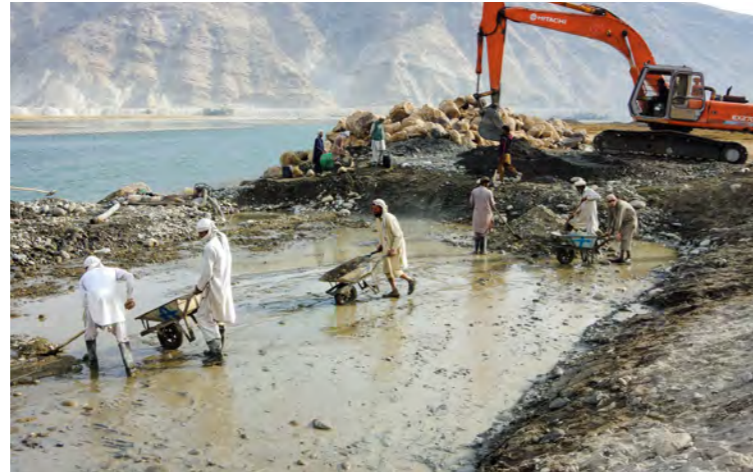
تصویر 6.14 : ساخت و ساز تهداب وسیع با ضخامت 0.5 متر یا بیشتر (دروازه آبیگیری میران) ۱۱ : November 24, 2014
