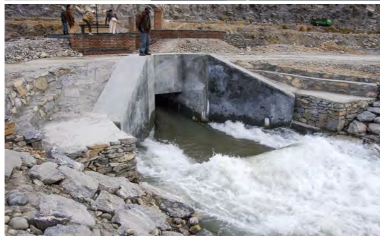
تصویر 4.18: خروجی دروازه تخلیه حوض ترسب ریگ و خروجی دروازه تخلیه آب از حوض ترسب ریگ 1
