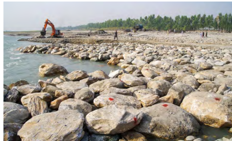
تصویر 6.6: سنگ ها با علائم ارتفاعی ان، به منظور انبار نمودن سنگ های بولدر (سربند 1 کامه)؛ October 29, 2018
