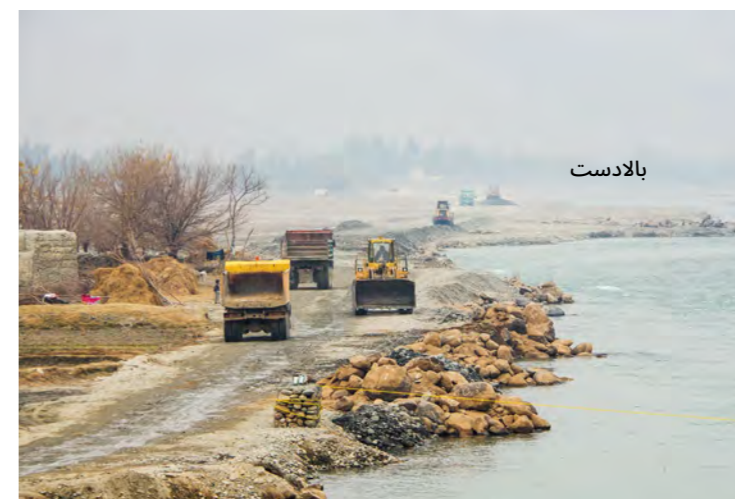
تصویر 5.3: تاج دکه به عنوان جاده دسترسی استفاده شده است 1)
