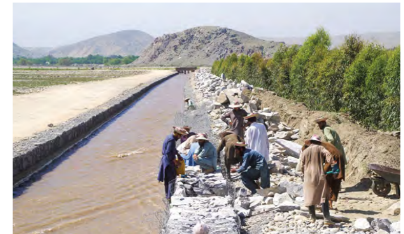
تصویر 6.34: بسته بندی و جابجا سازی گابیون ها (لایه فوقانی) (کانال اصلی آبیاری مروارید دوم) 1 : April 8, 2019
