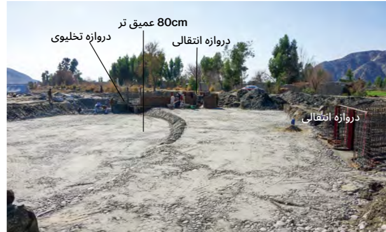
تصویر 6.47: ساخت و ساز کف حوض ترسب ریگ (میران) 1 : January 29, 2015
