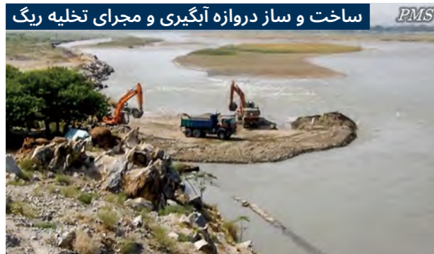
4. فعالیت های موقتی : یک دکه موقتی مدور ، در چهار اطراف مکان پیشنهادی سربند آبگیر، مجرای تخلیه ریگ و حوض ترسب ریگ ساخته می شود. (سربند دوم مروارید)
