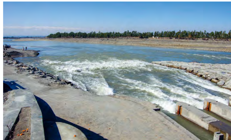
تصویر 6.25 : قاعده سازی محافظت پیش بند و بستر مجرای تخلیه ریگ در پایین دست (مجرای تخلیه ریگ سربند II کامه) 1 : February 12, 2019
