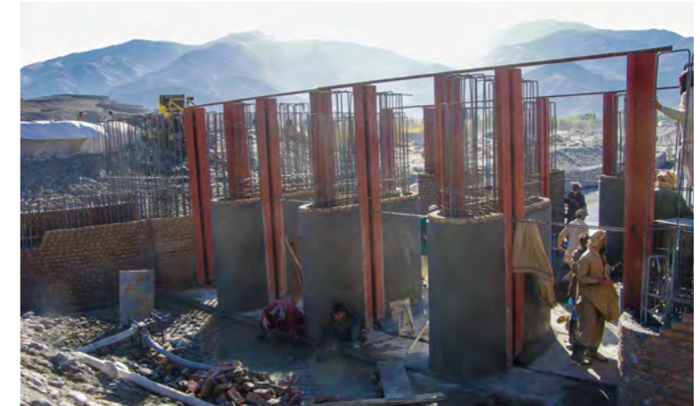
تصویر 6.17: تقویت آهنکاکریتی سازه اسکله دروازه و نصب چینل های دروازه (دروازه آبگیر خاشکوت) 11 ؛ November 15, 2012
