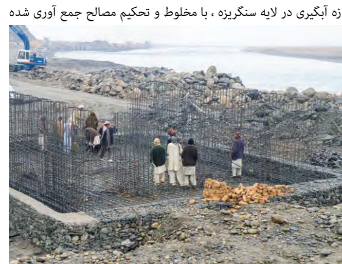
تصویر 4.6: دروازه آبیگری تحت ساخت : ساخت یک تهداب آهنکانکرت تقویت شده 11
