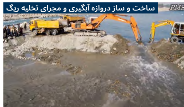
7. برطرف نمودن ساختمان های موقتی: بعد از تکمیل شدن فعالیت های ساختمانی مجرای تخلیه ریگ و سربند آبگیر، دکه موقتی باید برداشته شود تا آب در ساحه احاطه شده جریان پیدا کند (سربند اول کامه).
