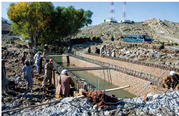
تصویر 7.15: تداوم کار های فوقانی پل عبور سیل (چپ) و بعد از اتمام (راست) ۱
