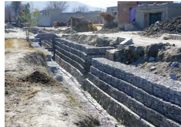
تصویر 4.22: دیواره نگهدارنده قسمت فوقانی کانال اصلی زهکشی (۱)
