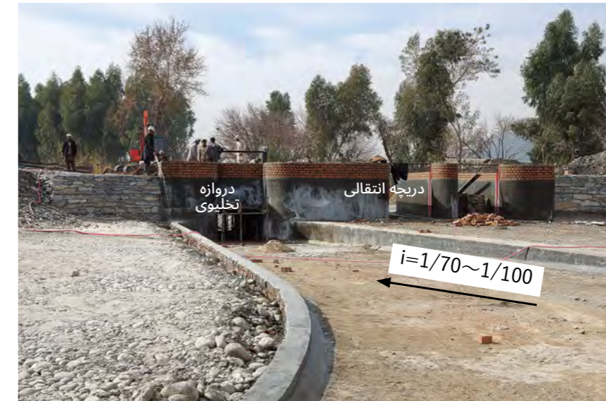
تصویر 4.17: کانال کانکریتی تخلیه ریگ در کف حوض ترسب ریگ و دریاچه تخلیه 3
