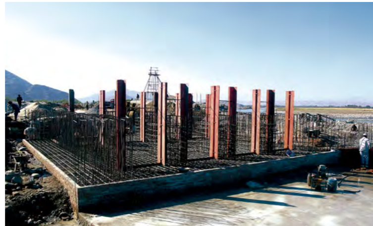
تصویر 6.15 : امور قالب بندی توسط خشت (دروازه های آبیگیر پروژه II مروارید) ۱۱ : November 8, 2016
