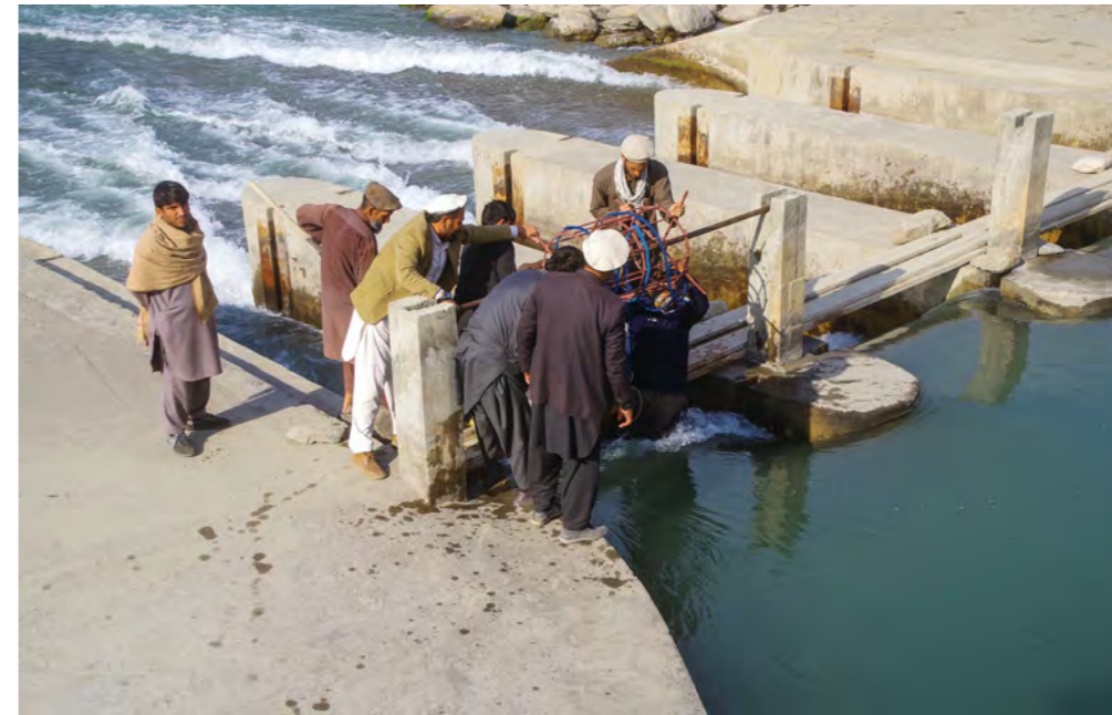
تصویر 4.7: دفع ریگ با استفاده از درب دو تخته‌یی (دوجداره) ۱۱
