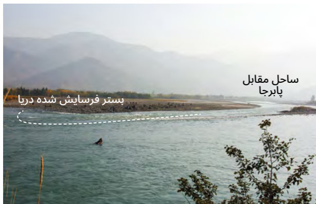
تصویر 2.6: موردی که در آن یک شاخاب متشکل از سنگ های بولدر توسط سیلاب از بین برده شد (سربند مروارید)
