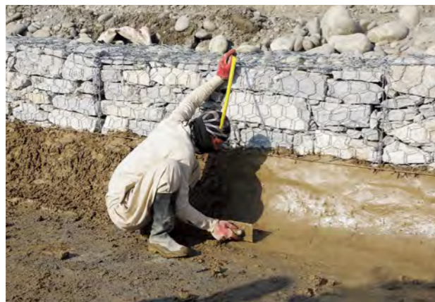
تصویر 4.14: گوشه کانال پر شده توسط سمنت و خاک (3)
