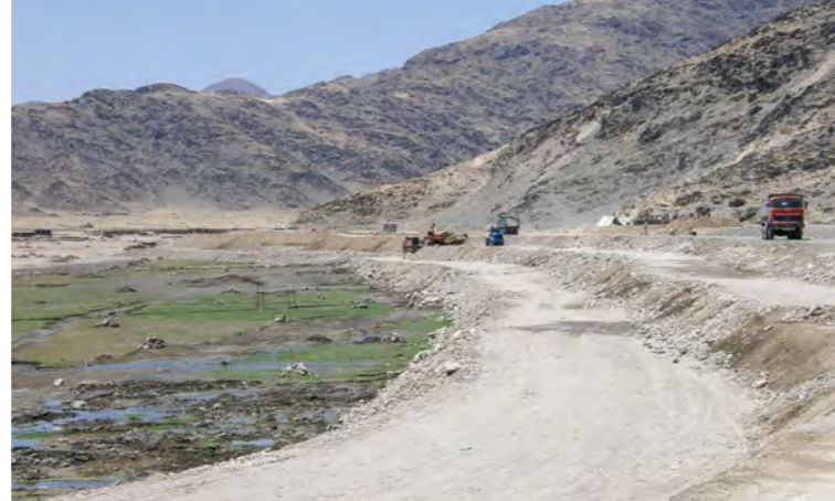
تصویر 6.27: از اثر تراوش آب (seepage) در قسمت پائین تر خاکریز دکه تالابی تشکیل گردیده (سمت پایین چپ) (کانال اصلی آبیاری مروارید مخزن Q2) (1) June 28, 2009
