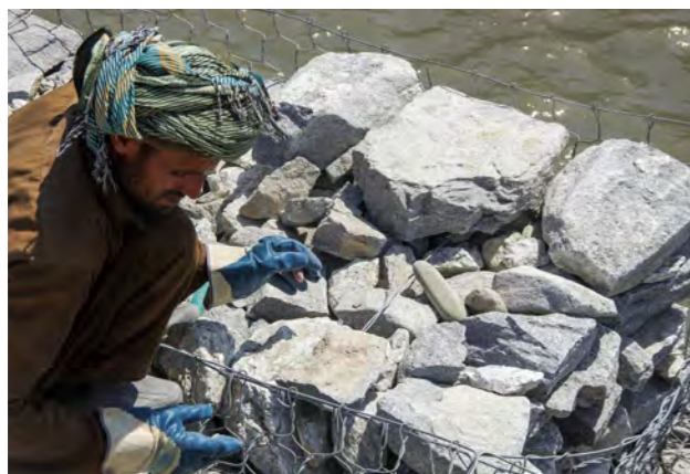
شکل 4.36: نحوه پر کردن مواد سنگی در گابیون 3
