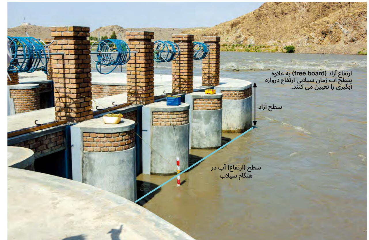
تصویر 3.6: رابطه سطح آب و ارتفاع بالای دروازه های آبگیر در هنگام سیلاب 11
