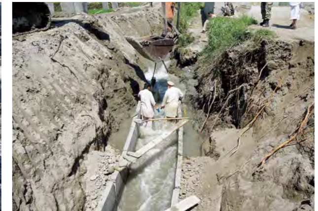
تصویر 4.21: استفاده از کانال کانکریتی U شکل پیش ساخت (۱)
