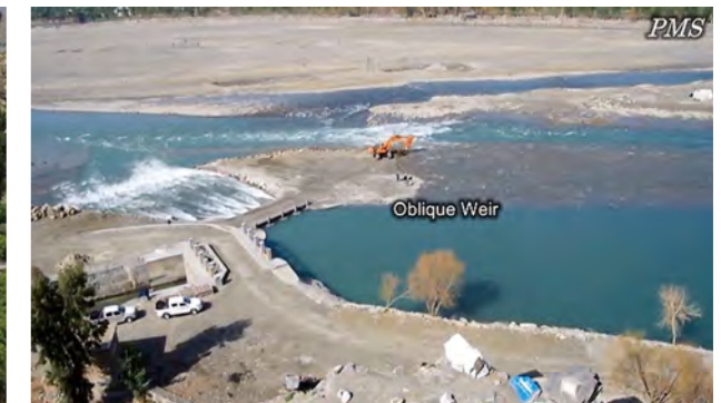
9. هنگامی که سطح آب در فصل کم آبی پایین است، یک پرچاوه ساخته می شود (سربند دوم کامه).
