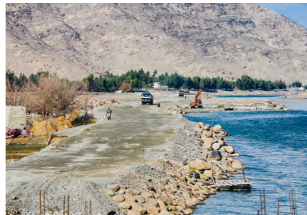
تصویر 6.1 : استفاده از یک دکه منحیث راه موقت (پروژه میران) "
