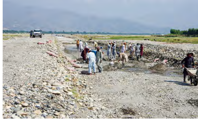
تصویر 6.30: امور ساختمانی قشر سازی با خاک و سمنت و سایر امور ساختمانی مرتبط به بستر کانال (کانال اصلی آبیاری مروارید دوم) 1 : April 27, 2017
