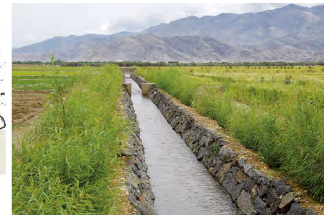
تصویر 4.23: نمونه ای کانال آبیاری با استفاده از سنگ کاری (۳)
