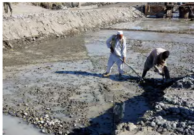
تصویر 4.13: پایان کار با پوشش سمنت و خاک (3)
