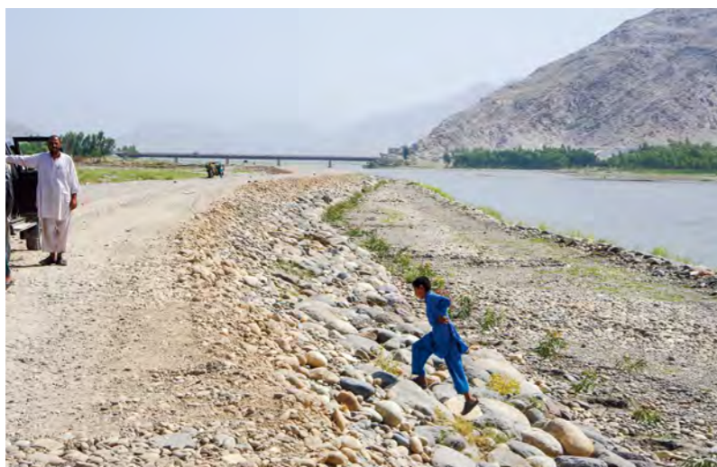
تصویر 5.1: سنگ کاری stone pitching در دکه مسلسل، برم کوچک و میلان فوقانی آن 2
