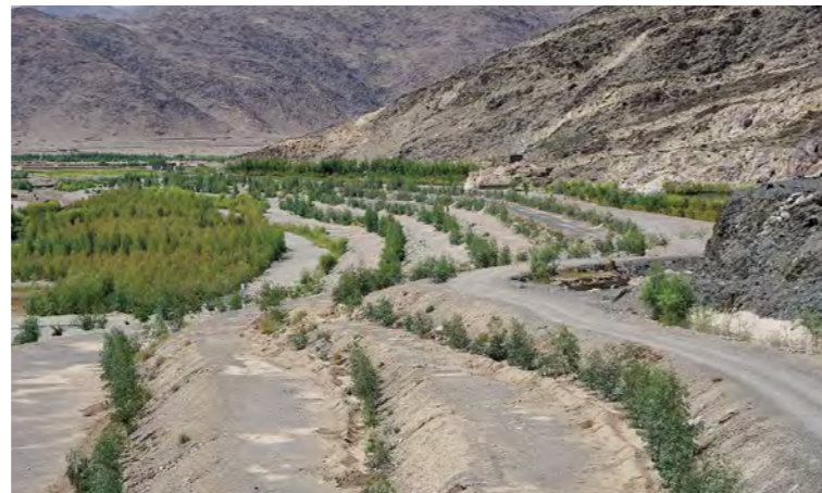
تصویر 6.29: تقویت میلان عقبی خاکریز مخزن آب با استفاده از درخت ابلیتس (کانال اصلی آبیاری مروارید، مخزن Q2) (1) September 19, 2011
