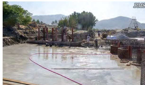
5. فعالیت های ساختمانی دروازه آبگیر ، مجرای تخلیه ریگ و حوض ترسب ریگ: انجام کار های تهداب، کار های اساسی سیول، کار های ماشین، کار های استحکامی و کار های دامن (پیش بند).
