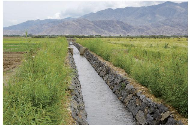
写真4.23 小水路壁の空石積み施工例<sup>3)</sup>
