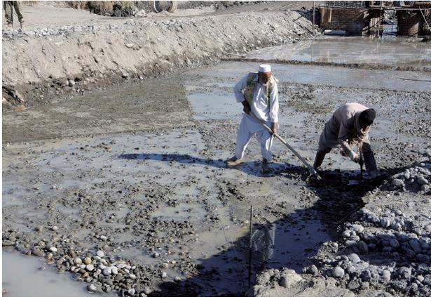
写真4.13 ソイルセメント・ライニングの仕上げ工事<sup>3)</sup>
