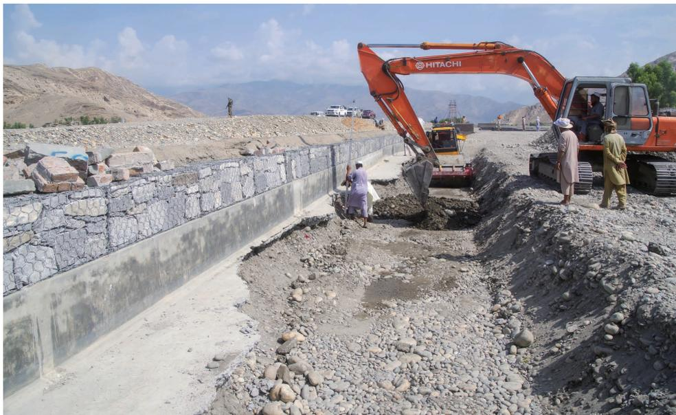
写真4.15 用水路床面の基礎が適切でなかったため、水路床が崩壊した例<sup>1)</sup>
