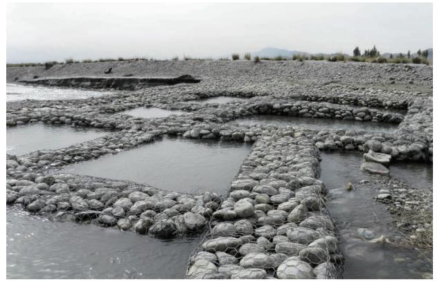
写真 4.5 根固め工の井形連結 (カマII堰)<sup>1)</sup>
