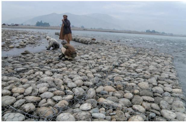
写真 4.4 砂州の根固め工 (カマI堰)<sup>1)</sup>
