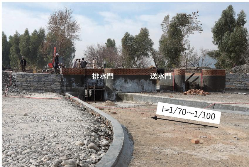
写真4.17 沈砂池底面のコンクリート排砂路と排水門<sup>3)</sup>
