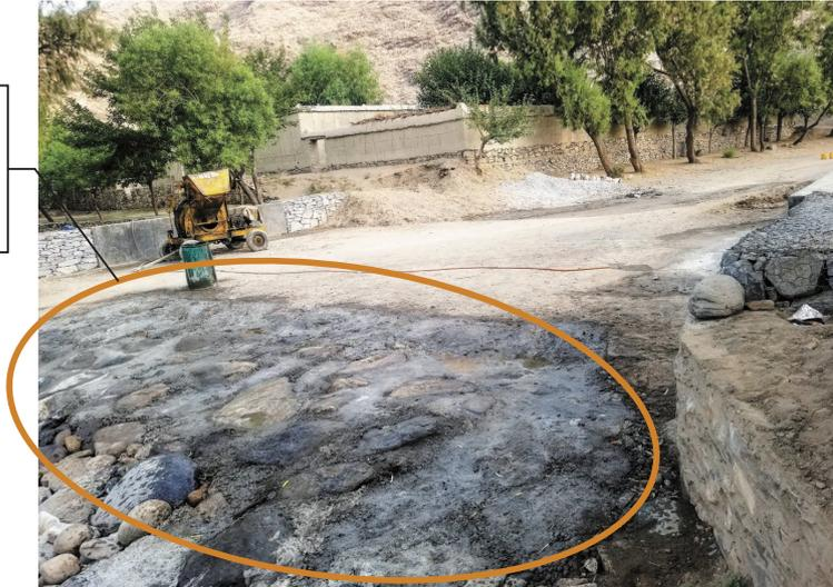
写真4.20 洪水通過橋のスラブと地面の接合部<sup>1)</sup>
