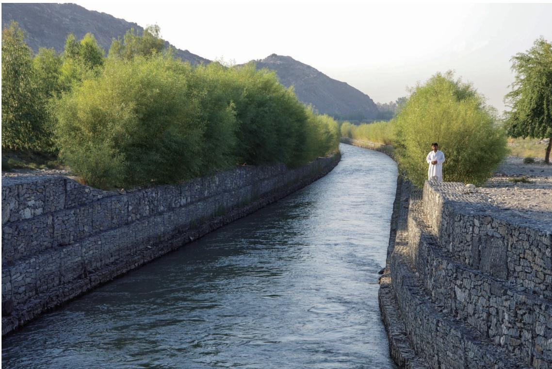
写真4.8 主幹用水路における蛇籠と柳枝工の施工例<sup>1)</sup>
