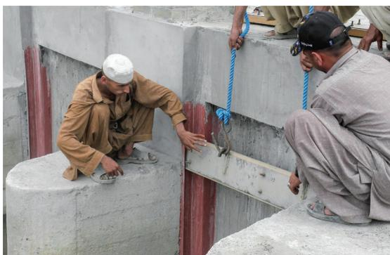
写真 5cm厚の板に鉄板を張りつけ、フックを溶接でつける。ロープの先の鉤を上手に引っ掛けて巻き取り器で引き上げる。<sup>1)</sup>
