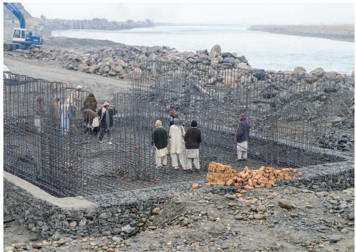
写真4.6 建設中の取水門：鉄筋コンクリート基礎工事<sup>1)</sup>
