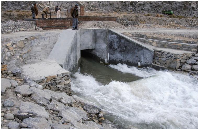
写真4.18 沈砂池の排水門開口部と流出部の写真<sup>1)</sup>
