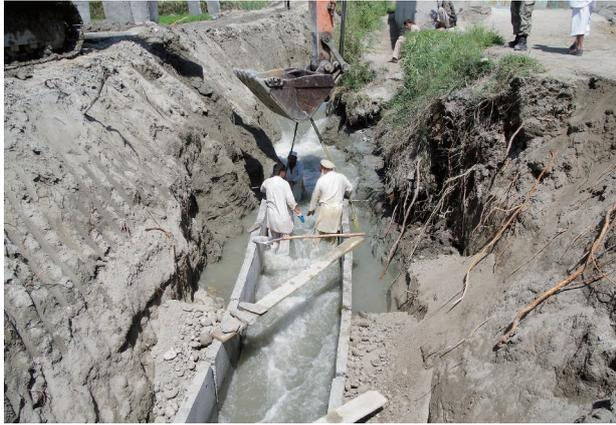
写真4.21 プレキャスト・コンクリートU字溝の設置<sup>1)</sup>
