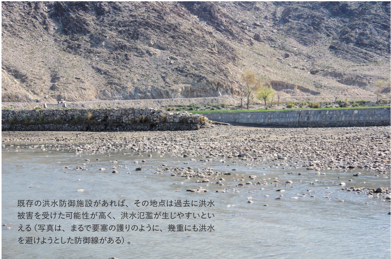
写真3.4 既存の洪水対策施設から洪水氾濫の可能性が想定できる事例写真 1)
