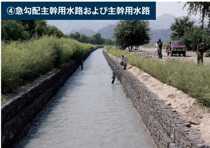
急勾配主幹用水路および主幹用水路の役割；急勾配主幹用水路は、取水門から取り入れた河川水に含まれる土砂を用水路に堆積させることなく沈砂池に導く。主幹用水路は、沈砂池で土砂が除かれた水を灌漑裨益地まで導水する。
