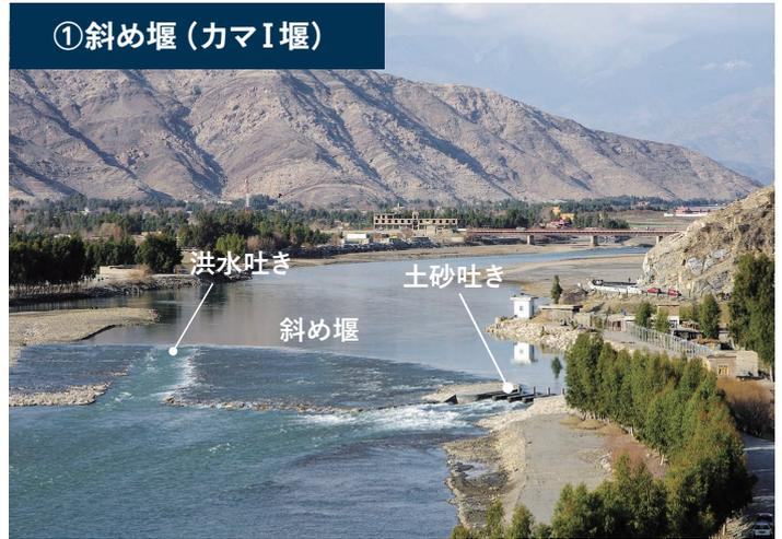
斜め堰の役割; 河川を横断的に堰上げて上流側の水位を上昇させ、渇水期の取水を容易にする。堰を斜めに延ばすことで越流水深が低くなり、掃流力が軽減され、堰が壊れにくくなる。
