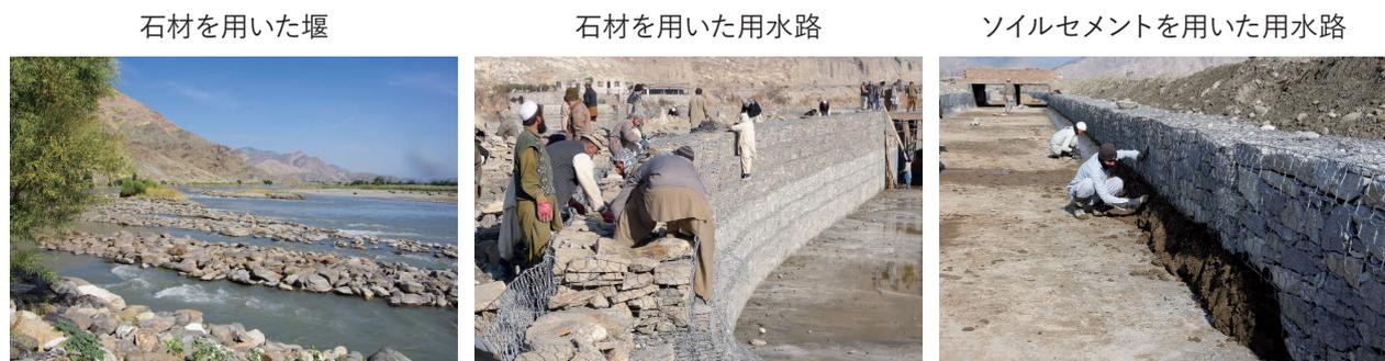
写真1.1 現地調達可能な自然資材（主に石材）を用いた灌漑施設<sup>1)</sup>
