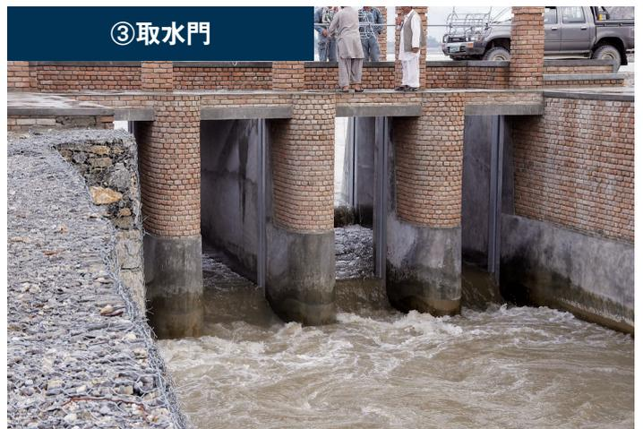
取水門の役割; 斜め堰の河岸袖部に設置され、取水堰で堰上げた水を主幹用水路に取り込むとともに、取水量調整を行う。堰板は、水門の前後に2列設置し、貯水槽をつくる。川側下段堰板にかかる水圧を減殺し、堰板が折れることを防ぐ。
