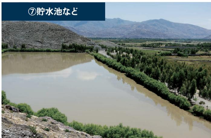
貯水池などの役割；山岳部からの洪水流や土石流から主幹用水路を守るため貯水池を設置する。乾燥地における保水力確保で、植生の生育に寄与する。土石流が既存の水路を横断する場合は、洪水通過橋を設置する。
