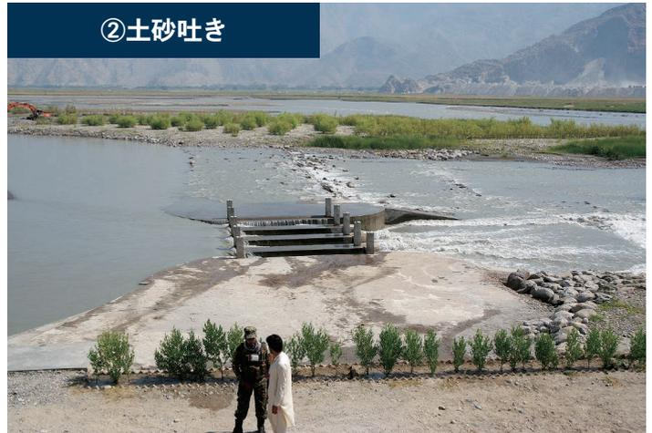
土砂吐きの役割; 取水門に隣接して取水堰の一部として設置され、取水門への土砂の流入を防ぐ。
