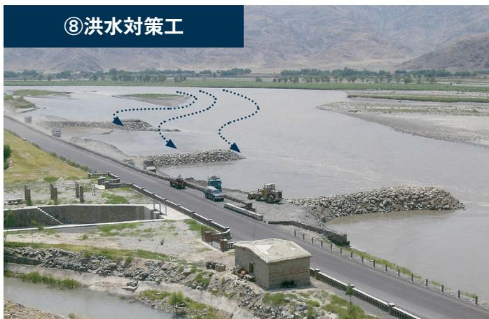
洪水対策工の役割；堤防は、灌漑受益地や住宅地および河川沿いの主幹用水路等を洪水から守る役割を果たす。石出し水制は、堤防や河岸の洗掘を防止するとともに、河道の滞筋固定の役割を果たす。
