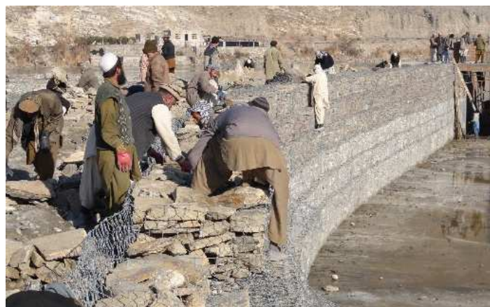
PMS 灌漑事業の基礎土木技術のひとつである蛇籠工を水路の側面に設置している
