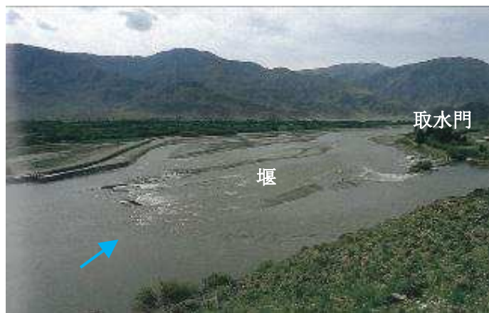
PMS 灌漑事業の巨礫積み斜め堰 (日本の伝統技術で作られた山田堰をモデルとしている)
