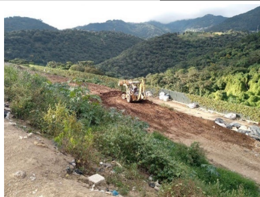
稼働中の衛生埋立地。本処分場の設計を行ったエンジニアは JICA 研修受講生。同処分場におけるコンパクション、覆土の実施状況。
