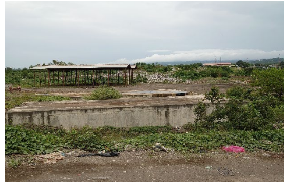
マナグア市最終処分場の水処理施設
