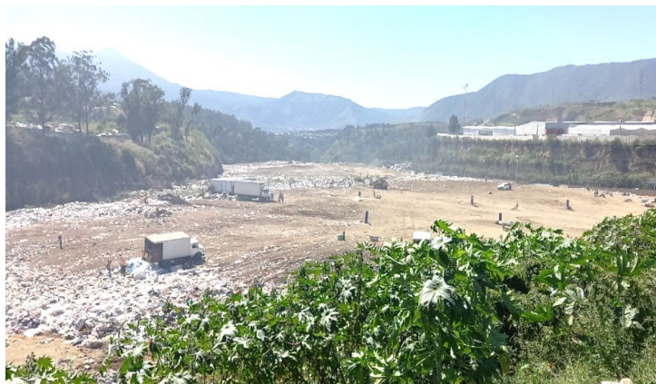
順次閉鎖が進む処分場。10年後を目途に公園を建設予定。
