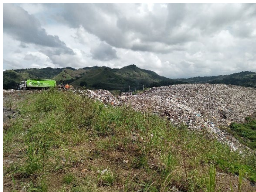
Cerro Patacon 処分場。斜面に位置するため運送トラックや重機の搬入が困難。場内アクセス道路は未舗装。場内のウェイトピッカーによる有価物回収の様子。
