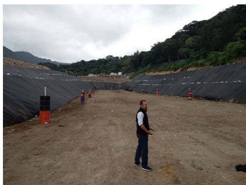
稼働中の衛生埋立地。本処分場の設計を行ったエンジニアは JICA 研修受講生。同処分場におけるコンパクション、覆土の実施状況。
